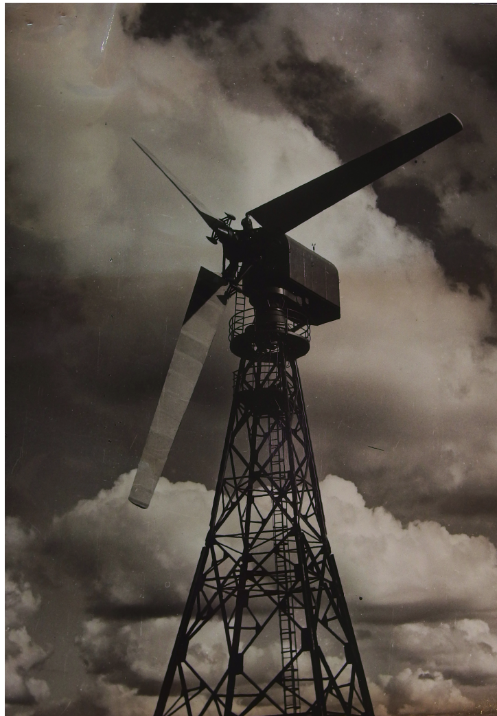
FIGURE 9.6 – Éolienne Néyrpic de Saint-Rémy-des-Landes de 132 kW, 1961. 65
