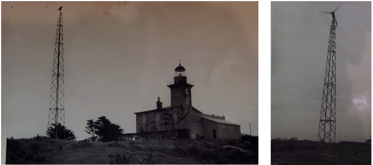
FIGURE 9.9 – Éolienne Jacobs de 1 200 kW sur pylône de 20 m alimentant le phare de Chausey (1949) 85
