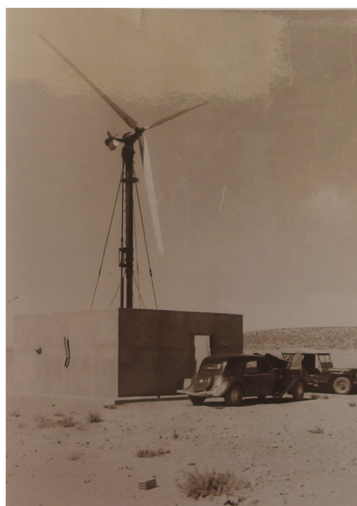
FIGURE 9.15 – Point d'eau de Bataillon d'Afrique muni d'une éolienne Allgaier (vers 1950) 161
