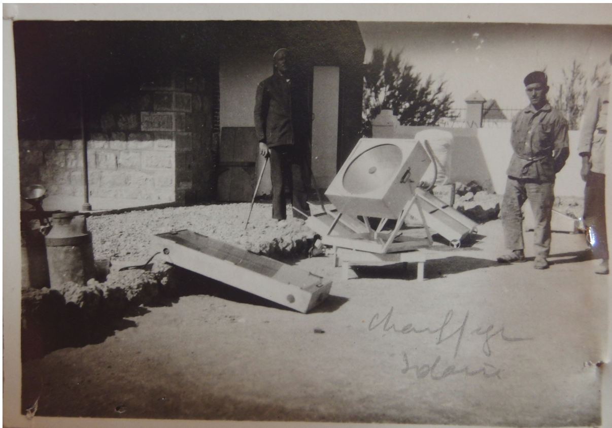
FIGURE 5.11 – Appareils de chauffage solaire de Pasteur : caisson chauffant et miroir parabolique (Colomb-Béchar, vers 1932) 67
