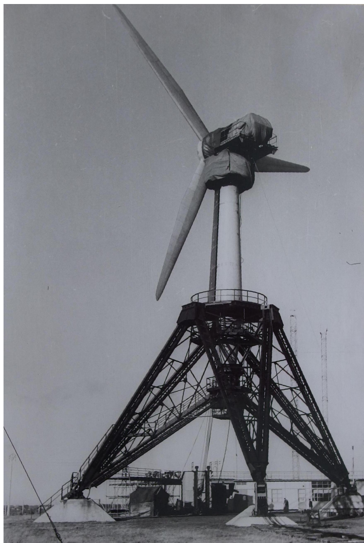
FIGURE 9.7 – Éolienne B.E.S.T de Nogent-le-Roi tout juste érigée (1958) 71
