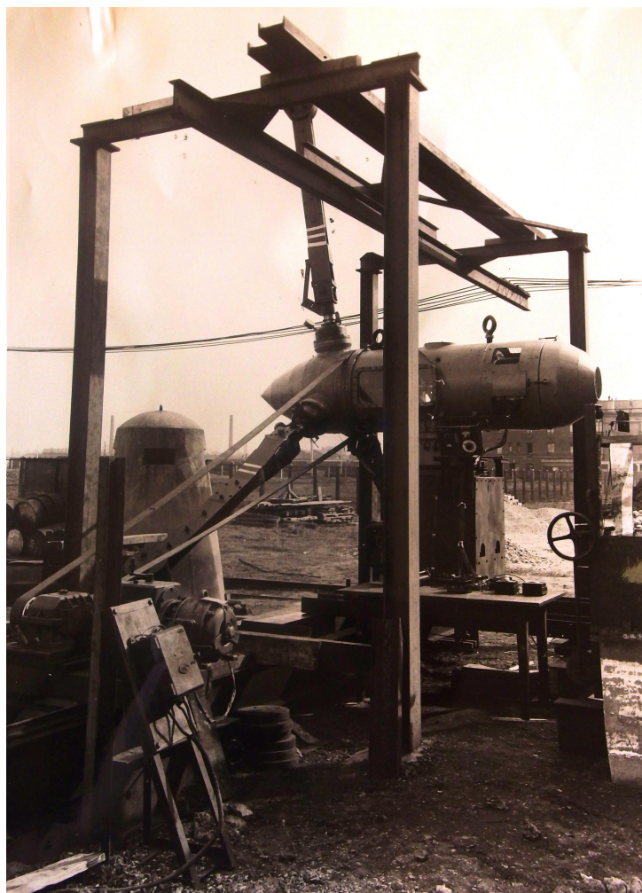
FIGURE 9.17 – Modèle réduit d’hélice tripale testé en 1950 aux ateliers de la Compagnie électro-mécanique (Le Bourget) 171
