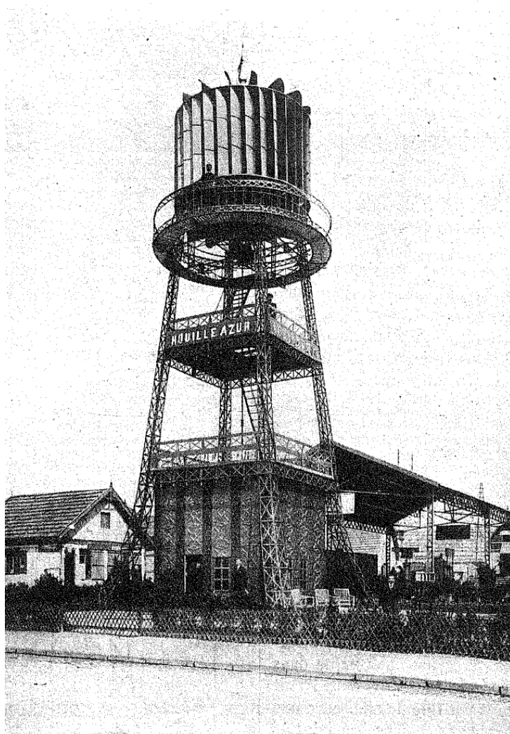
FIGURE 4.4 – Turbine Escaffre avec l’inscription « Houille azur » exposée lors de la Foire de Paris en 1920 (WEISS, 1920)
