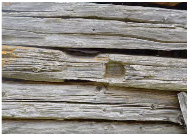
Figure 106 : sablière réemployée en maille de pignon dans le bâtiment CBO 500. On remarque également le trou prévu pour emboîter le gond d'une porte. Cl. V.Labbas.
