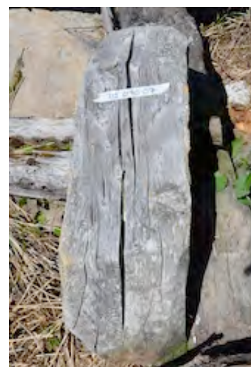
Figure 56 : Cale (ou chapeau) anciennement placée entre la poutre et le poteau du plancher. Cl. V. Labbas.
