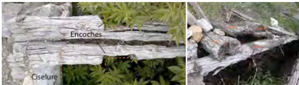
Figure 174 : Détail de mailles d'élévation réemployées en poutre de plafond (à gauche) et en lambourdes de plancher (à droite) dans le bâtiment BLA 300 (Blainon, vallon de Roya). Cl. et DAO de V. Labbas.
