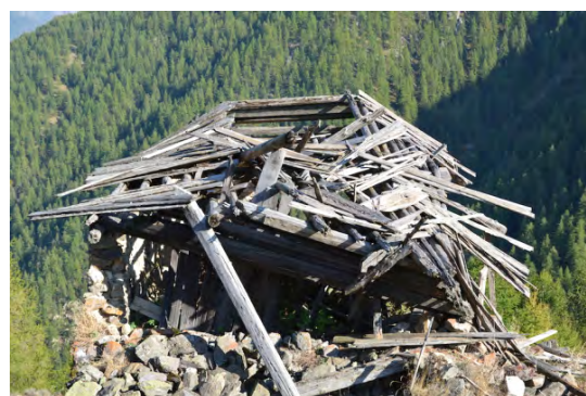
Figure 152 : Refend-formant-pignon en empilage sur une grange bâtie en maçonnerie (site de Pymia, commune d'Isola). Cl. de V. Labbas.
