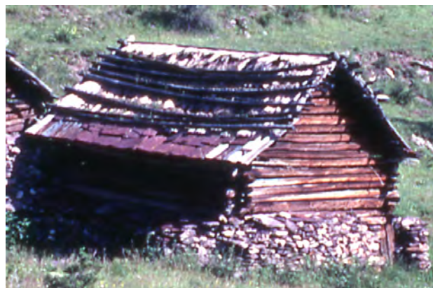
Figure 168 : Cliché des années 1970 attestant l'emploi de la paille sur une grange à Rougios conjointement à la lauze de pelites. Cl. G. Cheval.
