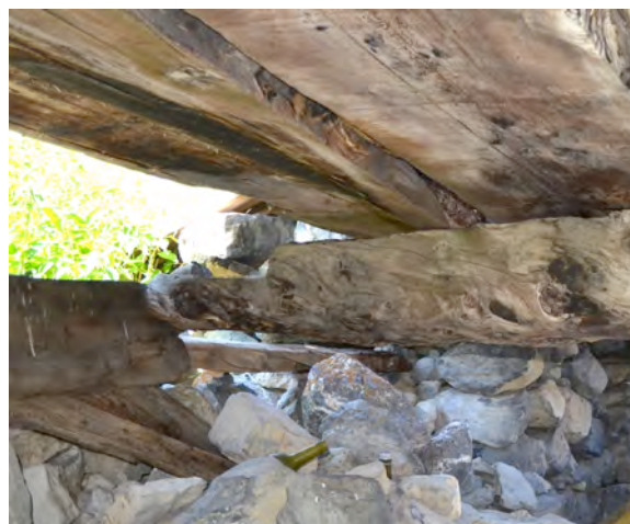
Figure 159 : Poutre de section circulaire du bâtiment RUS 200 (Vol.3, Saint Etienne-de-Tinée) dans le vallon de Roya. Une seule encoche à mi-bois permet l'emboîtement avec la sablière posée au dessus. Cl. V. Labbas.
