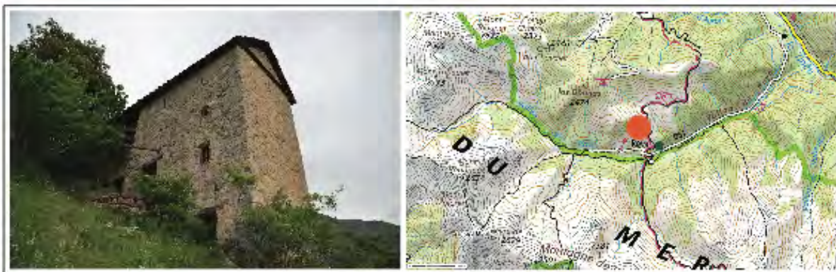
Figure 112 : Le bâtiment BLA 1100, vue du sud et position géographique sur carte IGN. DAO de V. Labbas
