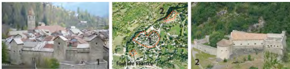
Figure 20 : Fortification de Colmars (à droite), vue aérienne (au centre, d'après IGN) et Fort Desaix (à droite). DA0 de V. Labbas.
