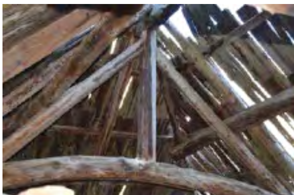
Figure 162 : Détail d'une ferme de la charpente du bâtiment LAU 100, vallon du Lau, Jausiers. Cl. de V. Labbas.
