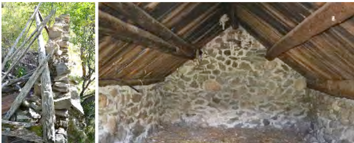
Figure 166 : Arbalétrier du XIXe siècle fixé sur une sablière du XVe siècle réemployée (à gauche) dans le bâtiment CBV 100. A droite, vue intérieure des pannes du XVIe siècle du bâtiment FT2 100. Cl. V. Labbas
