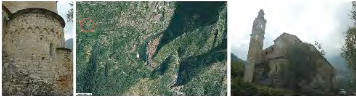
Notre Dame du Mont (Breil-sur-Roya, 06), Cliché du chevet roman et de l'édifice vue de l'est (cl. V.L) et vue aérienne (d'après IGN). DAO de V. Labbas.
