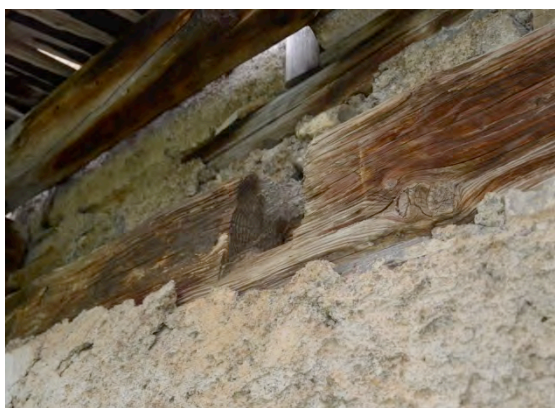
Figure 52 : Sablière remployée en R+1. Cl. V. Labbas.
