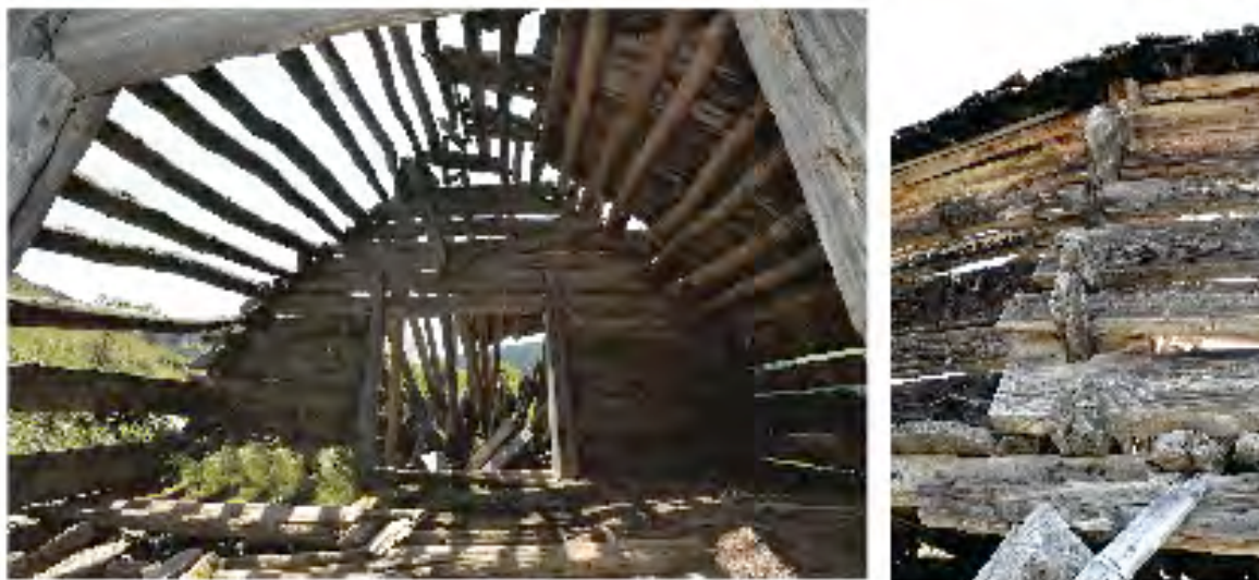
Figure 155 : Bâtiment LIB 100 (Liberture, Beuil). Le refend-formant-pignon vu de l'ouest (à gauche) et détail des emboitements vu du gouttereau sud (à droite). Cl. V. Labbas.
