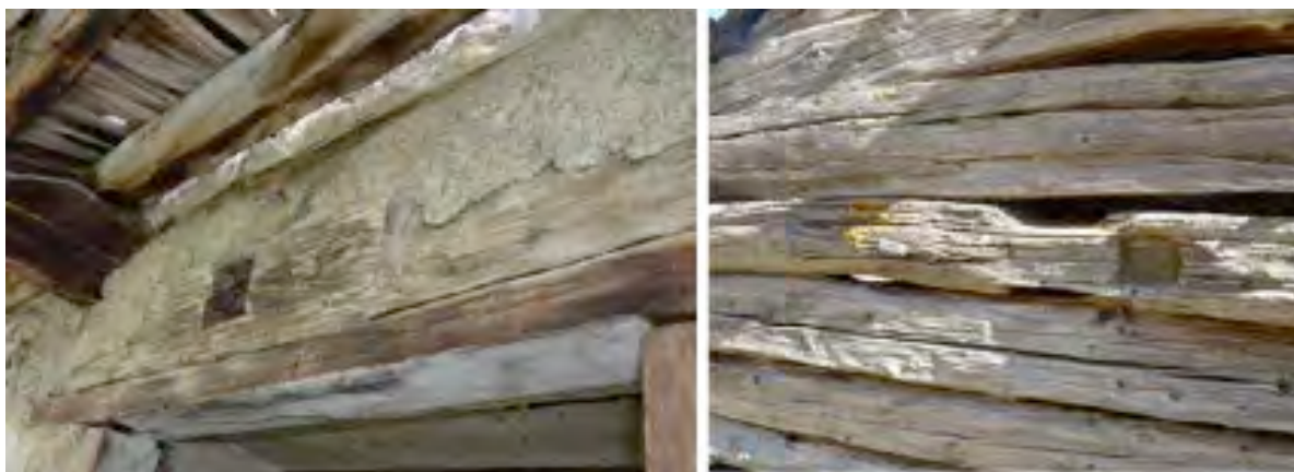
Figure 175 : Deux exemples de sablières réemployées : Bâtiment CR 100 (Champrichard, Allos), à gauche, une ancienne sablière de charpente réemployée en sablière de toiture. A droite, une sablière-formant-seuil ou linteau réemployée en maille d'élévation dans la grange CBO 500 (Bousieyas, Saint-Dalmas-le-Selvage). Cl. de V. Labbas.
