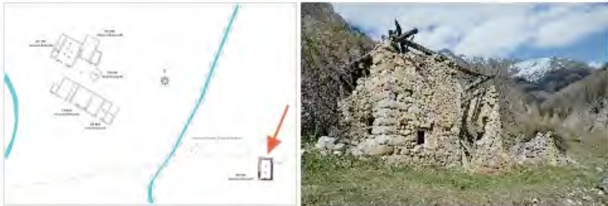
Figure 66 : Situation géographique du bâtiment CR 500. A droite cliché de l'élévation sud.
