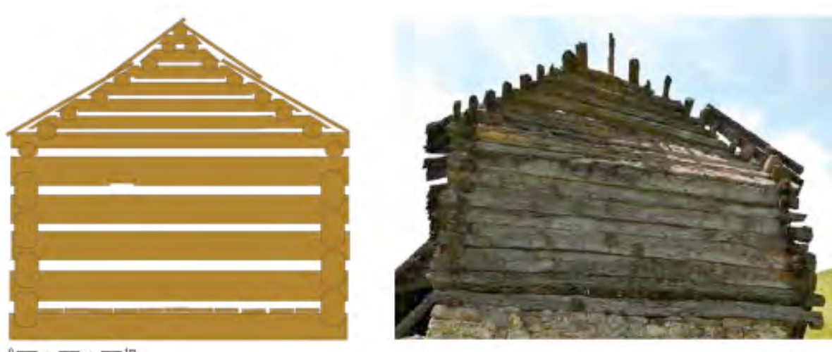
Figure 150 : Pignons de granges bâties en mailles empilées. A gauche : restitution du bâtiment CBO 400 (Bousieyas, Saint-Dalmas-le-Selvage, 06) dans son état du XVe siècle. A droite, le pignon nord de la grange BLA 600 (Saint Etienne-de-Tinée, 06). Cl. et DAO de V. Labbas.
