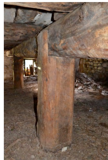
Figure 49 : Le poteau 10207, vue du nord. Cl. V. Labbas
