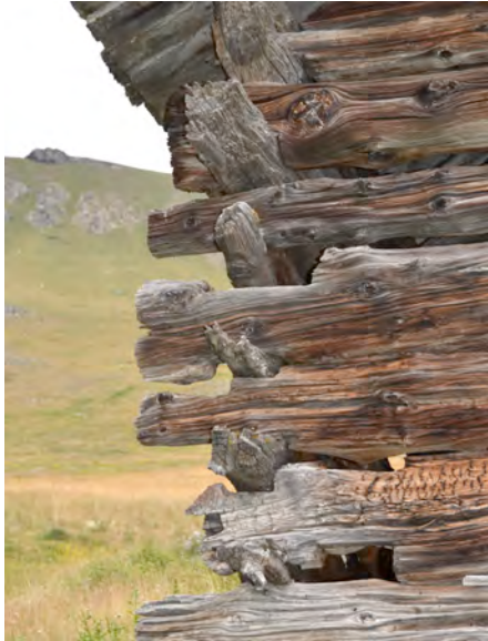
Figure 176 : Encoches réadaptées des mailles du pignon sud de la grange CBO 500 (Bousieyas, Saint Dalmas-le-Selvage). Cl. V. Labbas
