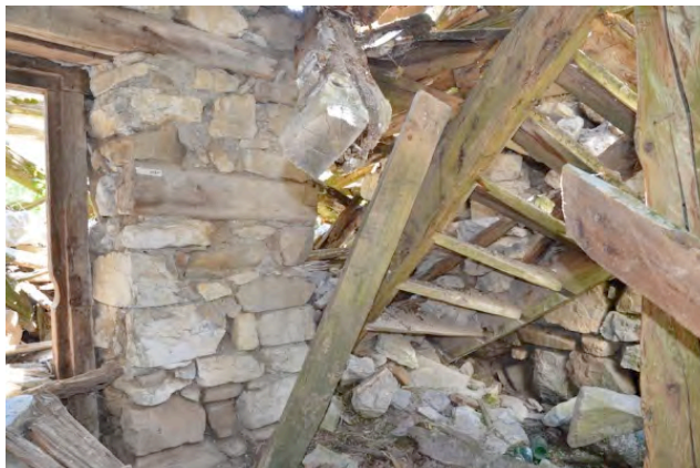
Figure 60 : pièce nord de l'unité 5. On distingue nettement l'ancienne échelle qui permettait l'accès à R+1 ainsi que la cloison séparative des pièces sud et nord. Cl. V. Labbas.
