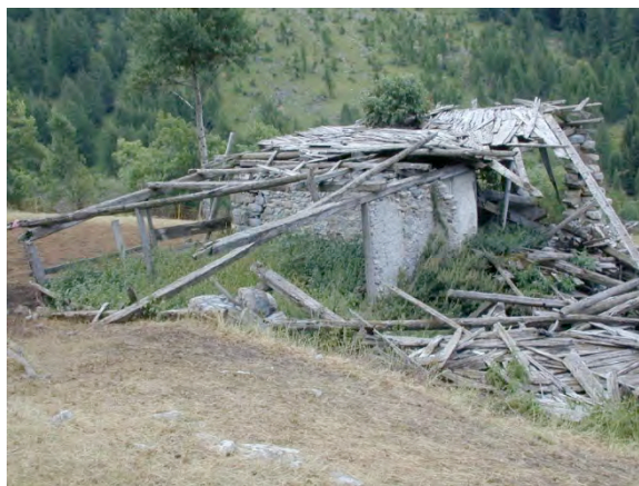
Figure 61 : Unité 6 (maison Coste), vue du nord (d'après cl. de K. Leyoudec, 2004).
