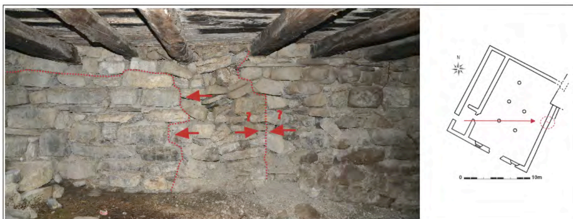
Figure 51 : Bâtiment CR 100, reprises dans le mur oriental au niveau R0. Cl. et DAO de V. Labbas.
