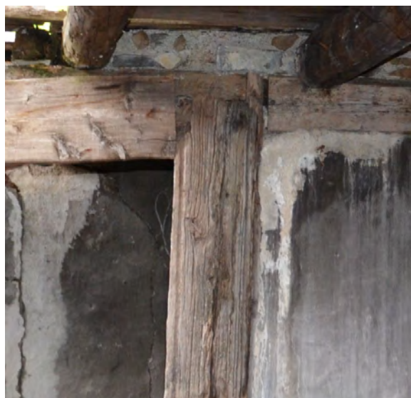
Figure 173 : Bardeau de toiture réemployé en chambranle dans une porte en R+1 du bâtiment CR 100 (Champrichard, Allos). Cl. de V. Labbas
