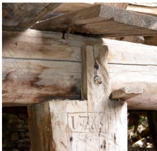
Figure 50 : Détail du poteau 10206. Cl. V. Labbas.
