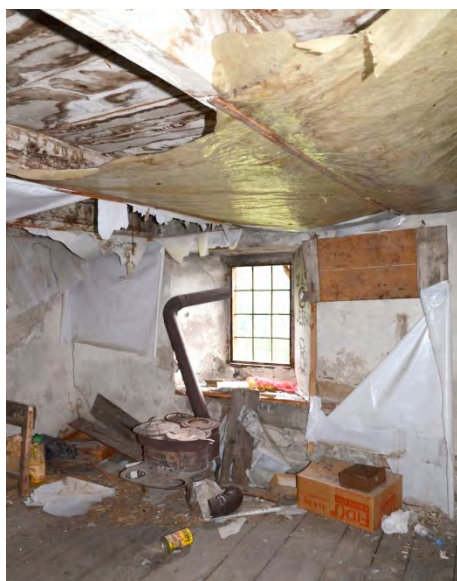
Figure 43 : Ancienne cuisine de la maison Rebattu. Cette pièce est située à l'étage et dans la moitié est du bâtiment. Cl. V. Labbas.
