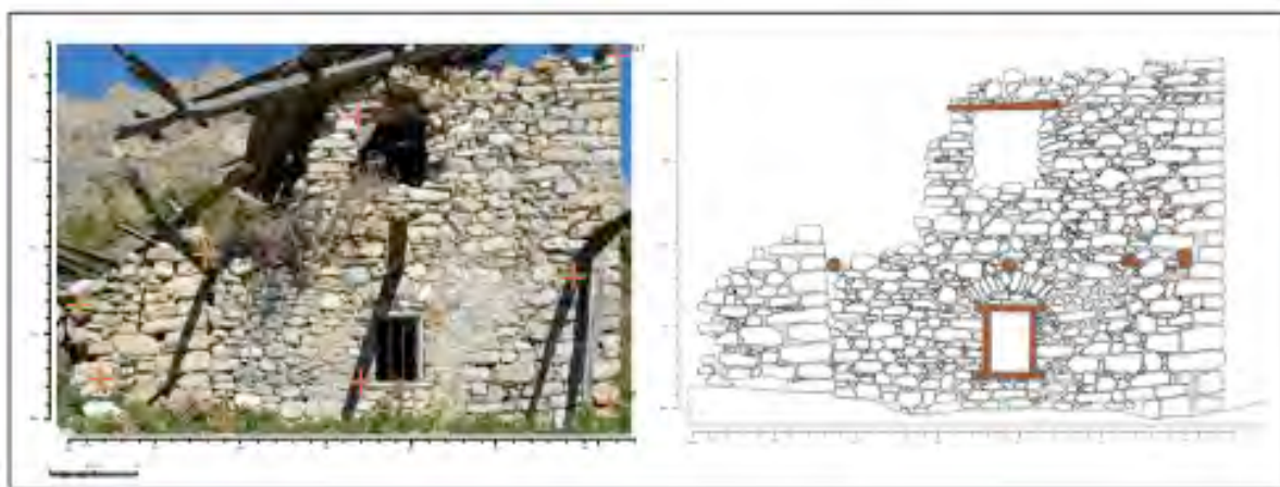
Figure 30 : Orthophotographie d'une élévation et vectorisation pierre à pierre sur Adobe Illustrator. Maison CR 400 de Champrichard (commune d'Allos, 04) DAO de V. Labbas.
