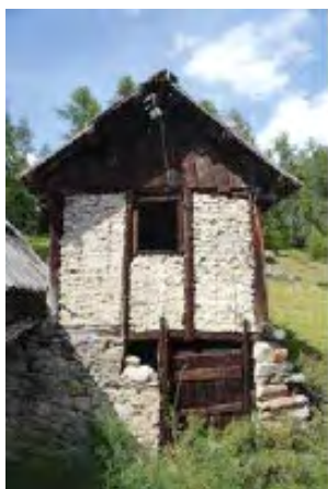
Figure 157 : Emploi du pan-de-bois dans le bâti subalpin. A gauche, le bâtiment ANL 100 (Saint-Etienne-de-Tinée) construit à l'extrême fin du XIXe siècle ou début du XXe siècle. A droite, cloison en pan-de-bois dans la grange BLA 1000 (Saint-Etienne-de-Tinée). Cl. V. Labbas
