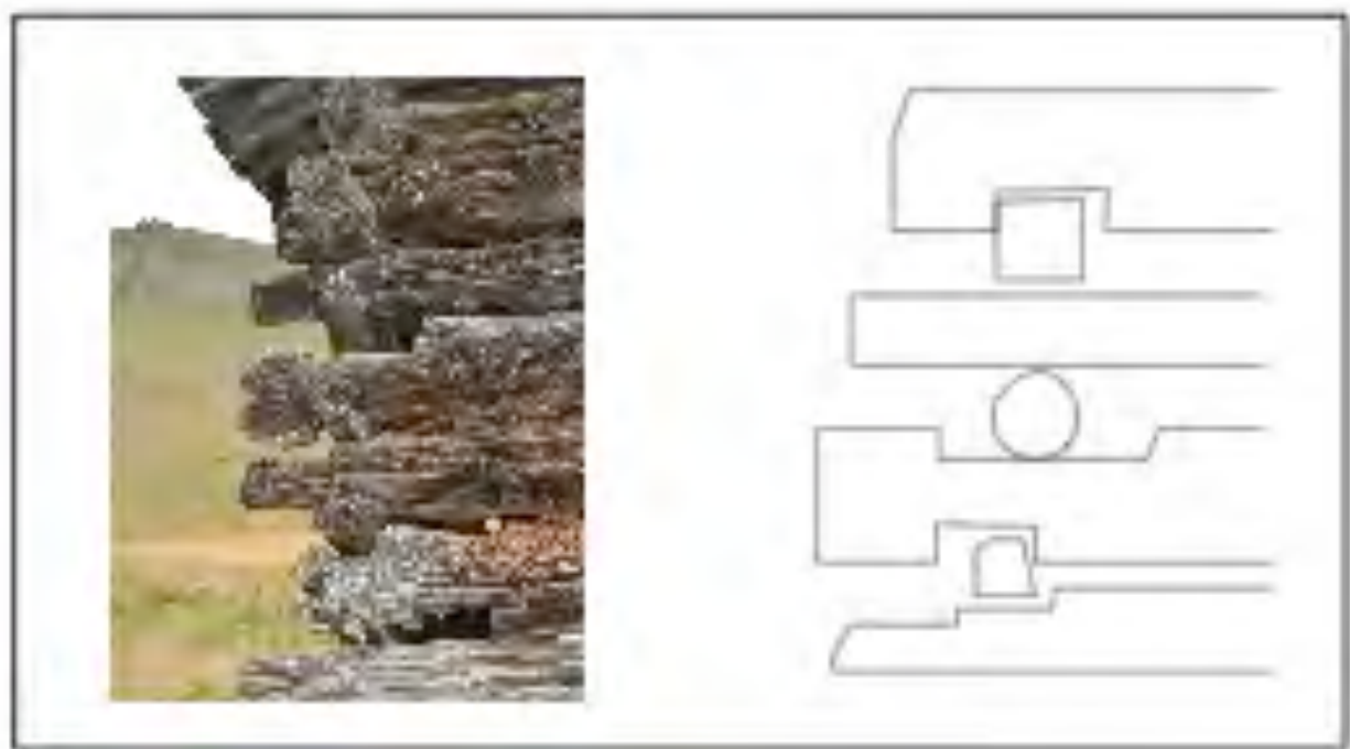
Figure 96 : Détail des façonnages multiples des encoches dans l'angle ouest du mur 508. Cl. Et DAO de V. Labbas.
