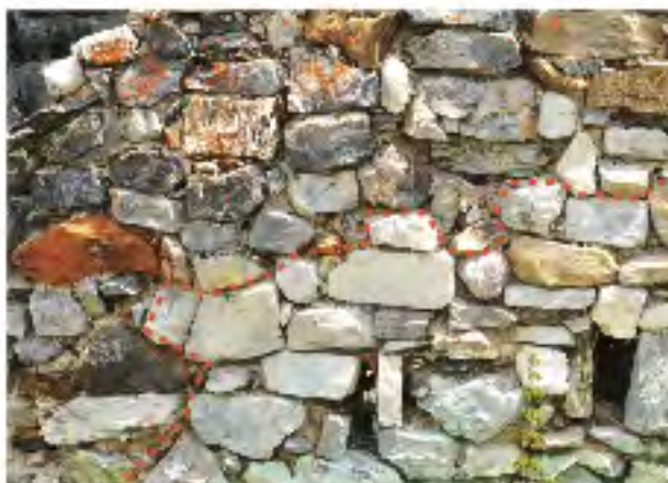
Bâtiment BLA 300: détail du mur 301.
