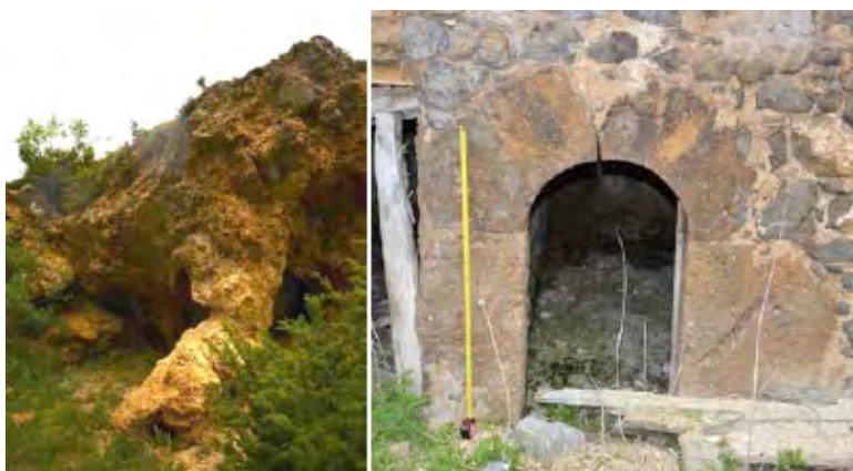
Figure 145 : Affleurement de travertin dans le vallon de Roya (à gauche), commune de Saint Etienne-de-Tinée et emploi local de travertin dans une baie (bâtiment TR 100, sur le versant sud). Cl. de V. Labbas.
