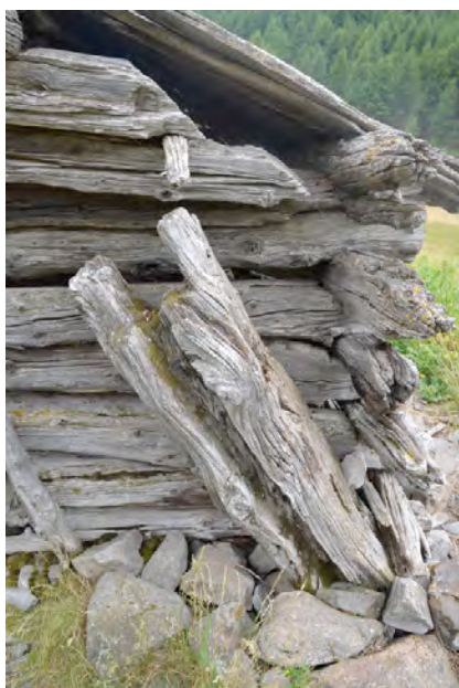
Figure 97 : Chambranle planté dans l'angle nord-ouest. Cl. V. Labbas.
