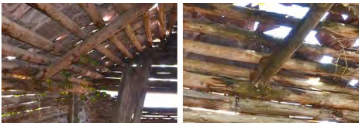
Figure 163 : Détails d'arbalétriers dans une grange du village de Roure (à gauche) et dans la grange RG 500 à Rougios (commune de Roure, à droite). Cl. de V. Labbas.
