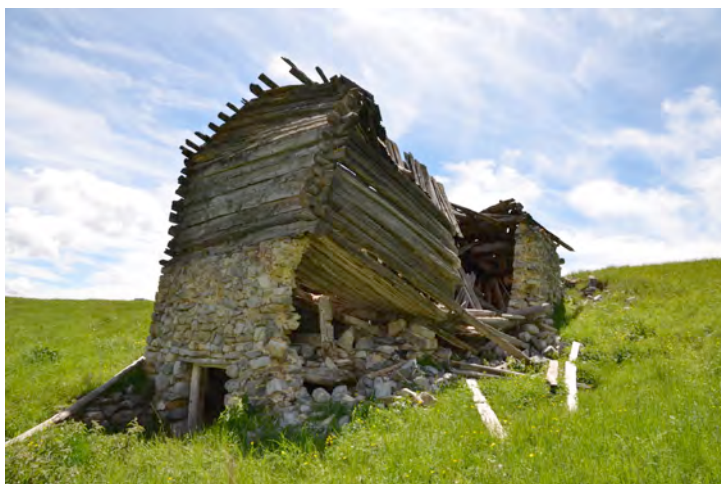
Figure 124 : Le bâtiment BLA 600 vue du nord. Cl. de V. Labbas.
