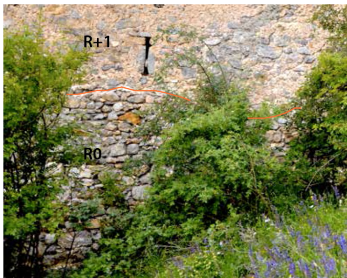
Figure 172 : Niveau R0 d'un édifice antérieur réemployé dans le bâtiment BLA 1100 (Blainon, Saint Etienne-de-Tinée). Cl. et DAO de V. Labbas.
