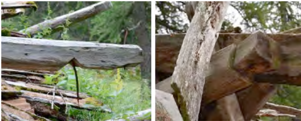
Figure 165 : Détails des extrémités d'un arbalétrier (à gauche) et d'un entrail (à droite) sur un bâtiment agropastoral dans le quartier de Mollières (vallon de Mollières, commune de Valdeblore). Cl. de V. Labbas.
