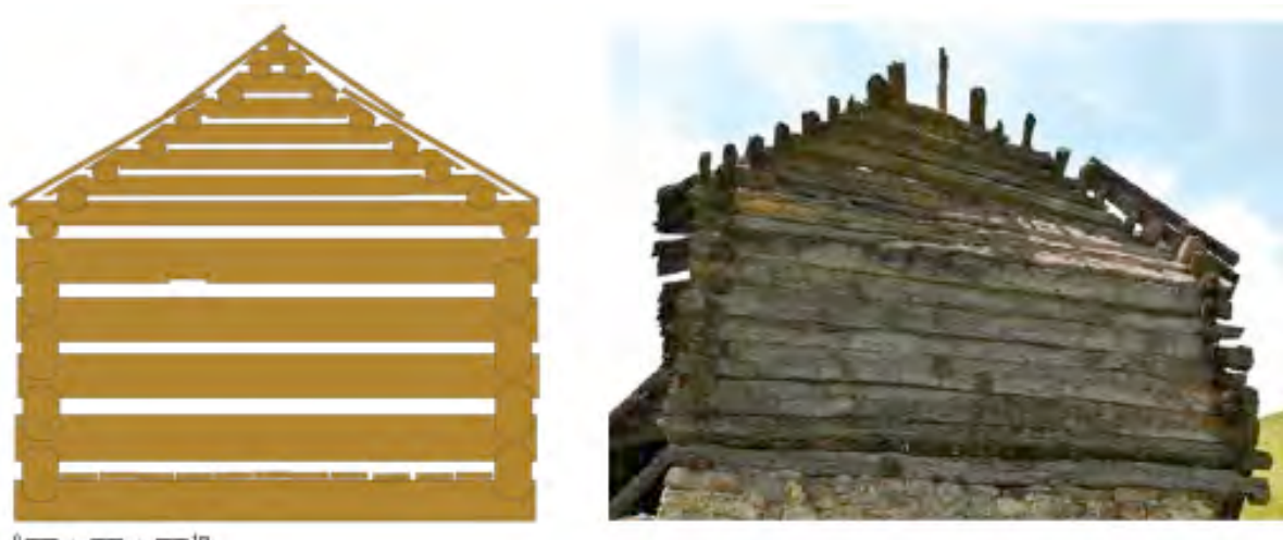
Figure 150 : Pignons de granges bâties en mailles empilées. A gauche : restitution du bâtiment CBO 400 (Bousieyas, Saint-Dalmas-le-Selvage, 06) dans son état du XVe siècle. A droite, le pignon nord de la grange BLA 600 (Saint Etienne-de-Tinée, 06). Cl. et DAO de V. Labbas.
