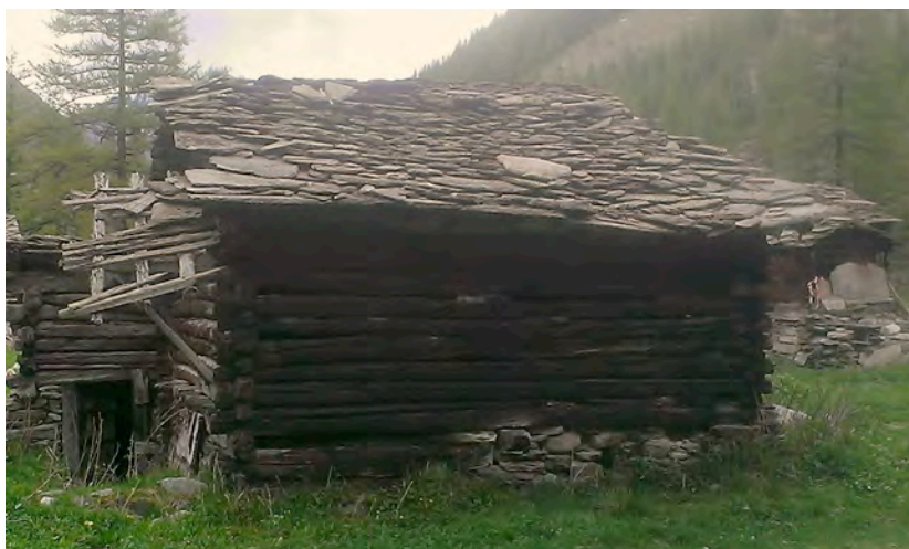
Figure 158 : Une grange bâtie en empilage dans le Val d'Aoste. Cl. Labbas.
