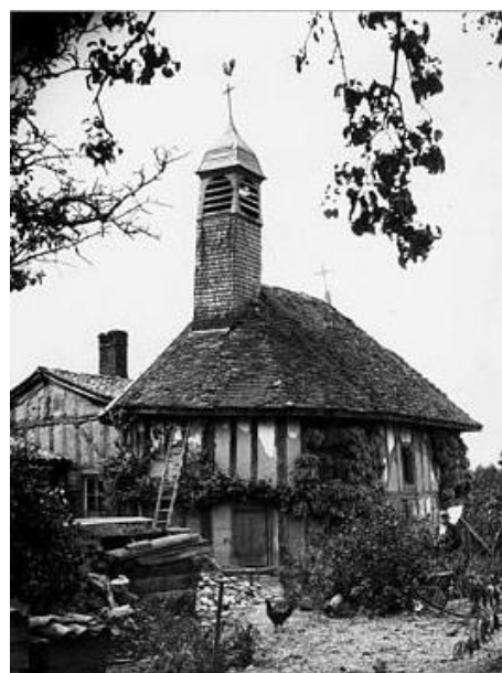
Figure 26 - Chapelle Saint-Berchaire - Chevet et côté de la chapelle en pan-de-bois (Notice APMH00128410 - Base Mémoire, C. Hurault (photographe) © C.R.M.H. - R.M.N., 1943)
