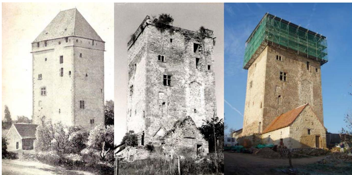
Figure 10 - Tour du Bost (Charmoy) - État des lieux en 1897, 1992 et 2007
