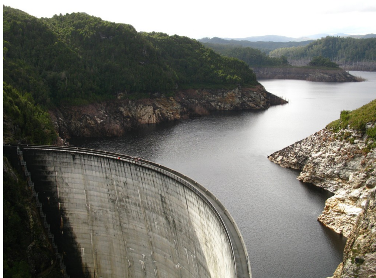
FIGURE 3.14 – Le barrage Gordon, pièce maîtresse du Gordon river power development stage 1 (Cliché : S. Flaminio, août 2014). Le barrage Gordon est le 5 e ouvrage le plus haut d’Australie et le premier ouvrage par son volume (12 milliards de m 3 ).
