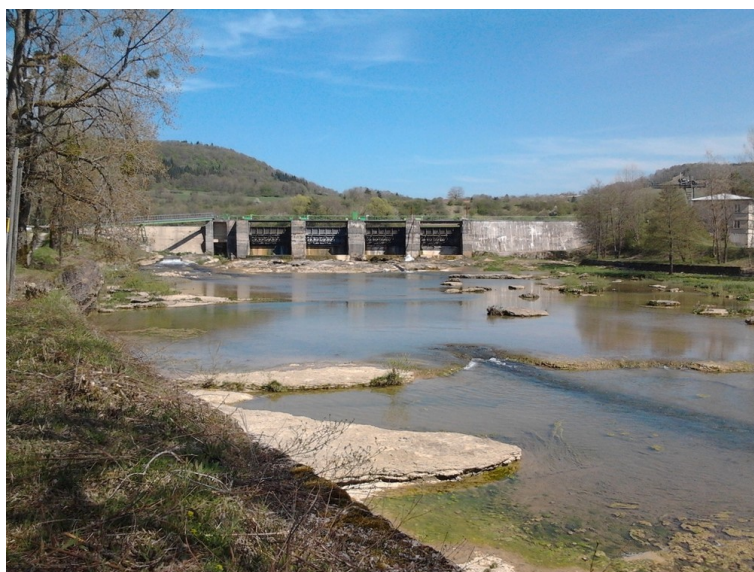
FIGURE 8.4 – Le barrage de Blye, secteur amont (Cliché : S. Flaminio, avril 2014). Le barrage de Blye a été construit entre 1955 et 1957 sur les fondations d'un ouvrage antérieur. La centrale compte trois turbines dont la capacité totale est d'environ 50 m 3 /sec. Le barrage, d'une hauteur de chute de 9 m, crée une retenue d'environ 50 hectares. L'ouvrage fait l'objet d'une concession étatique à la Société des Chutes de l'Ain. Cette dernière est détenue par une société à capitaux suisses, Kleinkraftwerk Birseck. Une autre entreprise, Hydrowatt, est en charge de l'exploitation et de la maintenance de la centrale. L'électricité produite est vendue à EDF et à Rhodia-Solvay. Les gestionnaires ont aménagé un parcours pour que les kayakistes puissent contourner le barrage. En 2015, des études avaient été initiées pour considérer la franchissabilité du barrage en termes sédimentaires et halieutiques. Ces informations ont été transmises par un employé d'Hydrowatt en charge de la gestion du barrage de Blye.
