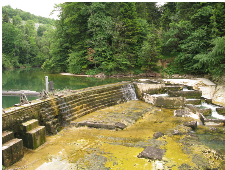
FIGURE 8.3 – La micro-centrale de la Roche, à Champagnole, secteur amont (Cliché : S. Flaminio, juin 2015). Cette microcentrale est gérée par la municipalité de Champagnole. Sa hauteur de chute est de 4 m et elle a une puissance de 300 kW. Selon un employé municipal en charge de la gestion de la centrale, celle-ci est gérée au centimètre près en allant d'un niveau 0 où il n'y a de l'eau que dans la passe-à-poissons (à droite sur la photographie) au niveau 3. La photographie a été prise lorsque la centrale était réglée au niveau 2,5. Le panneau de présentation de la micro-centrale, installé sur le bâtiment de l'usine et réalisé par la Fédération nationale des producteurs privés d'électricité d'origine renouvelable, souligne que les petites centrales de ce type, au nombre de 2 000 en France, constitueraient « une contribution majeure à la protection de l'environnement ».
