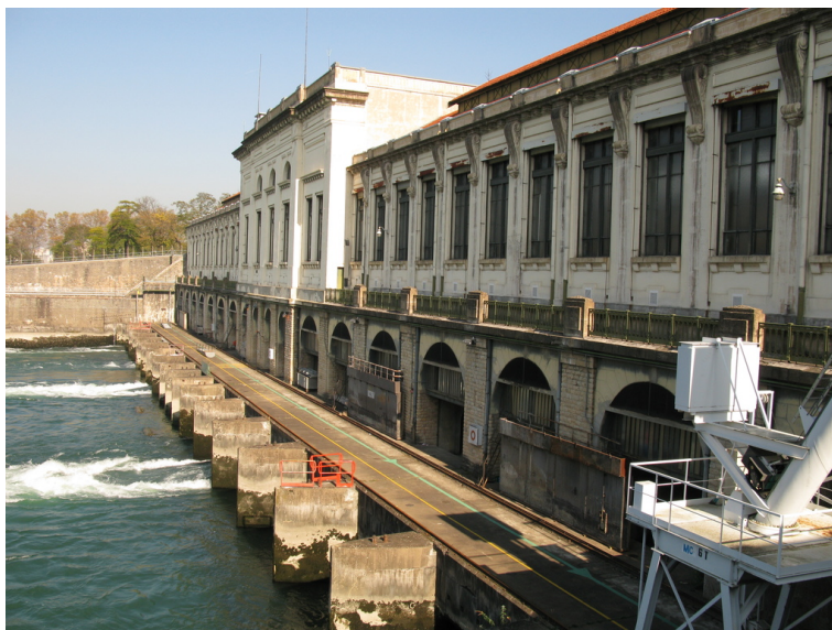
FIGURE 3.7 – L’usine hydroélectrique (EDF) de Cusset (Cliché : S. Flaminio, octobre 2014). L’aménagement hydroélectrique de Cusset, mis en service en 1899 et fonctionnant au fil de l’eau, produit 415 millions de kWh par an environ. Selon une plaquette de son exploitant, datée de 2011, cet aménagement « marque un tournant dans l’histoire de la production d’électricité en France. Avant-gardiste, il a servi de modèle pour les futurs équipements hydroélectriques qui se sont construits sur le Rhône et sur le Rhin ». Sa concession a été renouvelée en 2002 et des travaux ont été engagés pour améliorer les performances de l’équipement mais aussi pour mettre en valeur davantage l’usine dans sa dimension patrimoniale (COLIN 2013, 2014).
