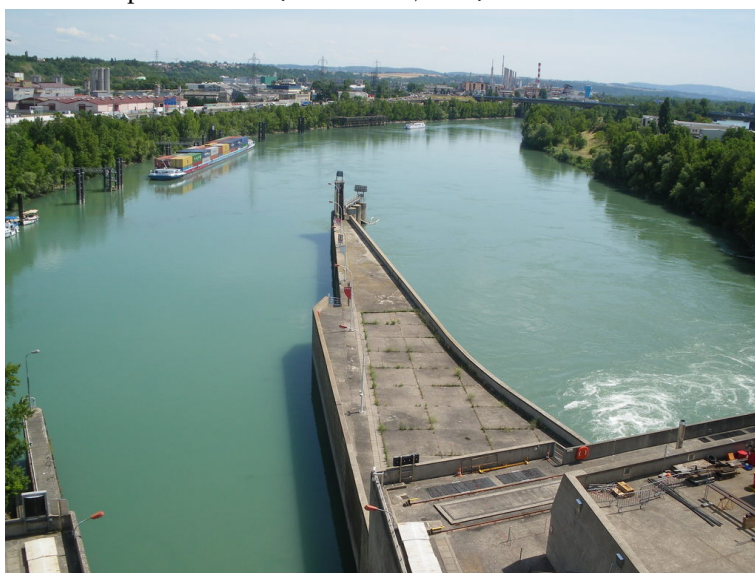
FIGURE 3.8 – Vue du Rhône (regardant vers l’aval) depuis l’usine hydroélectrique (CNR) de Pierre-Bénite (Cliché : S. Flaminio, juin 2015). Le projet de barrage à Pierre-Bénite, à peine en aval de Lyon, est lancé par la CNR au début des années 1960. Il s’agit du premier aménagement non entièrement financé par la rente du Rhône, c’est-à-dire par la vente d’électricité. En effet, à partir de 1965, les aménagements restant à réaliser ne sont plus considérés comme rentables par EDF (BETHEMONT et BRAVARD 2016). Pierre-Bénite, mais aussi d’autres ouvrages édifiés en travers du Bas Rhône constituent des aménagements à buts multiples financés par l’État (GRANDJEAN 1983).
