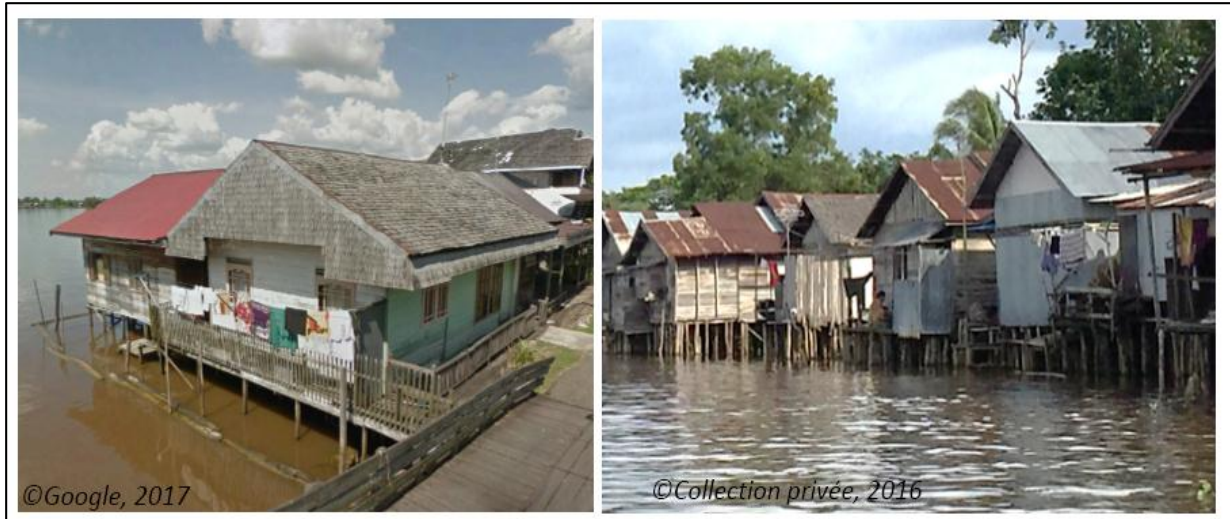
Figure 63. Les maisons fournies des toilettes dedans. Les maisons construites entièrement sur l'eau à Marabahan (à gauche) et les maisons construites en moitié sur la terre avec les toilettes construites sur l'eau à Tabunganen (à droite)
