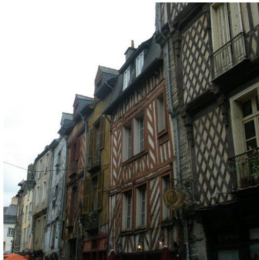
Figure 100 - Façades d'immeubles à pans de bois de la rue Saint-Michel à Rennes (photographie É. Walker, 2012)
