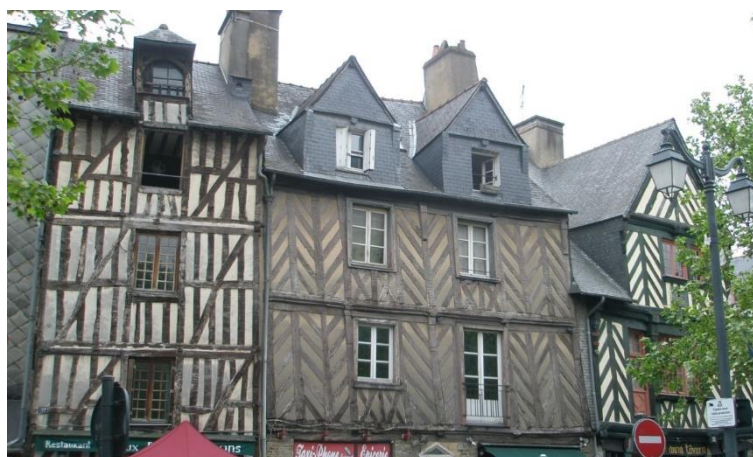
Figure 101 - Façades d'immeubles à pans de bois de la place Sainte-Anne à Rennes (photographie É. Walker, 2012)
