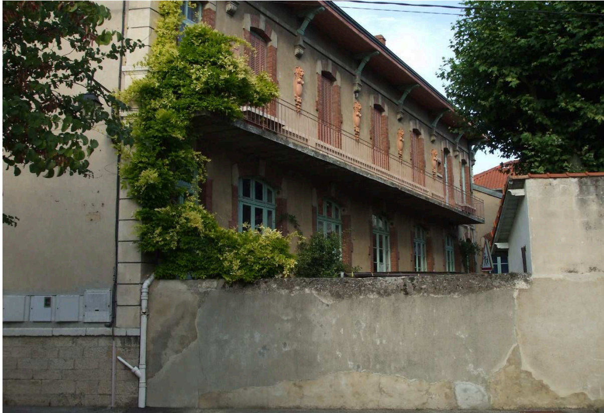
Illustration 57 – Façade principale, côté cours, de l'école maternelle de la rue Pêcherie (cliché J.S. Gauthier, 2012)
