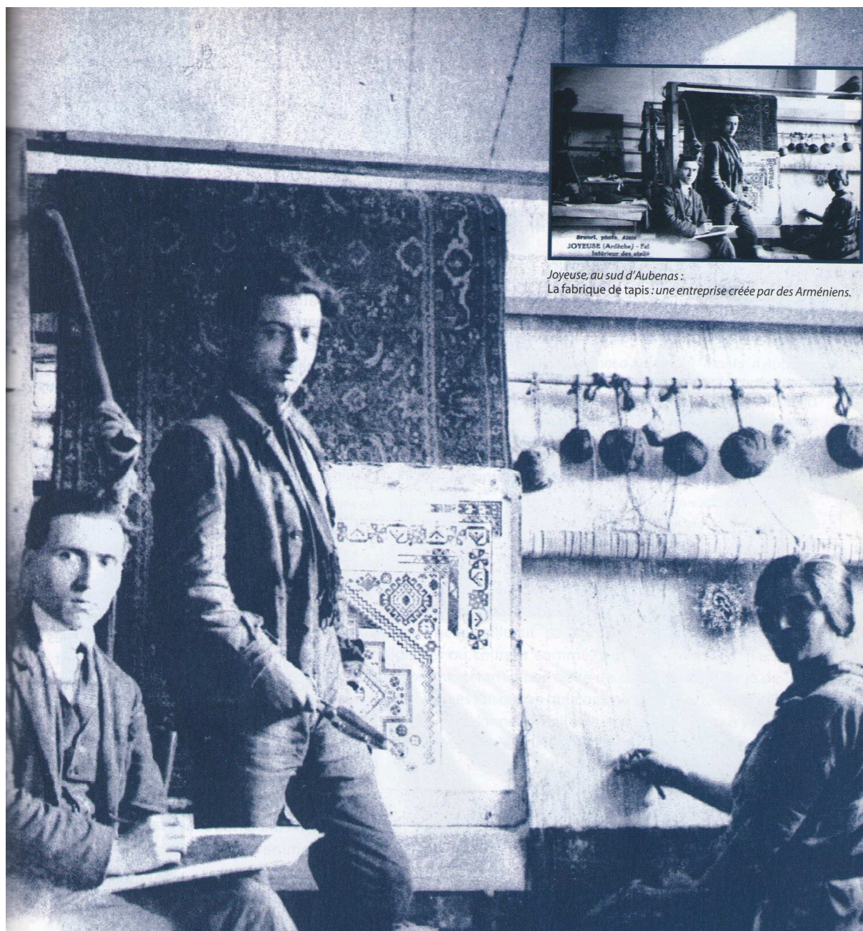
Illustration 25 – La fabrique de tapis d'Orient (source : Julie Lioré, ouvrage cité)
