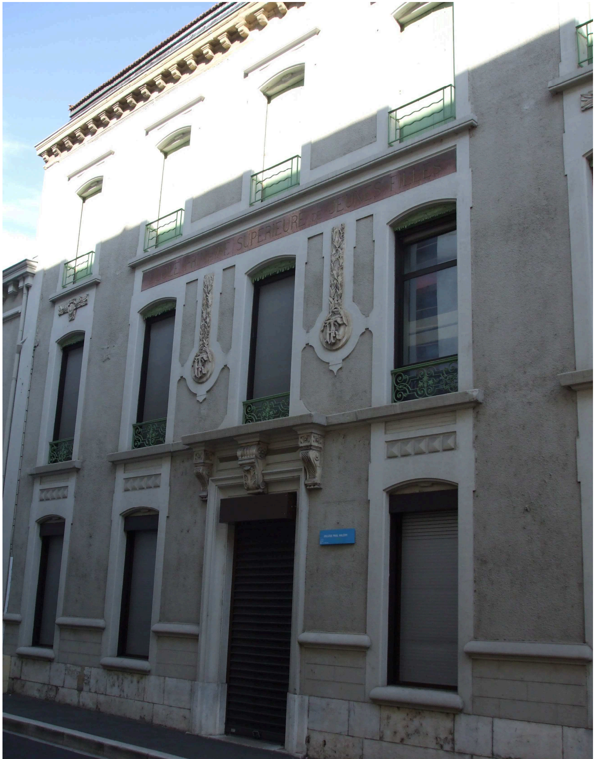
Illustration 68 – Entrée principale, rue Berthelot, de l’EPS de filles de Valence (cliché J.S. Gauthier)
