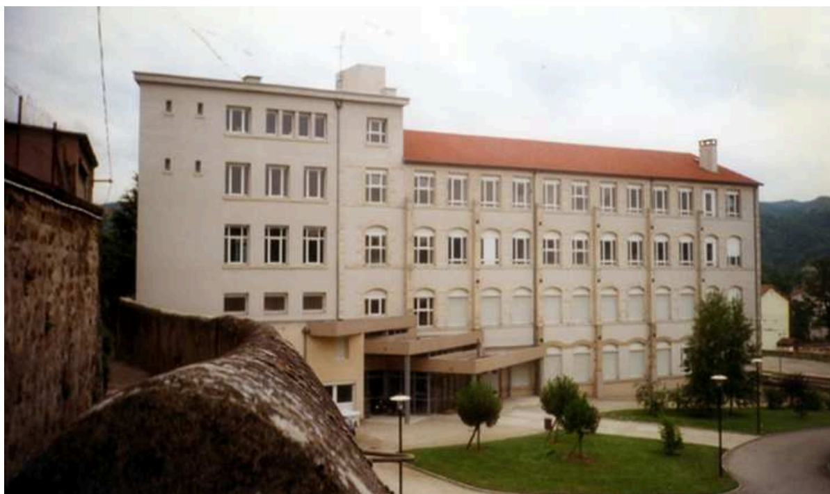
Illustration 29 – Ancienne moulinerie Baboin, dite usine 5 (Cliché Patrimoine de Rhône-Alpes – Source internet)
