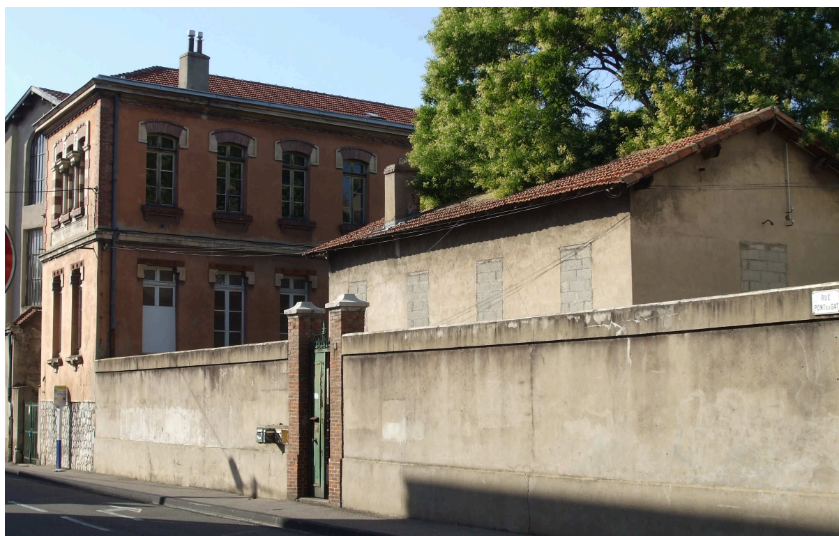
Illustration 101 – Les bâtiments de l'ancienne école d'enseignement ménager, 3 rue Pont du Gât (cliché J.S. Gauthier)
