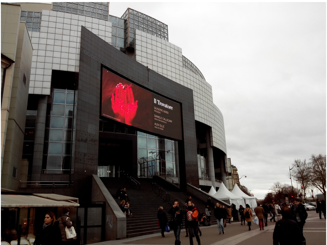
Illustration 24 — Vue du Port de l'arsenal, et vue de l'Opéra Bastille. Source : M.Delarc
