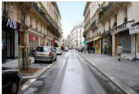
Rue Lucien Sampaix - Après Travaux
