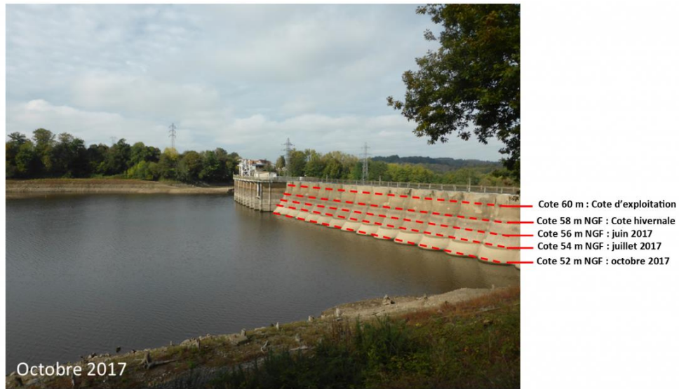
Figure 3-9: Niveaux progressifs du lac de retenue au niveau du barrage de Vezins. Source : Bassin de la Sélune (Observatoire de la Sélune).
