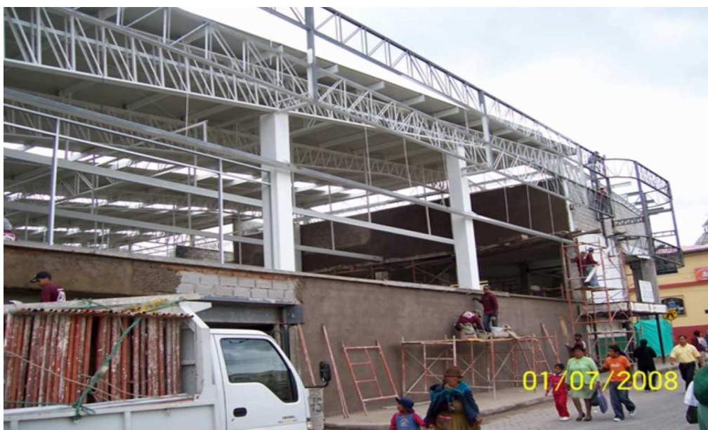
Photo No. 6 : Construction du supermarché « Méga Santa Maria » à Cayambe (2008)
