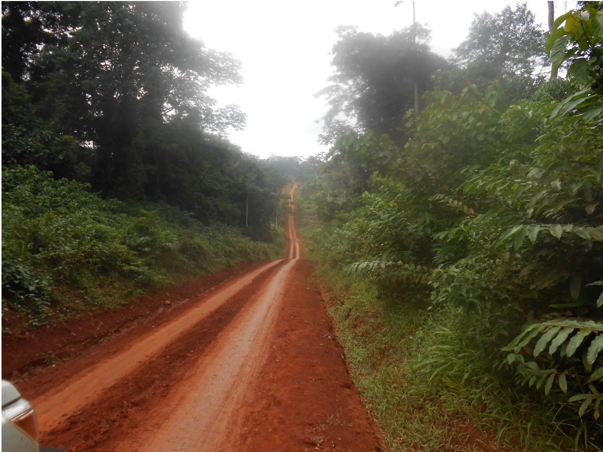
Photo 2: L'axe routier Lomié-Bosquet-Messok, ici après les travaux d'entretien de la commune de Lomié.
