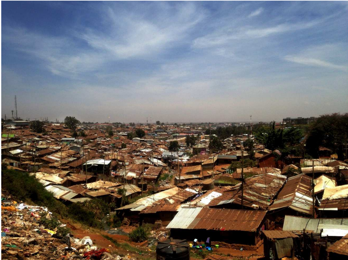
Figure 24 : Les mabati houses de Nairobi, vue depuis le chemin de fer, dans le village de Katwekera. Source : JBL, mars 2015.
