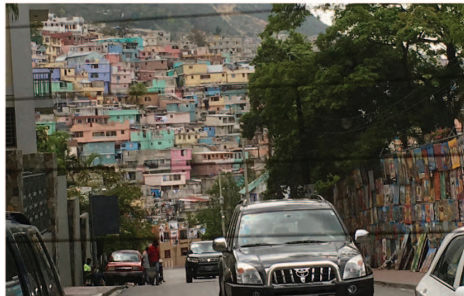
Figure 27 : Photographies de Port-au-Prince, Haïti (Source : F. Benitez, mars 2016)
