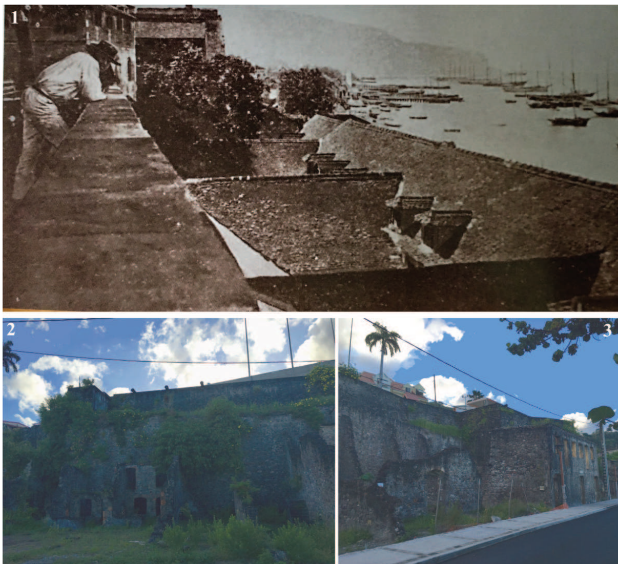
Figure 54 : Photographies du quartier du Figuier avant 1902 et aujourd'hui. N°1 : Vue des toits en tuiles du quartier du Figuier en 1902 ; n°2 et 3 : les ruines du quartier du Figuier aujourd'hui 125
