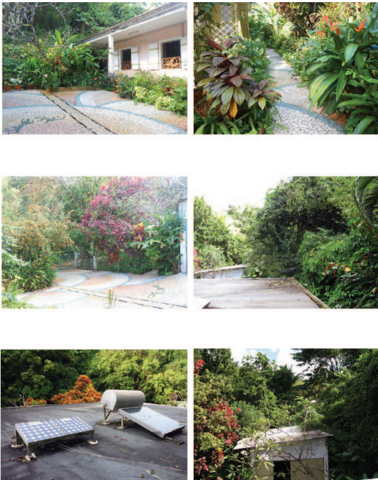
Figure 86 : Photographies de la maison et du toit de Jacqueline avec vue du panneau solaire et du chauffe-eau solaire dont elle parle lors du passage du cyclone Dean 269
