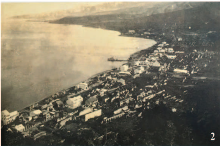
Figure 49 : Photographies de Saint-Pierre en reconstruction : n°1 : Vue générale de Saint-Pierre renaissant en 1926 et n°2 : La ville de Saint-Pierre en reconstruction en 1929 120
