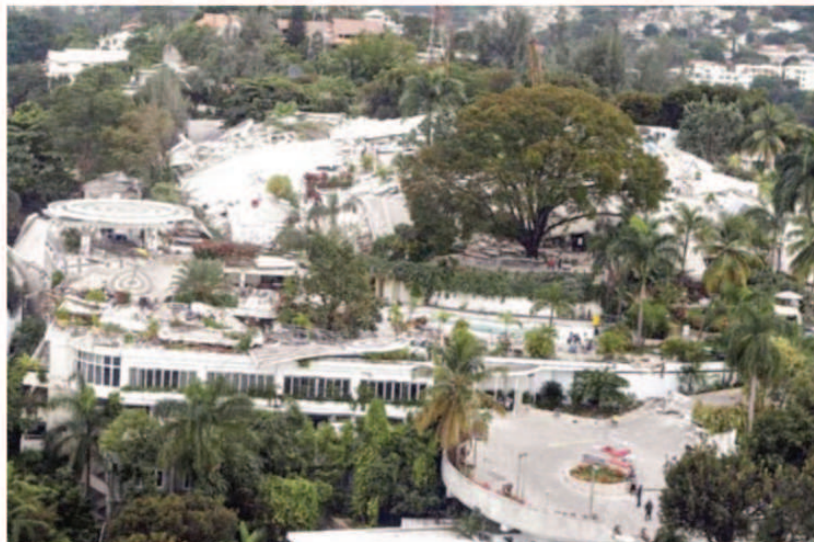
Figure 46 : Photographie de l'hôtel Montana détruit par le séisme 113
