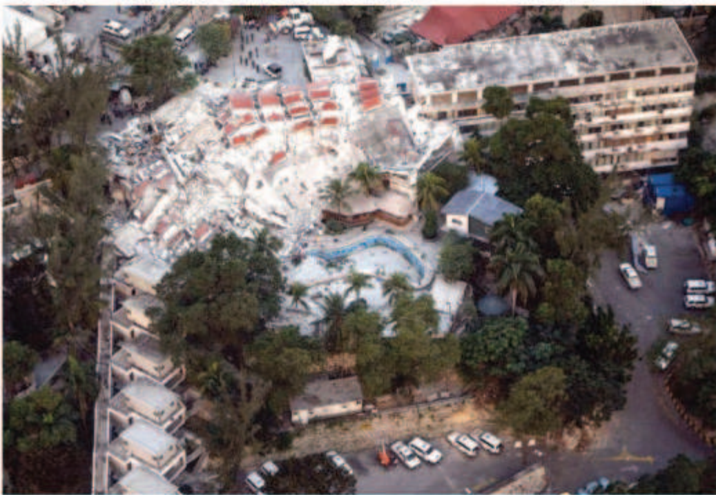
Figure 44 : Photographies du siège de la MINUSTAH de Port-au-Prince détruit après le séisme 111
