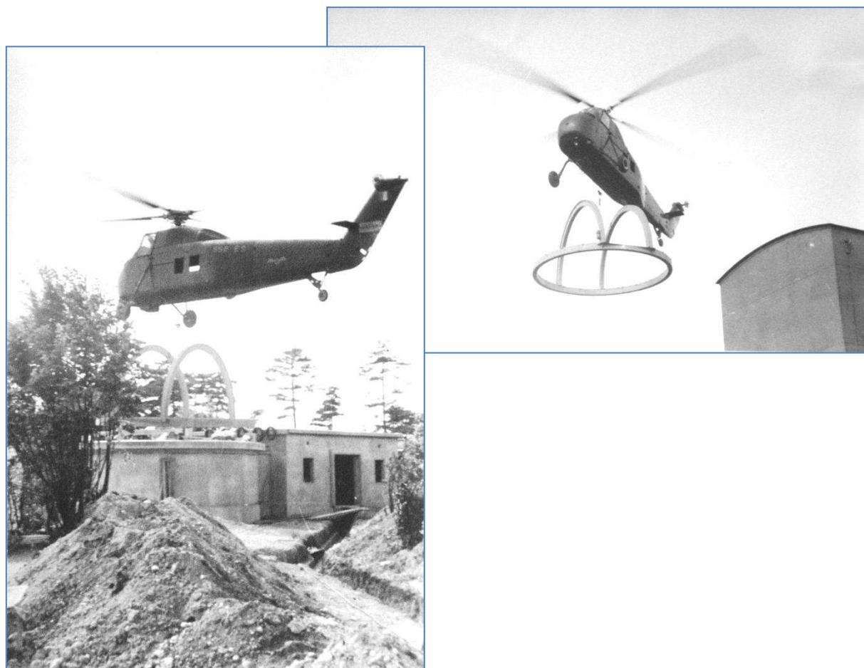
**Fig. 13** Mise en place de la charpente métallique d'une coupole, 20 septembre 1963<sup>55</sup>.
