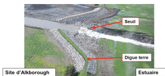
Photo 12 : seuil mis en place pour l'ouverture du site d'Alkborough. Source : Artélia, 2012 d'après Halcrow, 2009
