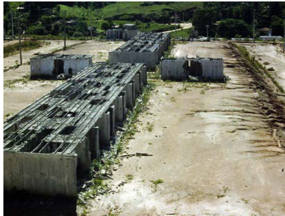
i.120 Conjuntos construídos em concreto plástico-químico pela falida Construtora Coan em estado de avançada decomposição pela ação das chuvas sobre o gesso que fazia parte da mistura com que foram edificadas as casas e edifícios [CDTec COHAB-SP]
