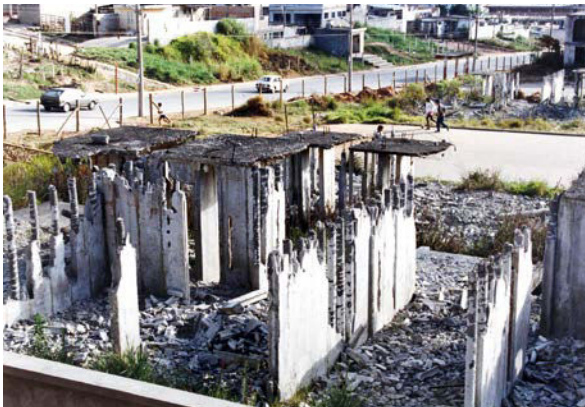
i.120 Conjuntos construídos em concreto plástico-químico pela falida Construtora Coan em estado de avançada decomposição pela ação das chuvas sobre o gesso que fazia parte da mistura com que foram edificadas as casas e edifícios [CDTec COHAB-SP]
