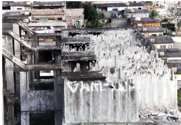
i.120 Conjuntos construídos em concreto plástico-químico pela falida Construtora Coan em estado de avançada decomposição pela ação das chuvas sobre o gesso que fazia parte da mistura com que foram edificadas as casas e edifícios [CDTec COHAB-SP]
