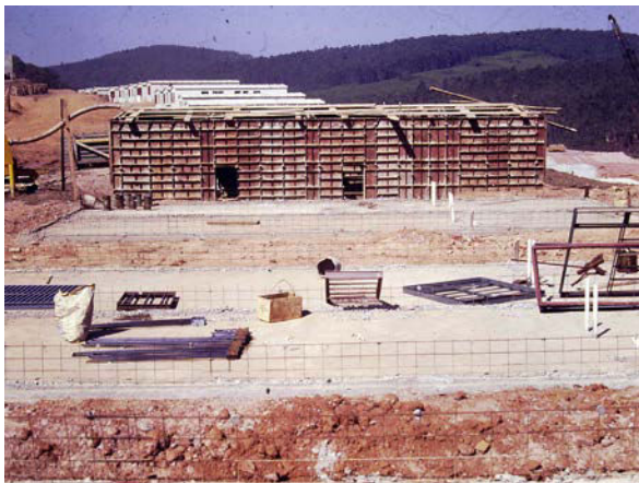
i.111 A construção das unidades unifamiliares do tipo 'embrião' dos diversos setores do 'Complexo' Cidade Tiradentes [CDTec COHAB-SP]
