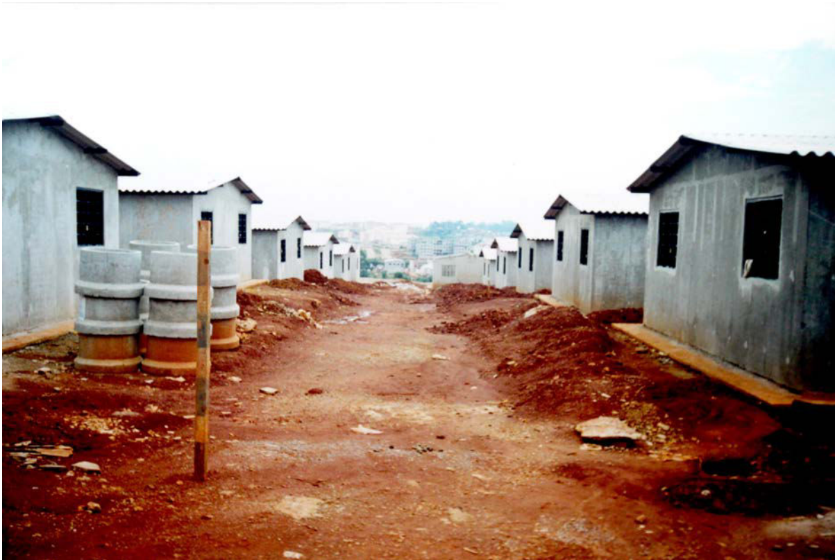
i.130 Construção de unidades do tipo embrião do padrão 'modelar' construídas no Conjunto Habitacional Inácio Monteiro [CDTec COHAB-SP]
