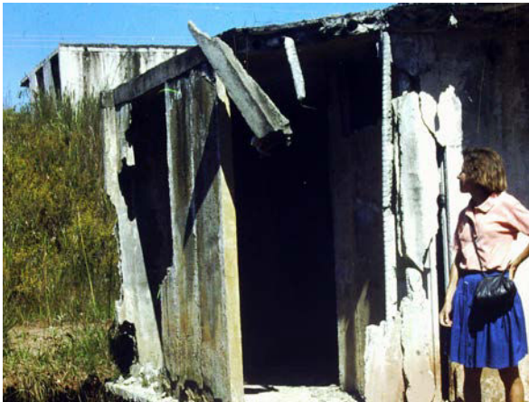
i.120 Conjuntos construídos em concreto plástico-químico pela falida Construtora Coan em estado de avançada decomposição pela ação das chuvas sobre o gesso que fazia parte da mistura com que foram edificadas as casas e edifícios [CDTec COHAB-SP]
