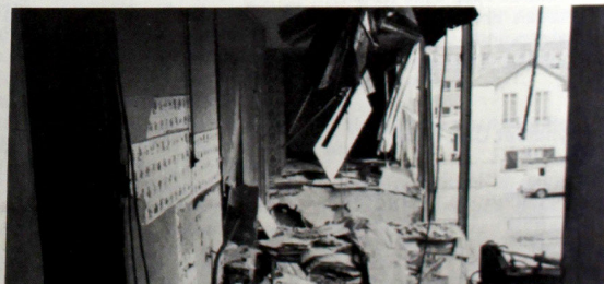
Destruction de trois bâtiments en 1980. Le préfet s'était engagé à détruire le quatrième le... 15 janvier 1981. Exigeons une solution immédiate.
