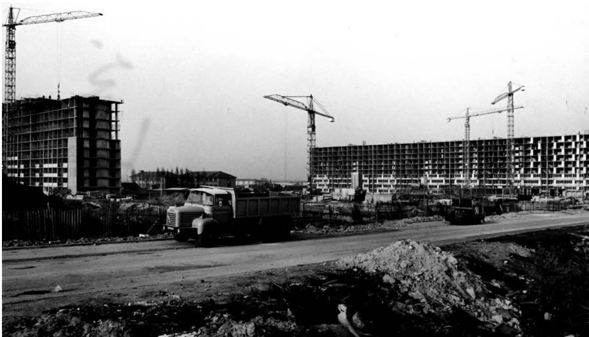
i.28 Os procedimentos de pré-fabricação pesada e industrialização do concreto empregados na obra da Cité Balzac [APMV]
