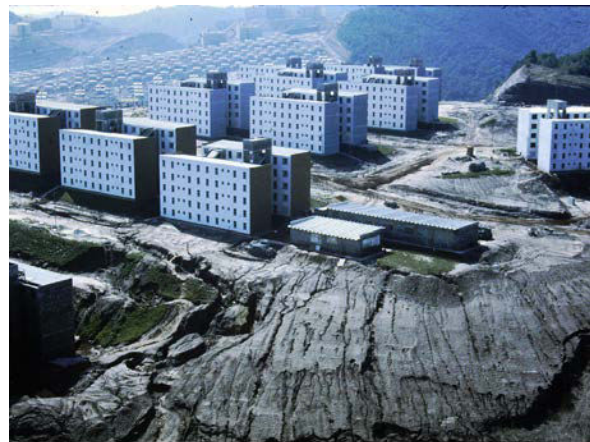
i.118 Erosões e deslizamentos de terra causados pelos efeitos da chuvas de projetos urbanísticos que negligenciaram a drenagem natural e as pré-existências do terreno [CD Tec COHAB-SP]
