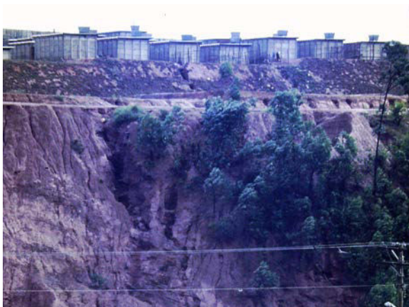
i.118 Erosões e deslizamentos de terra causados pelos efeitos da chuvas de projetos urbanísticos que negligenciaram a drenagem natural e as pré-existências do terreno [CD Tec COHAB-SP]
