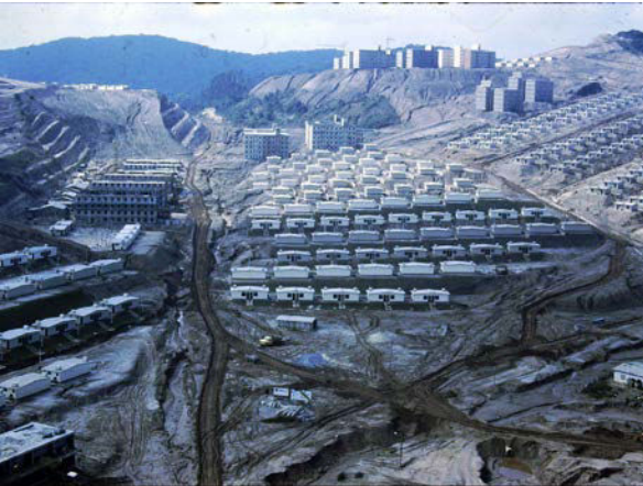
i.118 Erosões e deslizamentos de terra causados pelos efeitos da chuvas de projetos urbanísticos que negligenciaram a drenagem natural e as pré-existências do terreno [CD Tec COHAB-SP]
