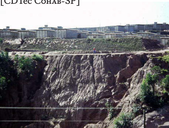
i.118 Erosões e deslizamentos de terra causados pelos efeitos da chuvas de projetos urbanísticos que negligenciaram a drenagem natural e as pré-existências do terreno [CD Tec COHAB-SP]
