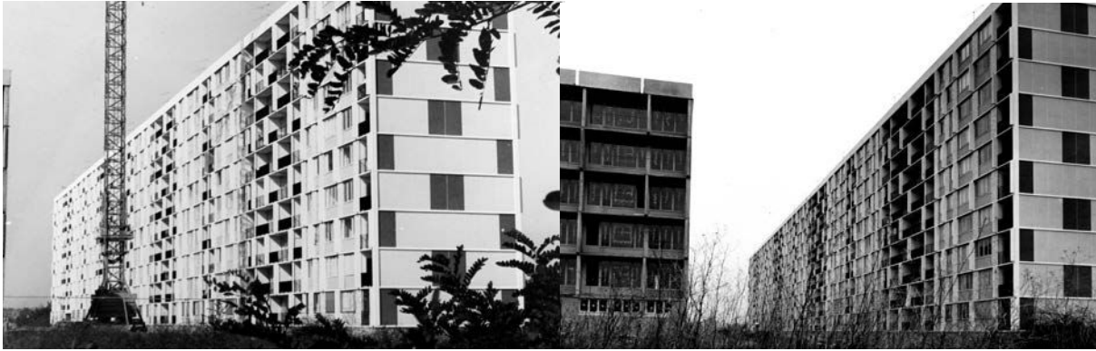
i.28 Os procedimentos de pré-fabricação pesada e industrialização do concreto empregados na obra da Cité Balzac [APMV]
