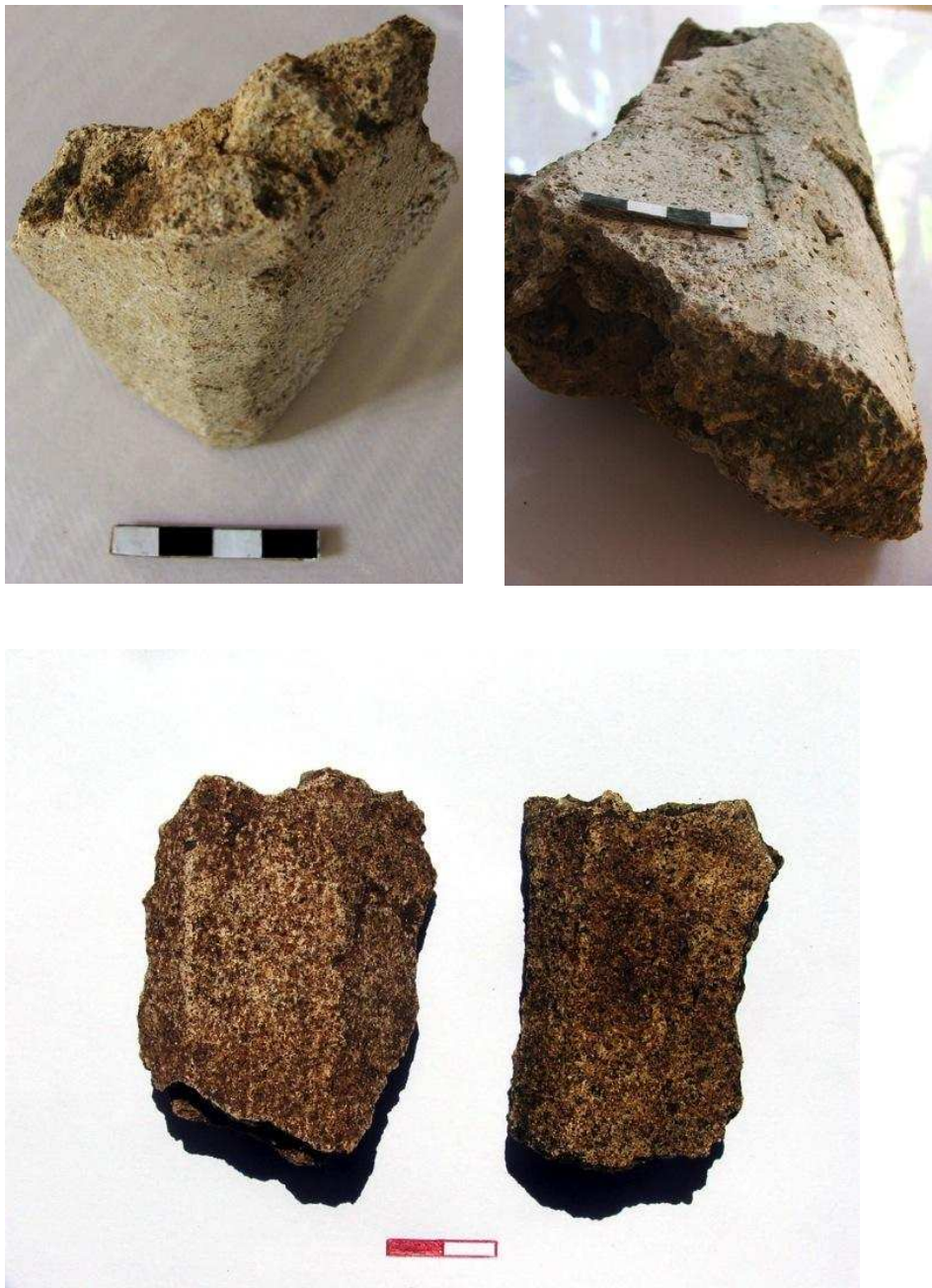
Figure 286 Enduit mural : fragments remarquables (angles) provenant du quartier des notables (Agnala M'kiri), clichés M. Pauly 2006-2007.
