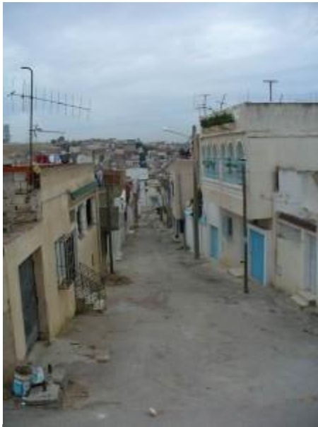
A Attadhamen, quartier populaire de Tunis qui a fait l'objet d'une régularisation, l'éclairage public est l'un des réseaux qui ont matérialisé l'intégration du quartier dans la ville (cc E. Verdeil 2005)
