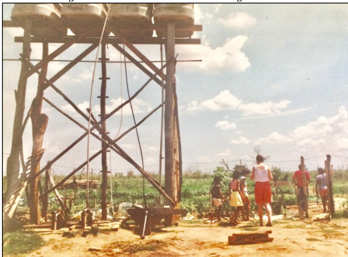
Figura 11 – Sistema de bombeamento de água mecânico
