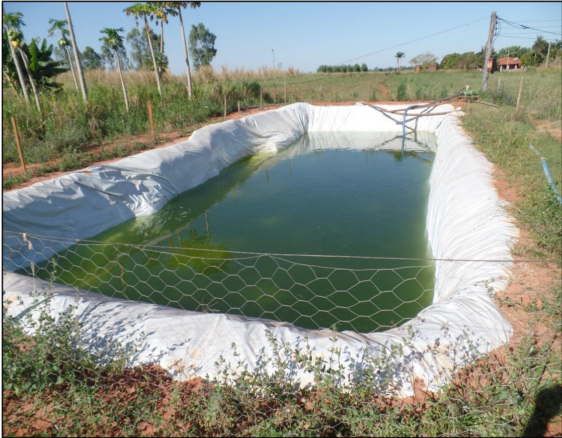
Figura 13 – Tanque de reserva de água
