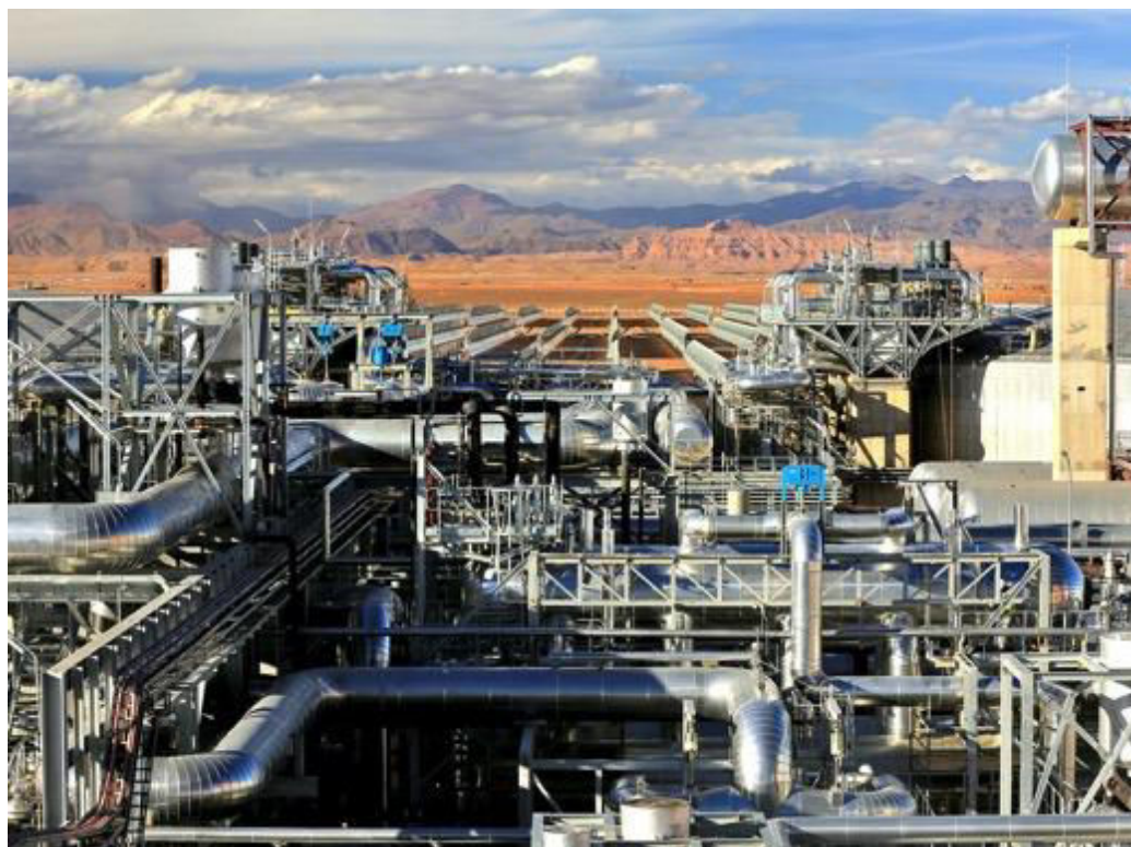
Photo de la centrale d'Ouarzazate. Crédit Masen
