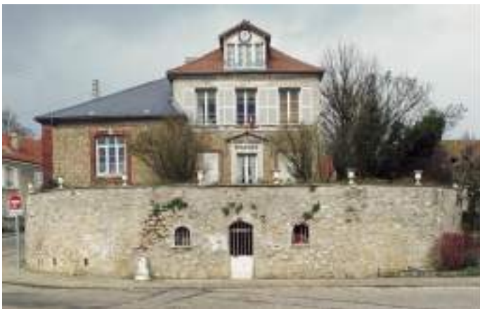
Illustration 71: Maison de Mareil de M. L. Dupiéry transformée en mairie en 1842. Le bâtiment latéral à gauche a été ajouté plus tard. Source : mairie de Mareil en France, http://www.mareil-en-france.fr/menu-principal/decouvrir-mareil/histoire-et-patrimoine , consulté le 6 novembre 2013.
