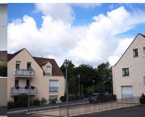
Rue de la Mairie & rue Pierre Curie Vémars 95641-2N
