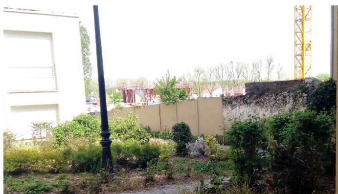
Figure 141 : les constructions en cours menacent la vue dégagée des habitants à Moussy-le-Neuf (77)
