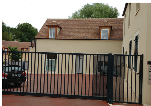
Vue de la rue après la construction
