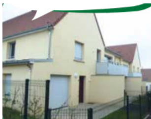
32 rue Aristide Briand / Auneau 28015-1N
