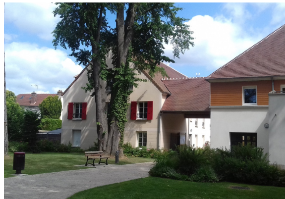
Vue de la rue après la construction
