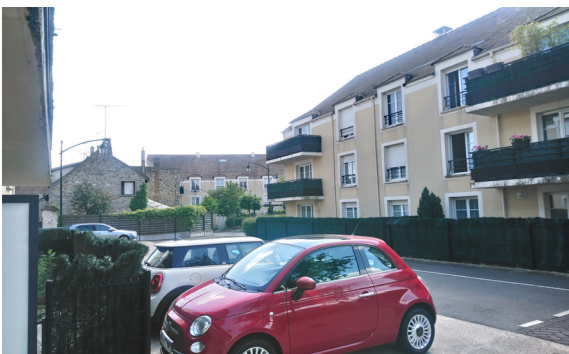
Vue de la construction
