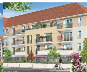
9 rue de la chaussée de Paris Villenoy 77513-6N
