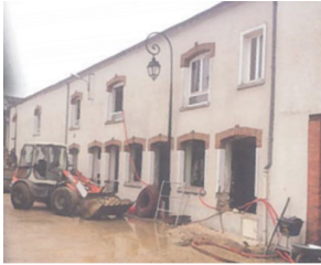
Rue du parc Pussay 91511-R
