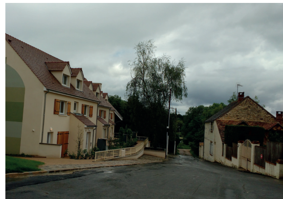
Vue de la rue après la construction
