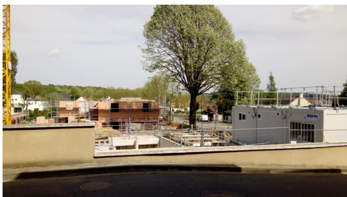
Figure 39 : travaux de construction en cours pour Moussy 4, en avril 2018
