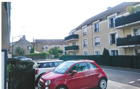
Figure 156 : pour se protéger du vis-à-vis grâce aux brise-vues à Coubert
