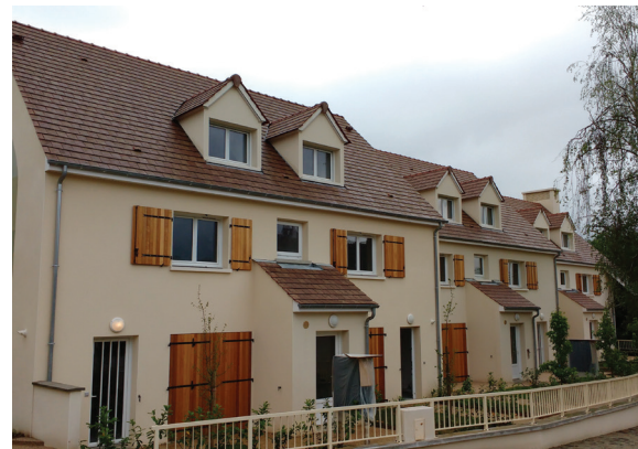
Vue de la rue après la construction
