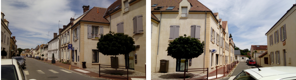
Figure 67 : Exemple d'implantation caractéristique, à Anet, une reprise des volumes des bâtiments mitoyens
