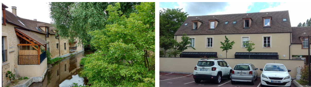
Figure 15 : Réhabilitation et construction, programme les Rives de la Vesgres à Houdan
