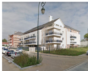
le moulin de l'Aunette Ballancourt sur Essonne 91045-1N
