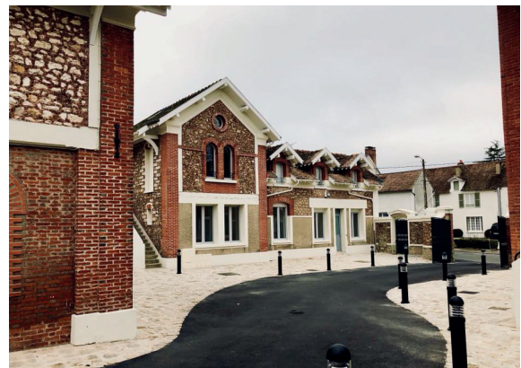
Vue de la rue après la construction
