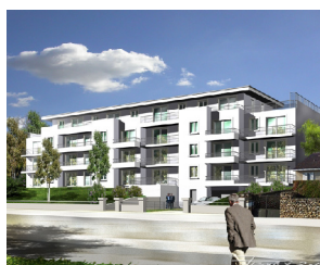
14 rue Alfred Manceau Epernon / 28140-7N
