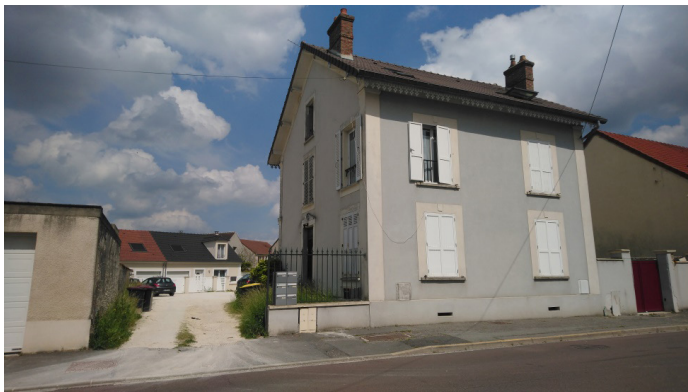
Figure 17 : Mormant, une petite opération d'autopromotion se traduisant par une densification modeste du tissu, à proximité du centre-bourg
