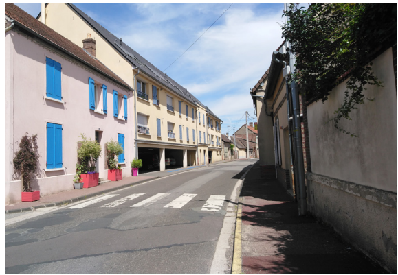
Vue de la construction
