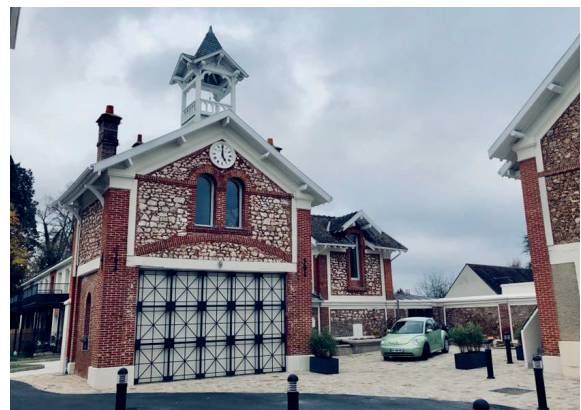
Vue de la rue après la construction
