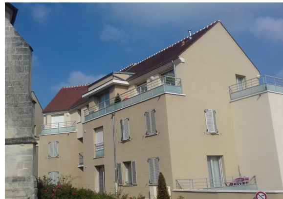
Vue de la rue après la construction
