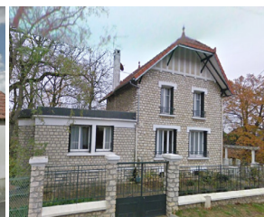
10 rue Pasteur Étréchy 91226-2R
