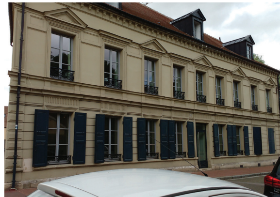
Vue de la rue après la construction
