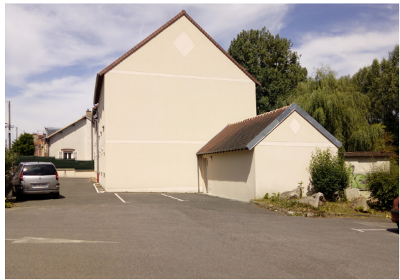
Vue après la construction
