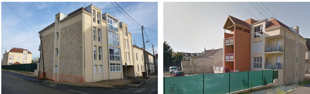
Figure 88 : Une architecture plus contemporaine avec des emprunts au « néo-village » à Trilport (rue Aveline)
