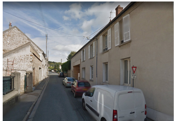
Vue de la rue après la construction
