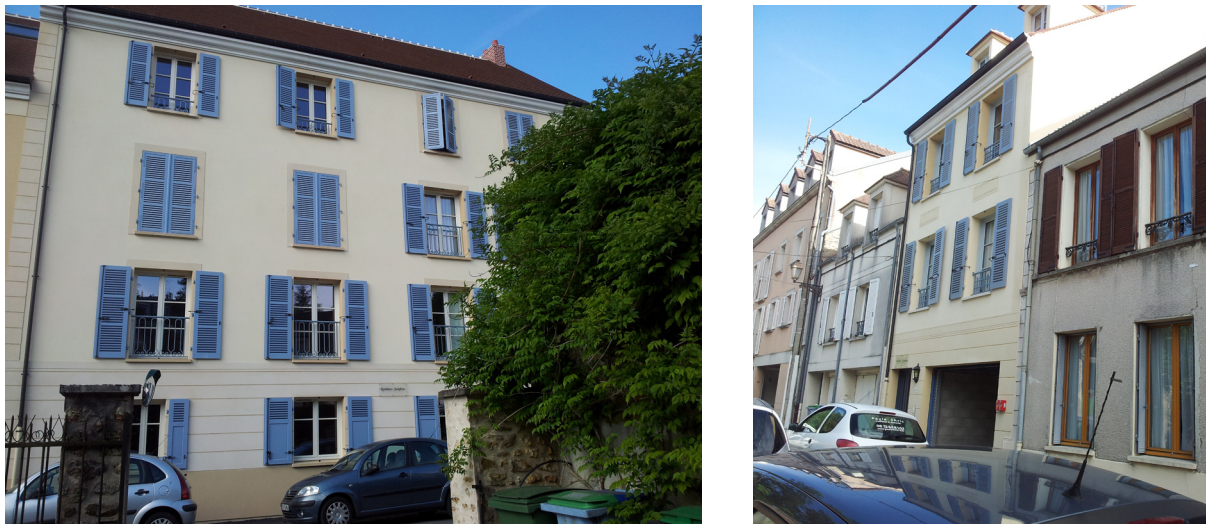
Figure 54 : La résidence Joséphine dans le centre-ville de Rambouillet (78), une architecture « néo ».
