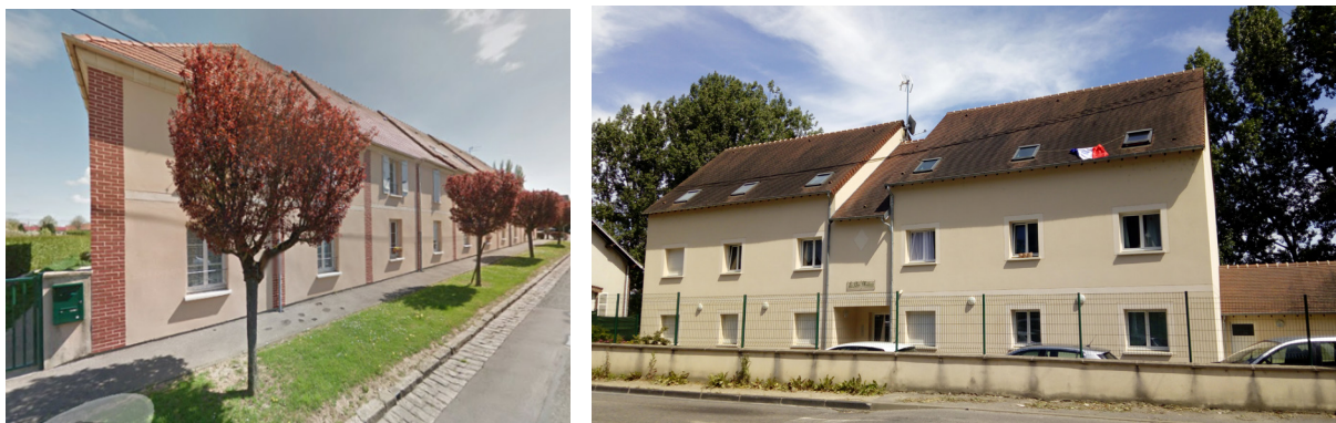
Figure 70: la brique est utilisée pour rythmer les façades à Neuilly-en-Thelles (60) (boulevard Lebegue) et Figure 71: Les modénatures sont soulignées par un enduit plus clair à Ivry-la-Bataille (27)
