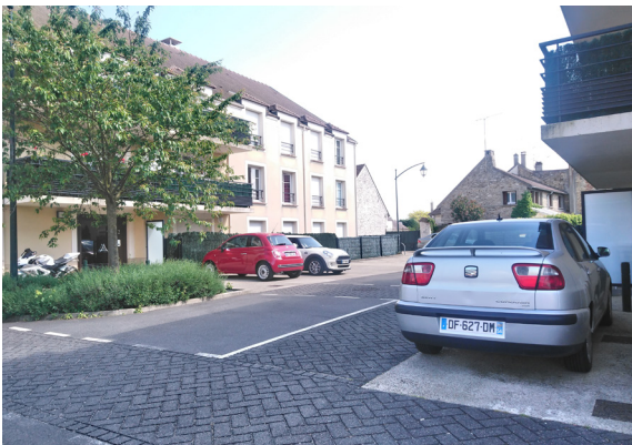
Vue de la construction
