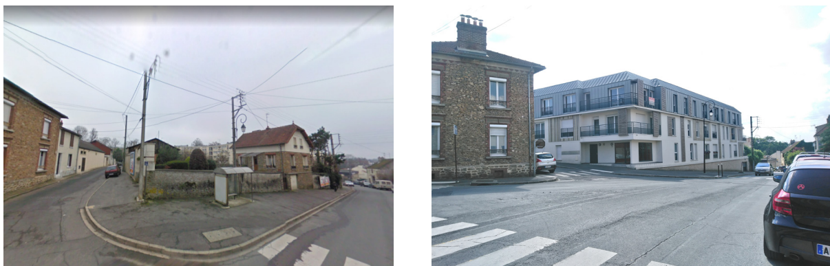
Figure 12 : Démolition reconstruction au Tournan-en-Brie, rue de la Madeleine. Photographies issues de street-view 2008 et réalisation personnelle
