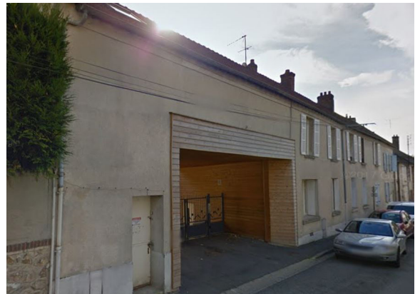
Vue de la rue après la construction
