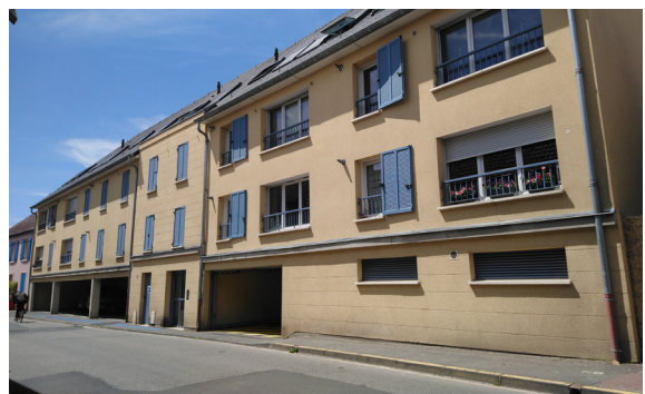
Vue de la construction
