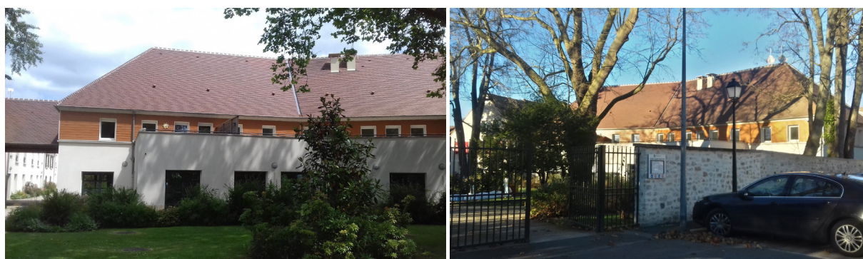
Figure 77 : Plailly, l'architecture de la Mairie la distingue des autres façades, plus « néo »
