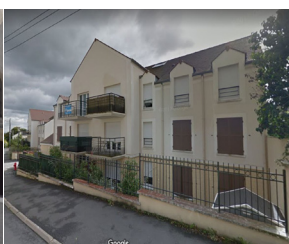
3 rue du château Nanteuil-lès-Meaux 77330-1N
