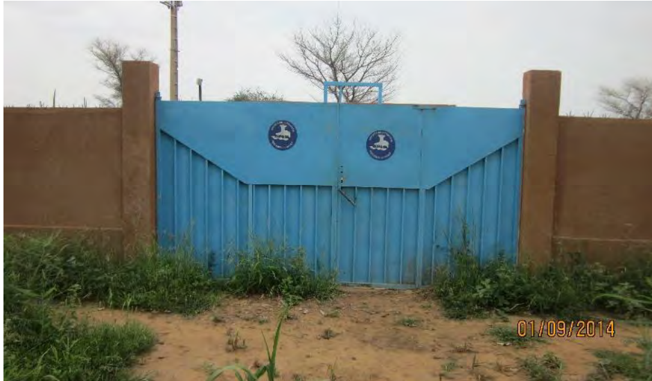
Téra Photo 51 : clôture de l'un des trois forages construits en 2010 pour augmenter la production
