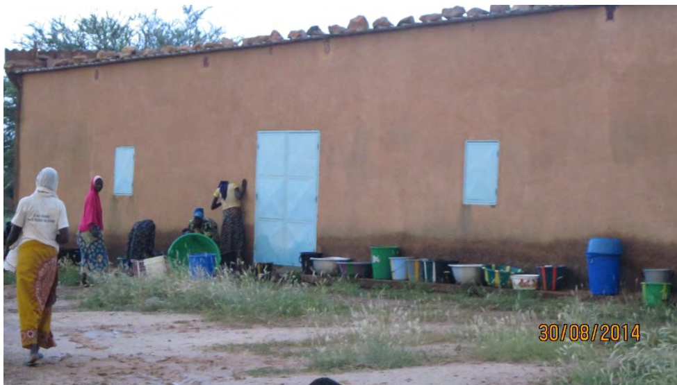
Photo 73 : La collecte des eaux de pluies à partir du toit d'une salle de cours de l'école primaire de Begorou Tondo
