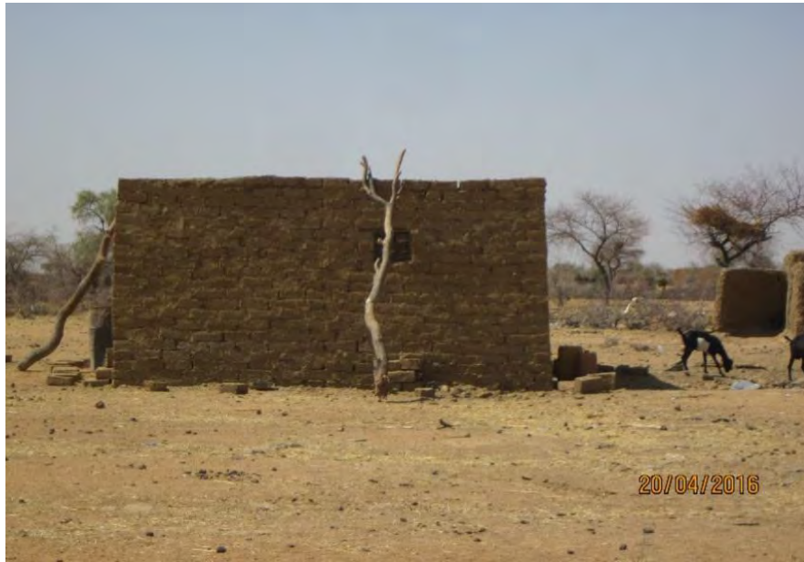
Photo 39 : la construction d'une maison en banco interrompue pour cause de problème d'eau (village de Farko Tondo)
