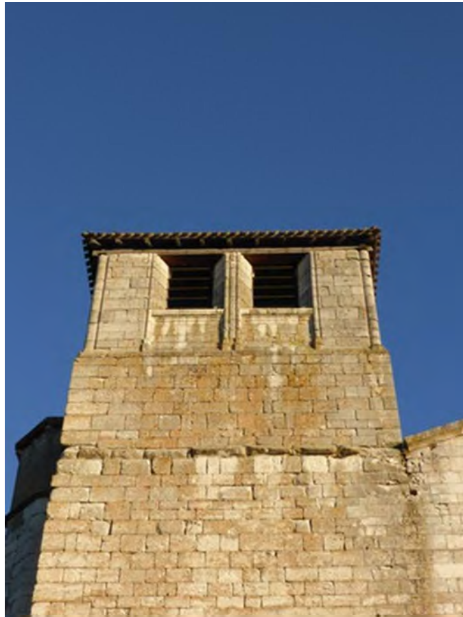
Fig. 69 : vue générale du clocher de la collégiale Saint-Martin.
