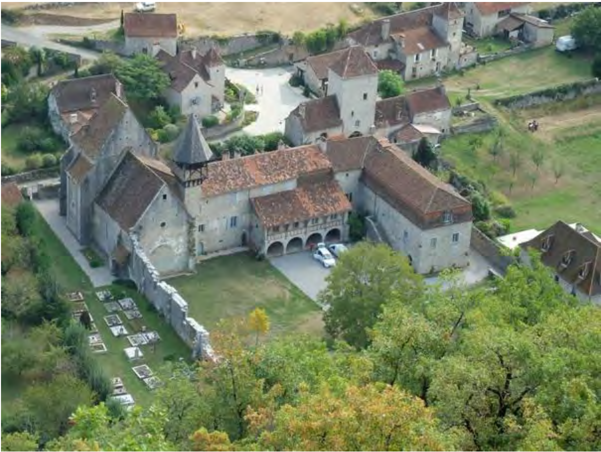
Fig. 2 : vue aérienne de l'église et du prieuré d'Espagnac-Sainte-Eulalie (Lot).
