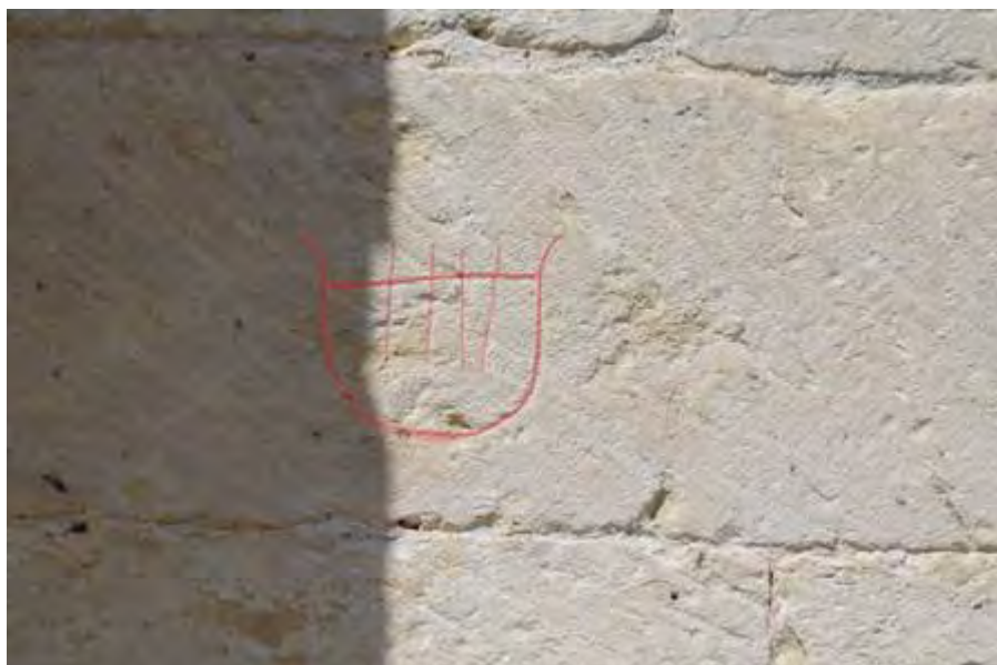
Fig. 115 : exemples de signes lapidaires sur le parement extérieur de la collégiale Saint-Martin
