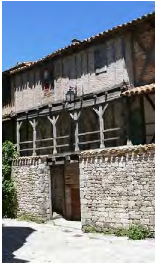
Fig. 209 : vue de la cour intérieure du collège des chanoines de Montpezat.
