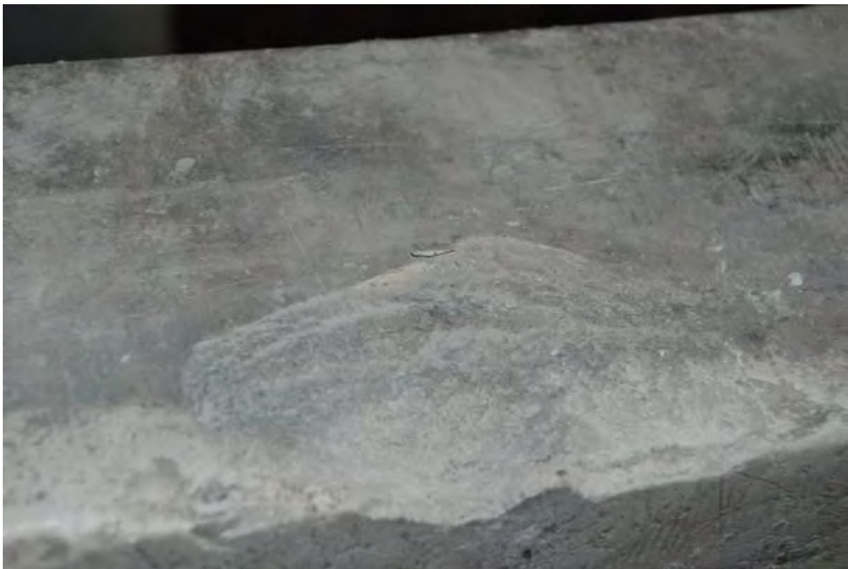
Fig. 254 : détail de l'enduit fin gris qui recouvre la table d'autel réemployée, collégiale Saint-Martin.
