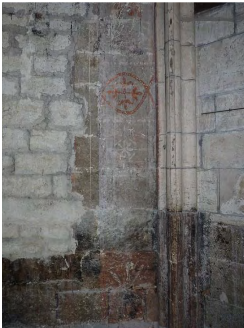
Fig. 307 : détail de l'arrêt du décor peint à droite du bouleversement dans le mur sud-est du chevet, collégiale Saint-Martin.
