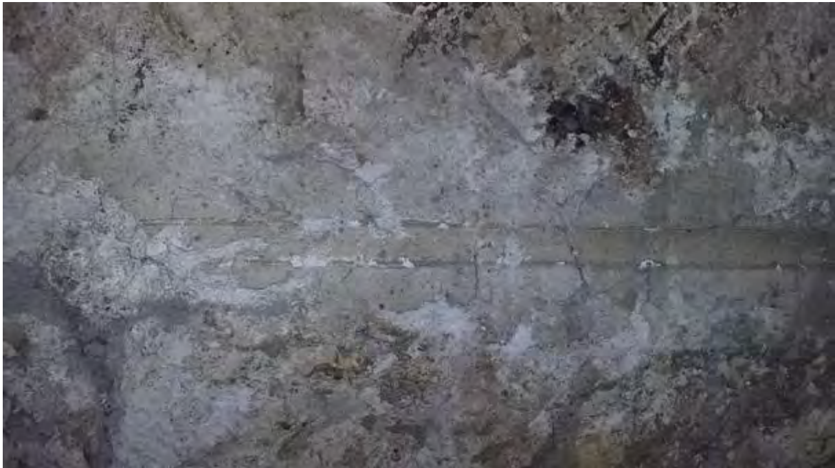
Fig. 153 : détail du joint de mortier rubané au fer, en partie basse du décor d'arcades géminées.
