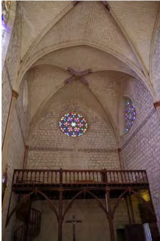
Fig. 130 : vue générale de la nef de la collégiale Saint-Pierre de La Romieu.
