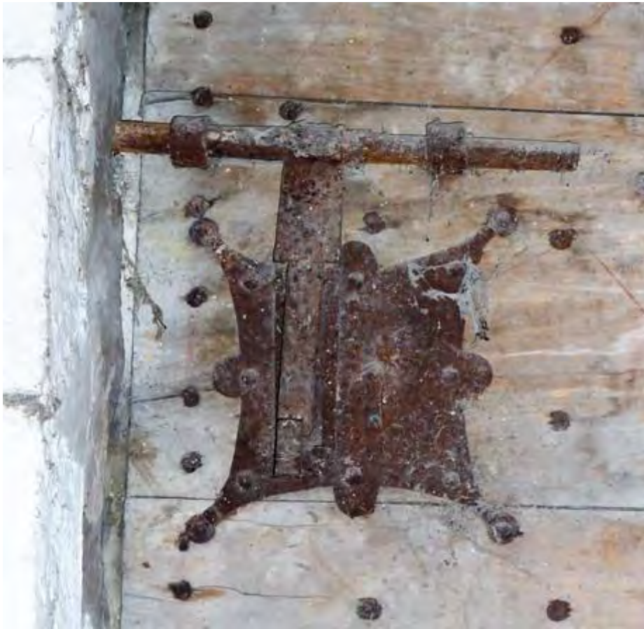
Fig. 119 : serrure à vertevelle de la porte d'accès aux toitures du bas-côté nord, Collégiale Saint-Martin.
