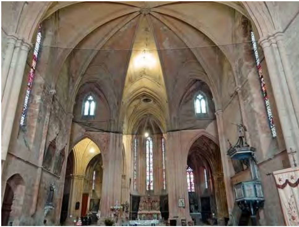
Fig. 167 : vue générale du chœur de la collégiale Notre-Dame du Vigan (Lot).
