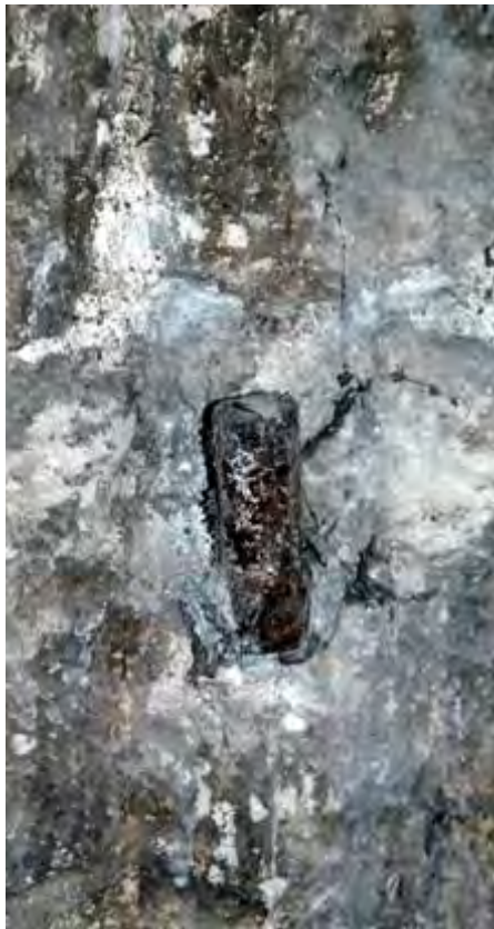
Fig. 120 : détail d'un ancien gond de porte scellé au plomb dans le mur de l'abside de la collégiale Saint-Martin.
