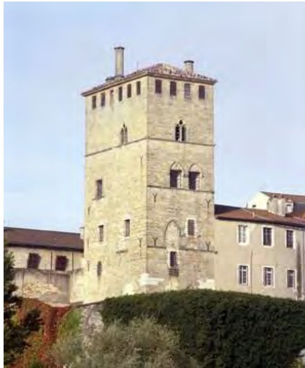
Fig. 221 : tour du palais de Via, à Cahors (Lot).
