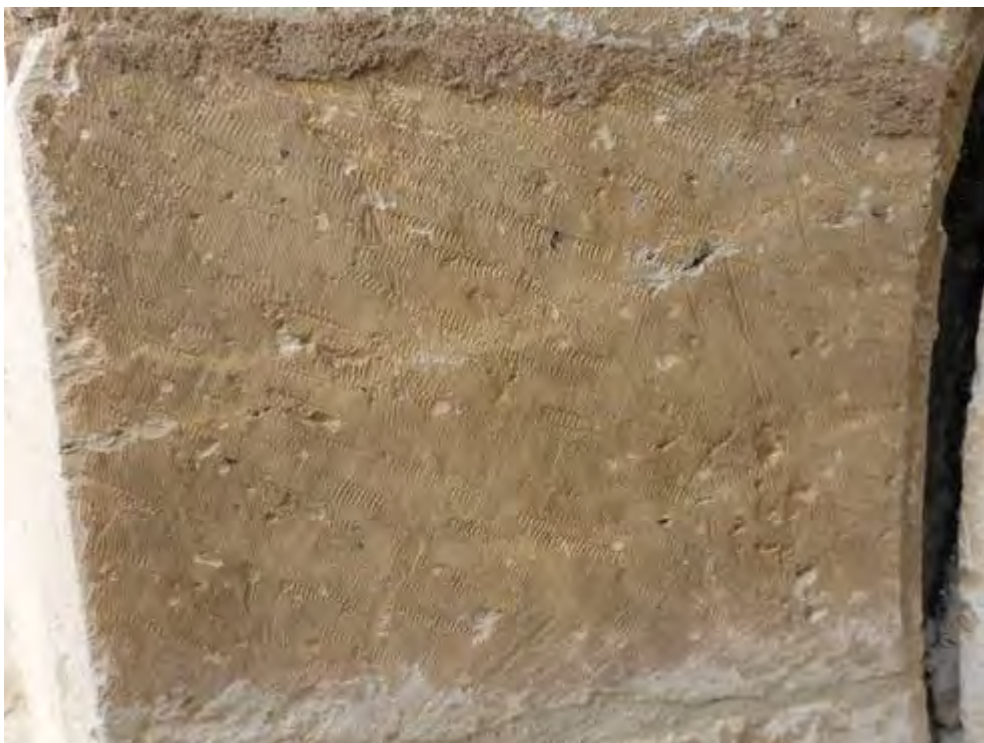
Fig. 107 : exemple de taille entrecroisée sur une des pierres de la fenêtre d'axe, collégiale Saint-Martin.
