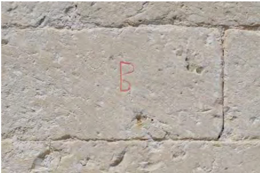
Fig. 114 : exemples de signes lapidaires sur le parement extérieur de la collégiale Saint-Martin
