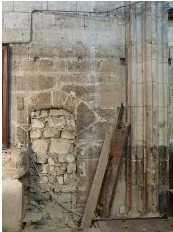
Fig. 245 : blocage de la porte de communication entre la sacristie et le chœur, réalisé avec des fragments du jubé. Collégiale Saint-Martin. État en décembre 2016.
