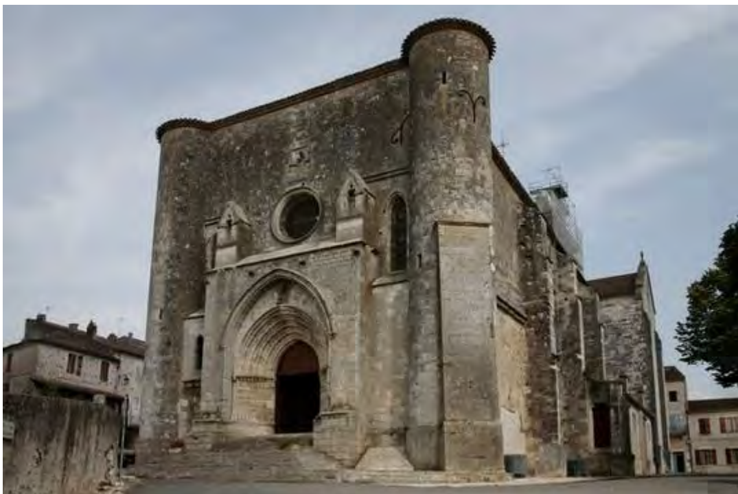
Fig. 184 : façade occidentale de l'église de Mézin (Lot-et-Garonne)
