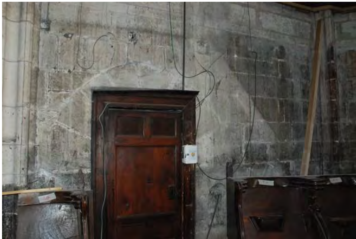
Fig. 256 : en noir, à droite, trace oblique de l'escalier qui montait à la tribune du chœur, collégiale Saint-Martin.
