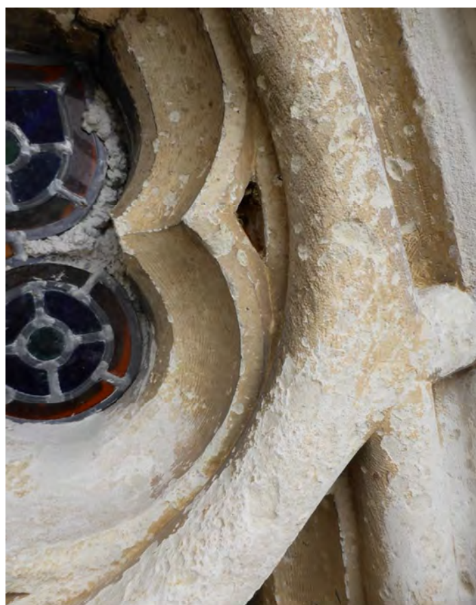
Fig. 159 : traces d'une eau-forte terre d'Ombre sur le remplage de la baie d'axe, collégiale Saint-Martin.
