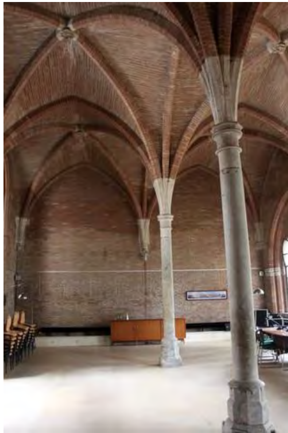
Fig. 175 : vue générale des chapiteaux et des piliers de l'ancienne salle capitulaire des Cordeliers de Toulouse.
