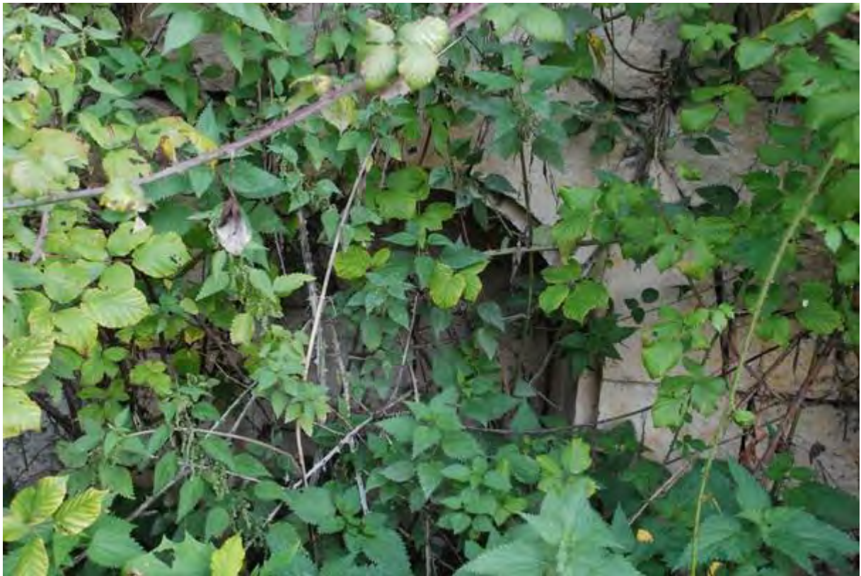
Fig ; 304 : placard dans le mur du chevet de l'ancienne église du Pouget, état en 2015.
