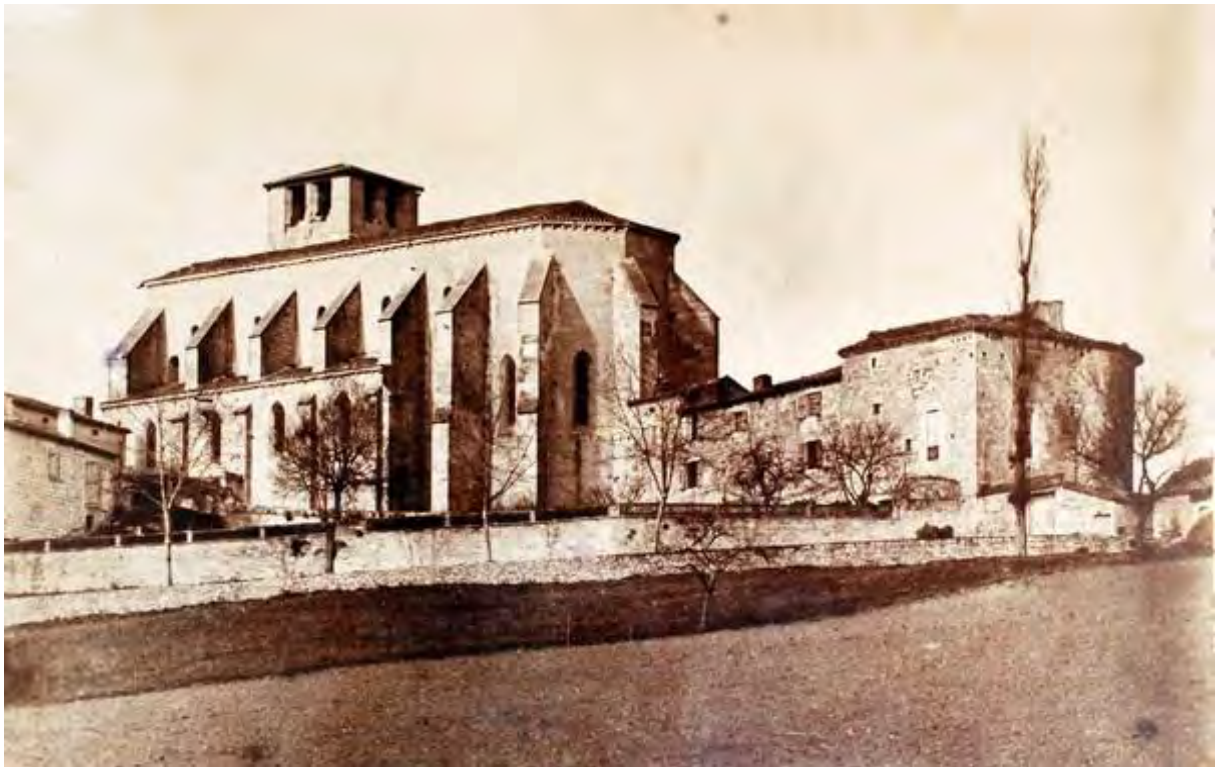
Fig. 63 : vue de la collégiale prise depuis le sud par l'abbé Faubin en 1886. Arch. Dép. Tarn-et-Garonne, fonds de la Société Archéologique.
