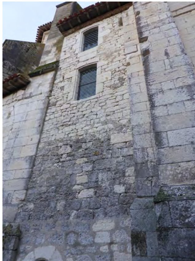
Fig. 193 : seconde sacristie construite en 1778, collégiale Saint-Martin.
