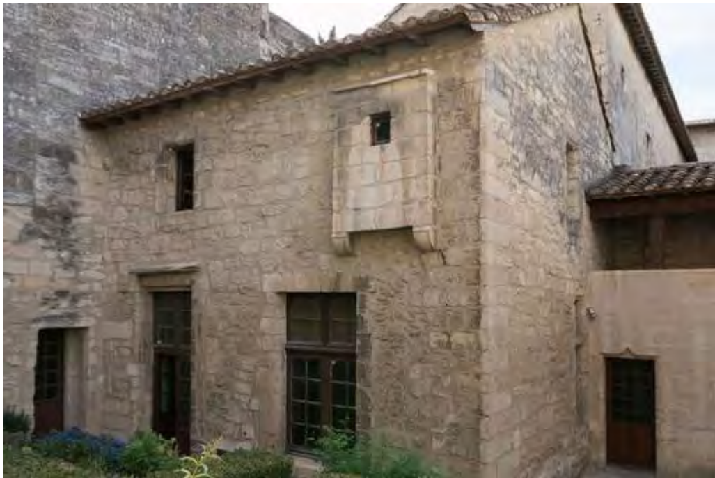
Fig. 217 : façade arrière d'une maison de Chartreux. Chartreuse du Val-de-Bénédiction, Villeneuve-les-Avignon (Gard).
