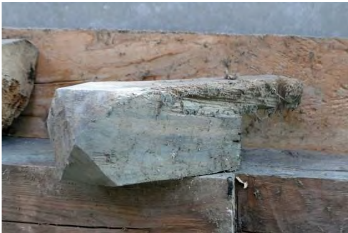
Fig. 258 : fragment du poteau de départ de l'escalier d'accès à la tribune.
