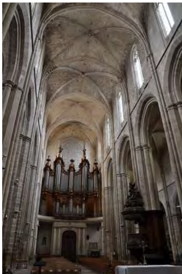
Fig. 169 : vue générale de la nef de la basilique Sainte-Marie-Madeleine de Saint-Maximin-La-Sainte-Baume (Bouches-du-Rhône)
