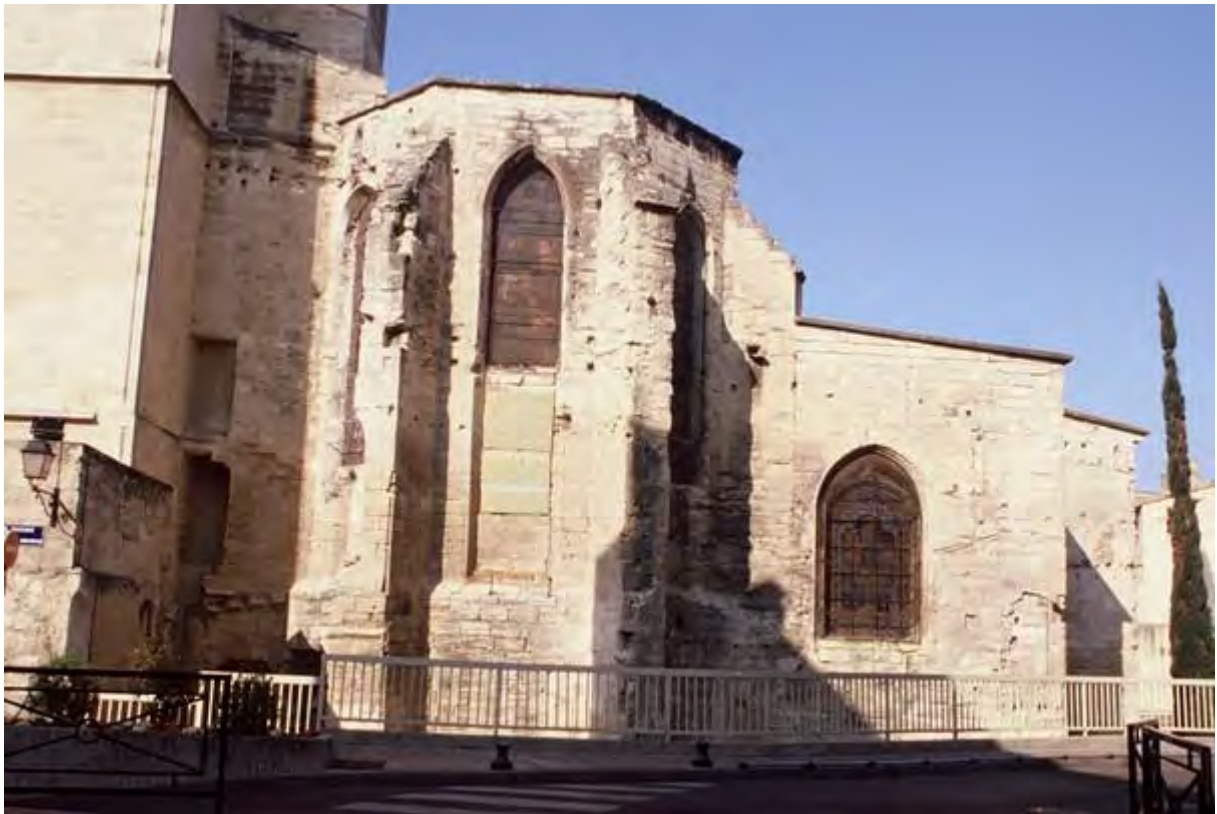
Fig. 164 : vue générale du chevet de la collégiale Saint-Agricol d'Avignon.
