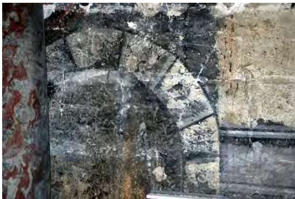
Fig. 137 : détail du décor peint mis au jour dans la quatrième chapelle nord de la collégiale Saint-Martin.
