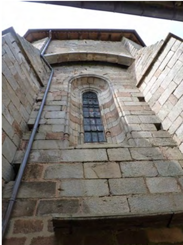
Fig. 113 : détail du parement extérieur du chevet de la collégiale de Saint-Germain-les-Belles.
