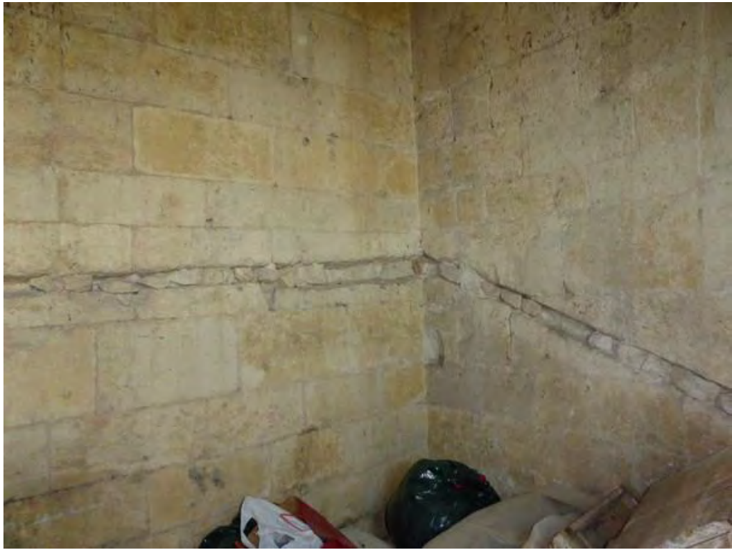
Fig. 194 : traces du solin de la sacristie construite en 1601, collégiale Saint-Martin.
