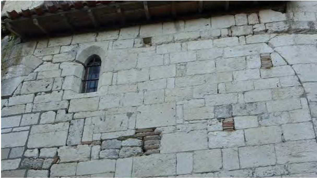
Fig. 192 : détail de la partie supérieure du mur reconstruit entre deux contrefort, au nord du chevet, de la collégiale Saint-Martin.
