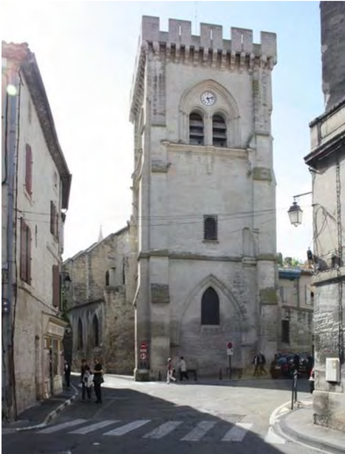
Fig. 178 : vue générale du clocher de la collégiale Notre-Dame de Villeneuve-les-Avignon.
