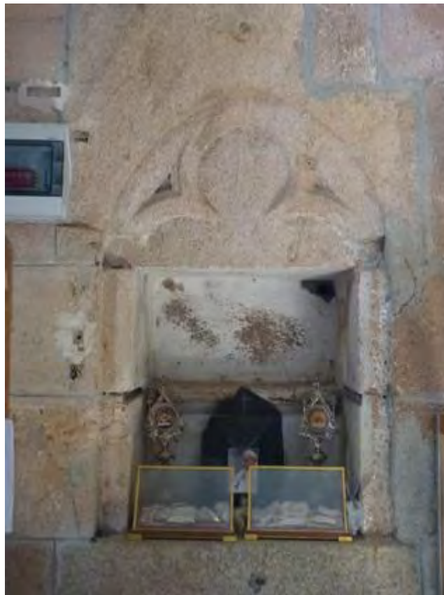
Fig. 200 : piscine liturgique, rez-de-chaussée de la tour des chanoines, collégiale de Saint-Germain-les-Belles (Haute-Vienne).
