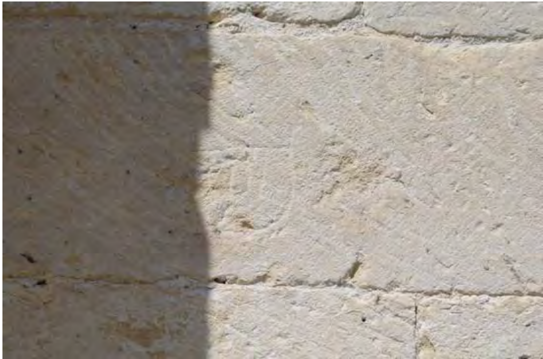
Fig. 109 : traces d'outils avec de nombreuses reprises sur un bloc du parement sud, collégiale Saint-Martin.
