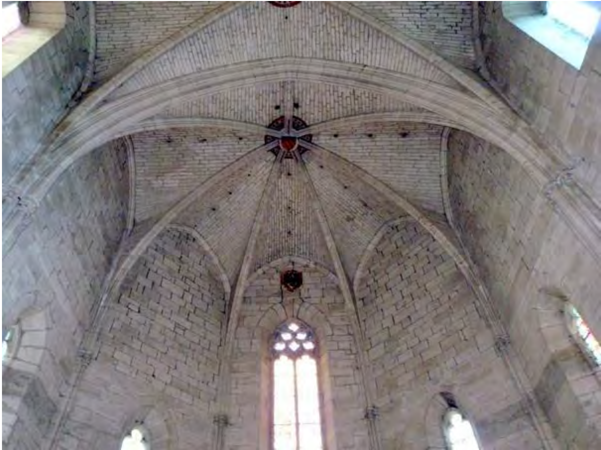
Fig. 91: vue générale du voûtement de l'abside, collégiale Saint-Martin.
