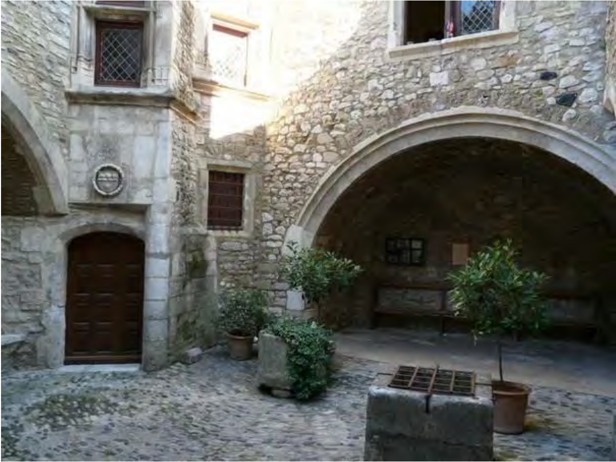
Fig. 216 : cour de la maison canoniale dite de Sampzon, Viviers (Ardèche).
