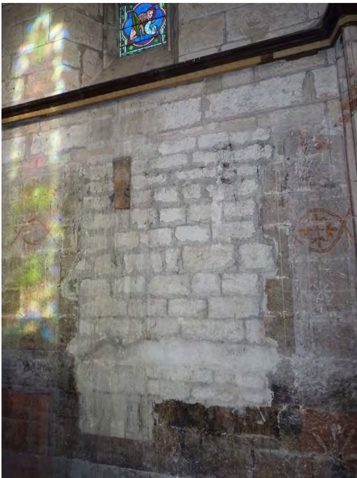
Fig. 306 : vue générale de la portion de mur du chevet remontée, collégiale Saint-Martin.
