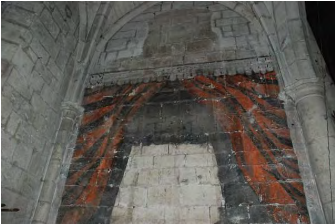
Fig. 139 : vue générale du décor peint mis au jour dans la quatrième chapelle nord de la collégiale Saint-Martin.
