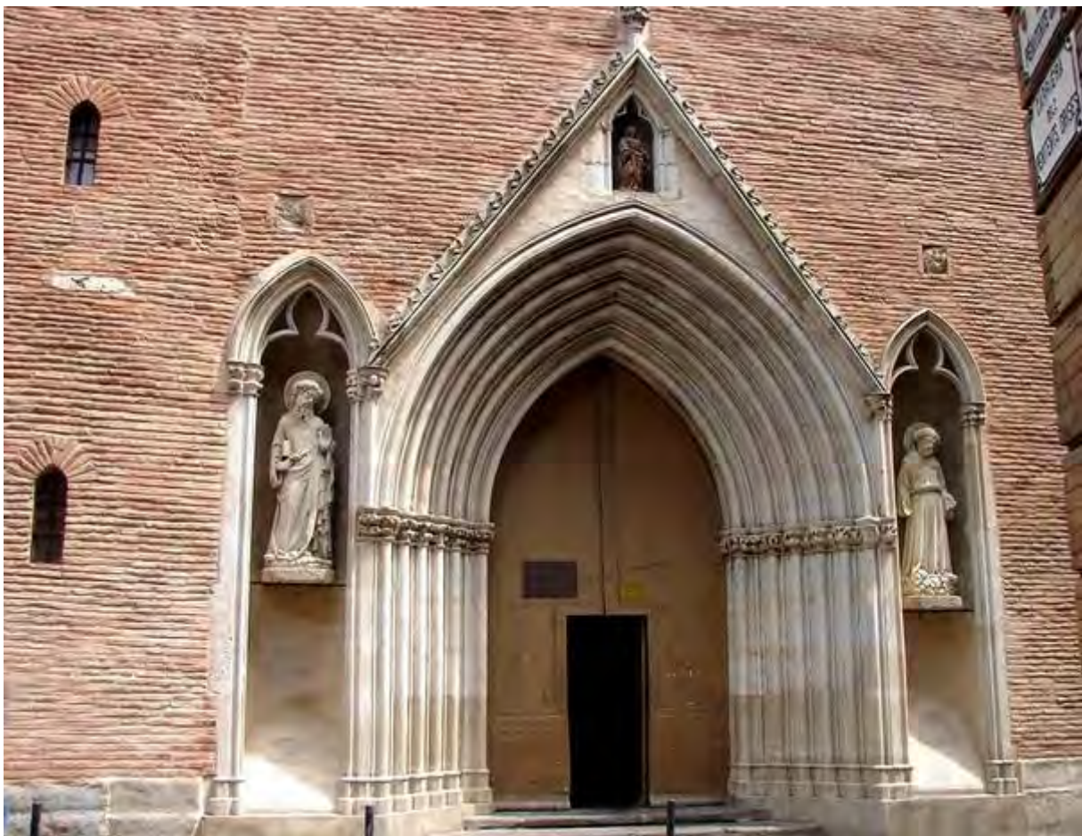
Fig. 182 : vue générale du portail de l'église Notre-Dame-du-Taur de Toulouse.
