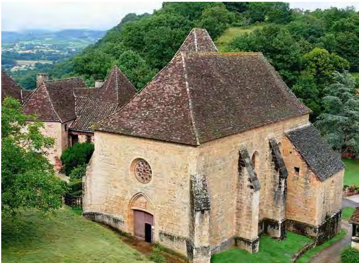
Fig. 41 : collégiale Saint-Jean-Saint-Louis de Castelnau-Bretenoux.
