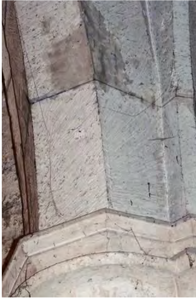
Fig. 108 : exemple de taille en éventail sur une des pierres des retombées des voûtes, chapelle nord, collégiale Saint-Martin.
