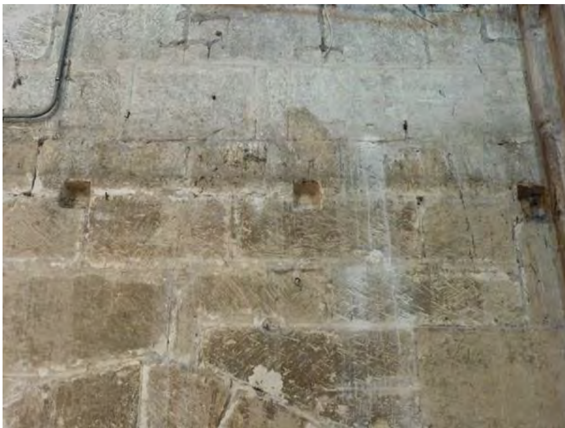
Fig. 255 : détail des trous de dépochement de la tribune, sur le mur nord du chevet de la collégiale Saint-Martin.
