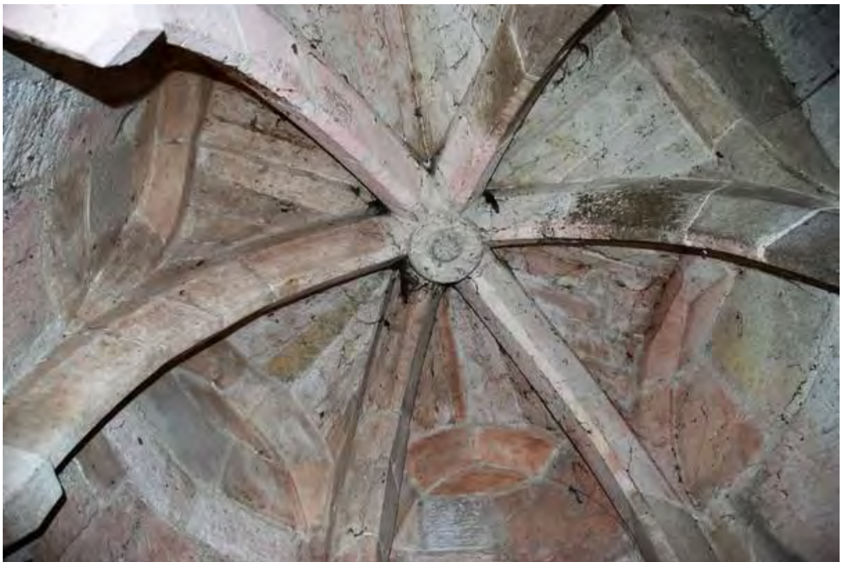
Fig. 70 : vue du voûtement de la tourelle d'escalier du clocher.
