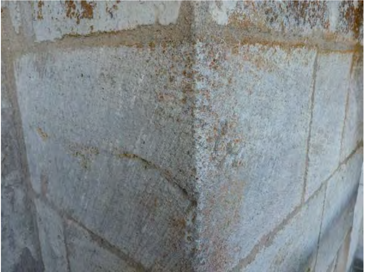
Fig. 106 : exemple de taille oblique de la pierre sur le parement extérieur d'un contrefort de la nef côté nord, collégiale Saint-Martin.
