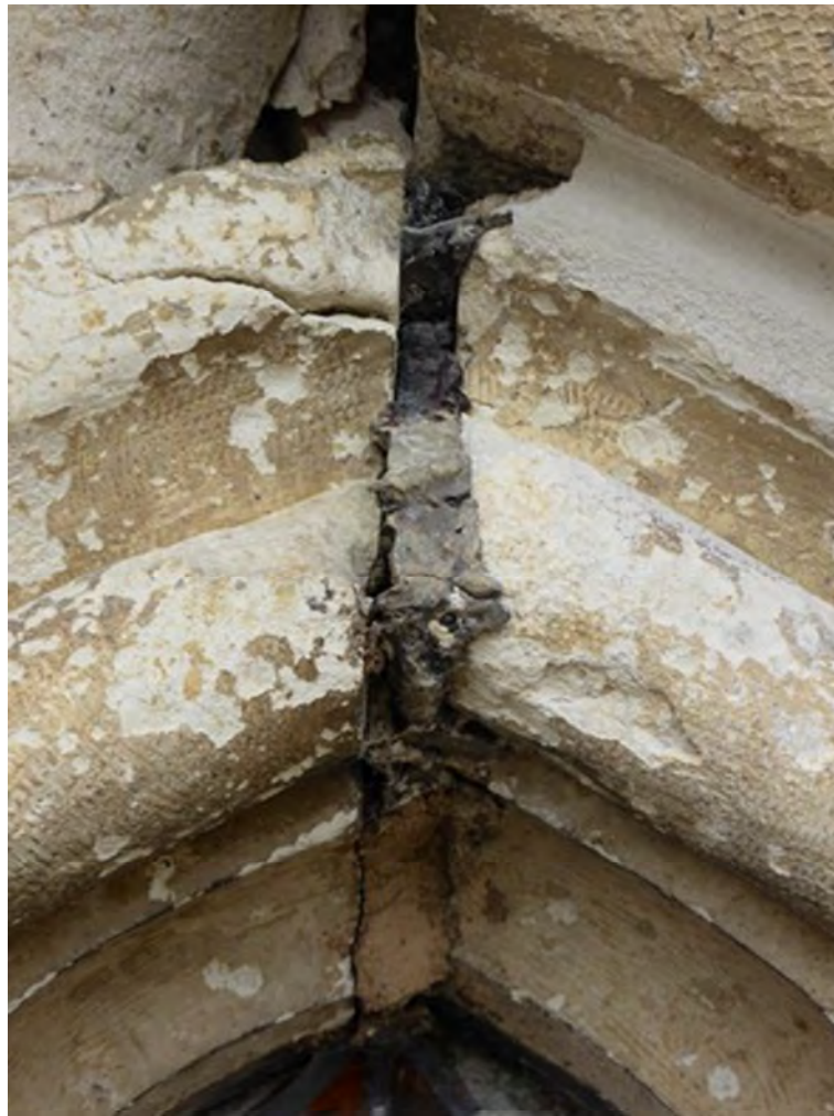
Fig. 121 : détail des scellements au plomb du remplage de la fenêtre d'axe de la collégiale Saint-Martin.
