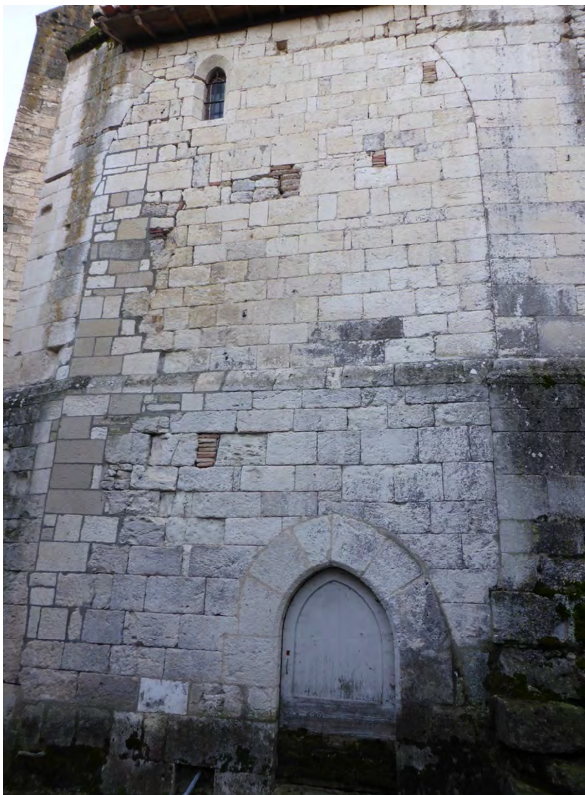
Fig. 191 : vue générale du mur reconstruit entre deux contrefort, au nord du chevet, collégiale Saint-Martin.
