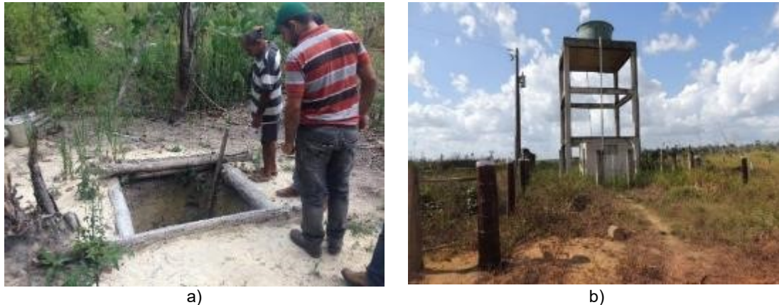
Figure 87. a) Puits creusé à la main dans une exploitation dans l'invasion Oriente. b) Forage d'eau et réservoir réalisé par l'INCRA, dans la localité de Perac, assentamento Camapuã . Photos : Osis, R. (2016).
