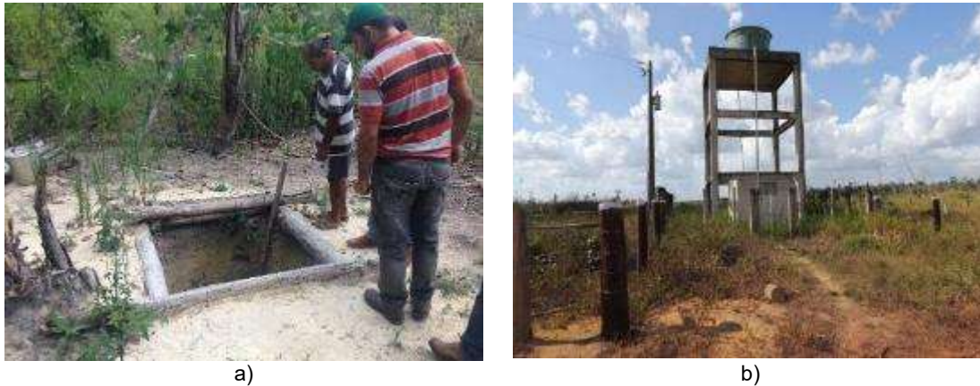
Figure 87. a) Puits creusé à la main dans une exploitation dans l'invasion Oriente. b) Forage d'eau et réservoir réalisé par l'INCRA, dans la localité de Perac, assentamento Camapuã . Photos : Osis, R. (2016).
