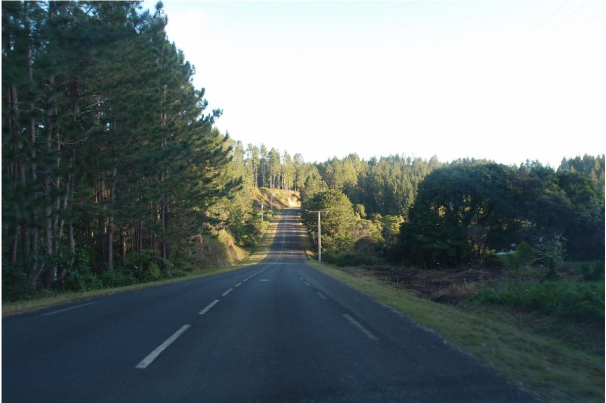
Photo n°20 : La transversale Koné-Tiwaka au niveau de la tribu de Bopope : à gauche le Plateau de Tango reboisé en Pinus , à droite les terres de la tribu. (Photo de l'auteure, novembre 2012)
