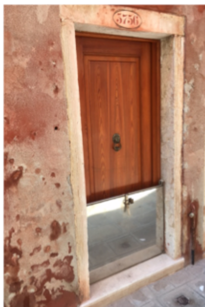
Photo 8 – La mise en place de batardeau anti-inondation à Venise (© F. Castagnola, 2018)
