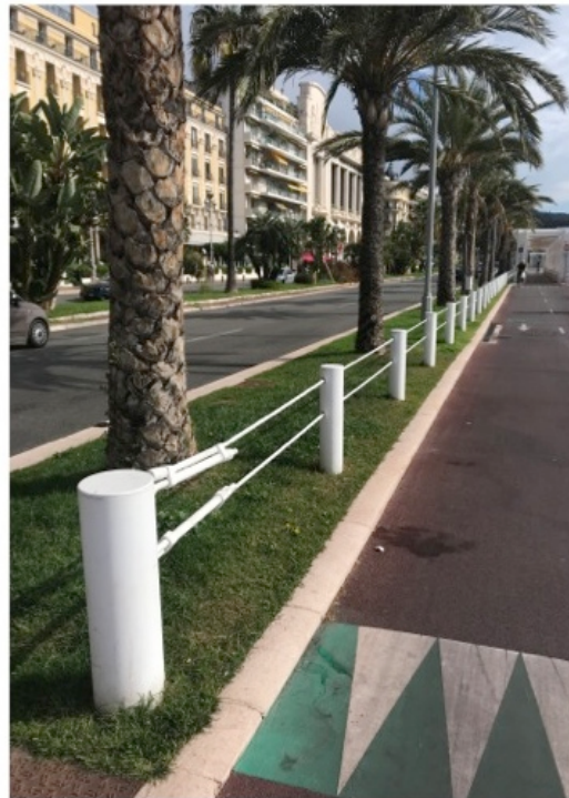
Photo 1 - Un dispositif anti-intrusion sur la Promenade des Anglais (© D. Provitolo, 2019)
