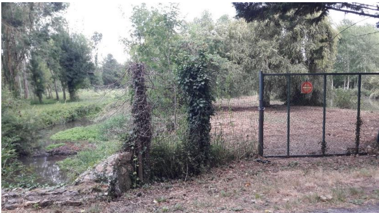
Figure 28. Interdiction d'accès aux rives du Couasonn marquée par une clôture et un panneau de signalisation - Commune de Fontaine-Guérin (GP - 24/07/2018)
