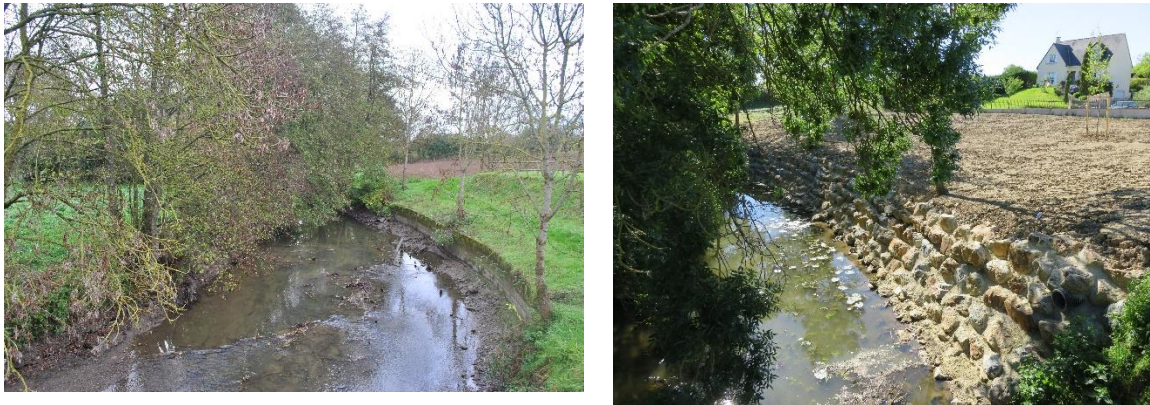
Figure 138. g. L'Aubance canalisée à Saint-Mélaine-sur-Aubance avant les travaux (18/11/2015, GP) ; d. Pendant les travaux (15/05/2019, GP)
