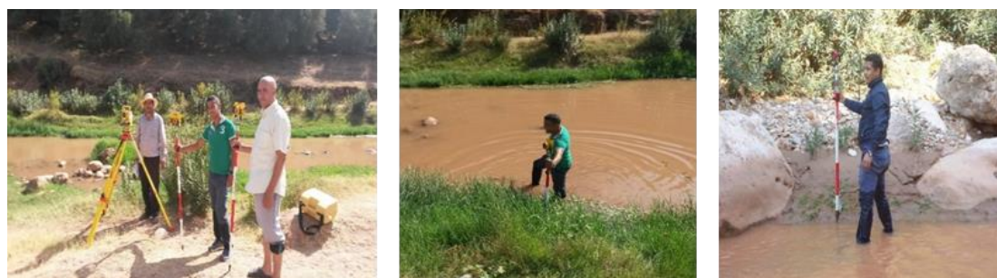
Planche photos 5.2 : Levés de profils en travers par tachéomètres.
