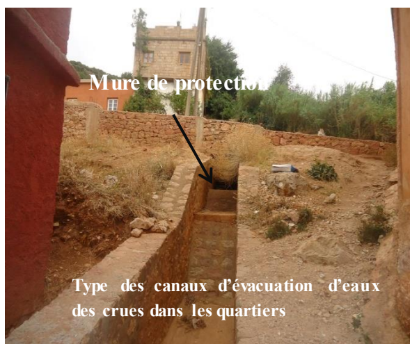
Planche photos 9.1 : Vue sur les aménagements contre les inondations dans la ville de El-Ksiba.
