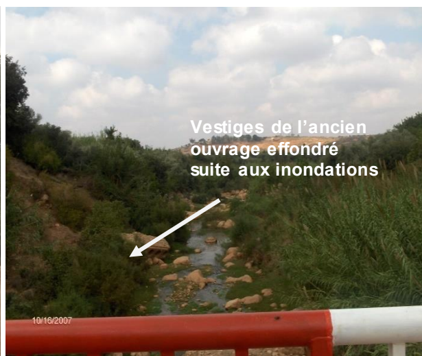
Influence des inondations sur le pont reliant les douars Takhamist et Taghzirt sur l'Oued Derna.
