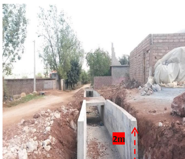
Canal de protection de la ville d'El-Ksiba contre les crues centennales avec une hauteur de 2 m et une largeur de 1.50m
