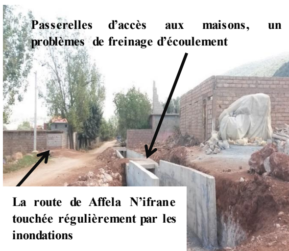
Canal de protection de la ville d'El-Ksiba contre les crues centennales avec une hauteur de 2 m et une largeur de 1.50m
