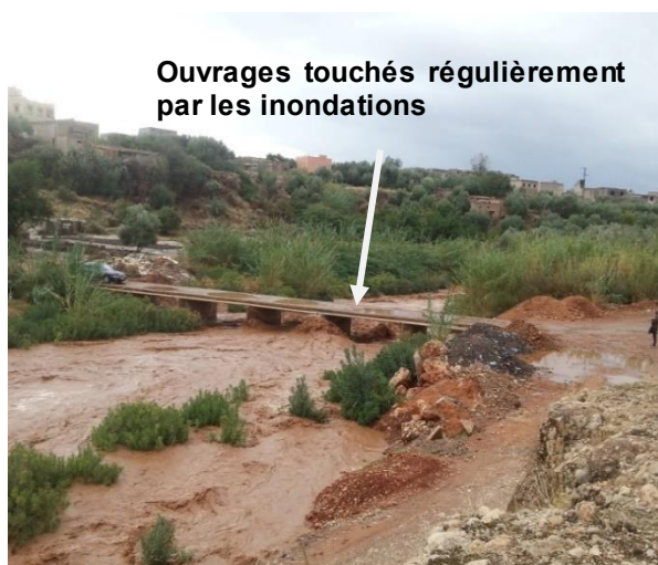
Influence des inondations sur le pont reliant les douars foug Zaouiat et Taghzirt sur l'Oued Derna.
