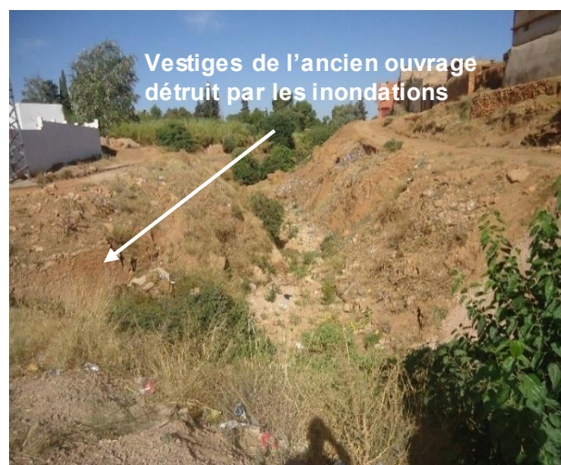
Influence des inondations sur le pont reliant Elksiba et Zaouit Echeik sur l'Oued de Aghbalou n'ou Hlima
