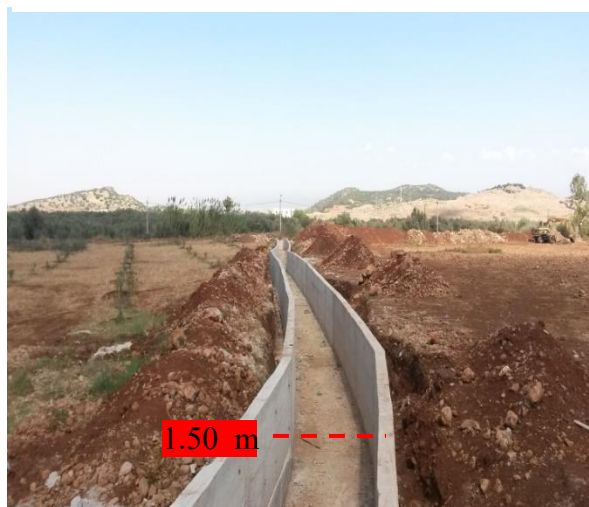
Canal de protection de la ville d'El-Ksiba contre les crues centennales avec une hauteur de 2 m et une largeur de 1.50m
