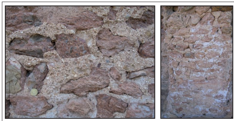
Figure B.16. Moellons en croûte calcaire dans les murs des thermes de Jebel Oust.
