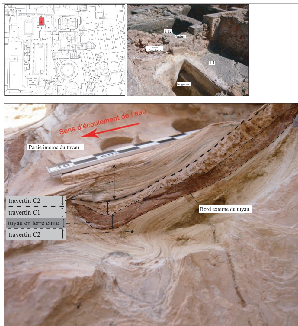
Figure B.100. Analyse géoarchéologique du tuyau d'eau tiède de la salle T4 des thermes ; en haut : situation de la salle T4 et du tuyau provenant de T12 ; en bas : analyse stratigraphique du remplissage sédimentaire du tuyau.
