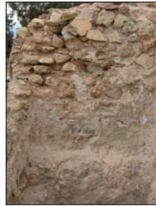
Figure B.21. Utilisation du travertin dans le mur de la salle T5I des thermes.
