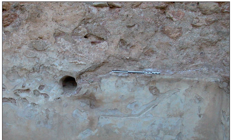
Figure B.108. Dépôt de travertins sur les dalles murales cassées de la salle T15 des thermes de Jebel Oust.
