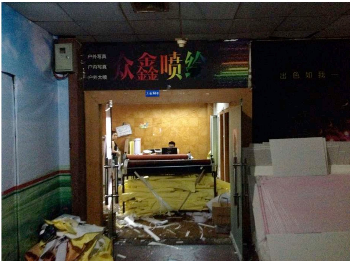
État des locaux (exemples) à l'intérieur du même bâtiment (juillet 2014).
