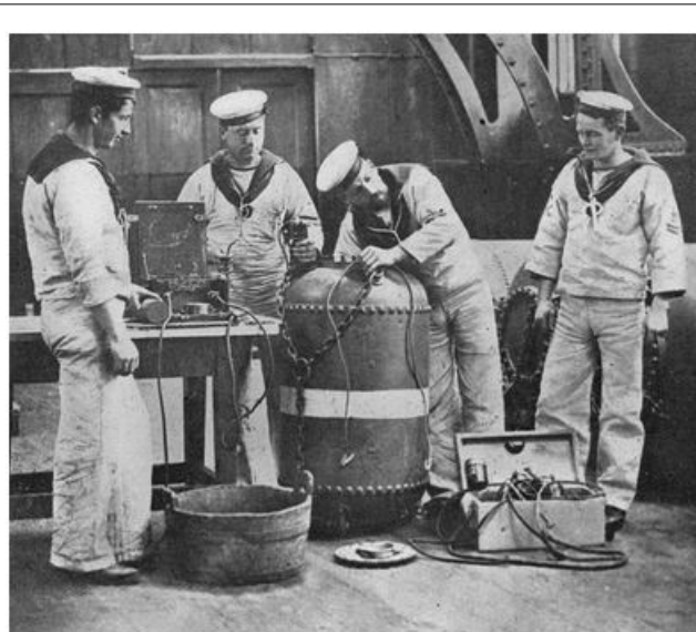
Illustration 90 : Réglage d'une mine à contact électrique 1914
