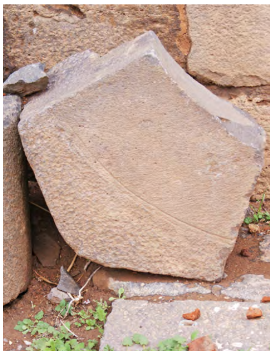
Ph. 77. Bâtiment nord. Clé d'arc conservée dans la cour
