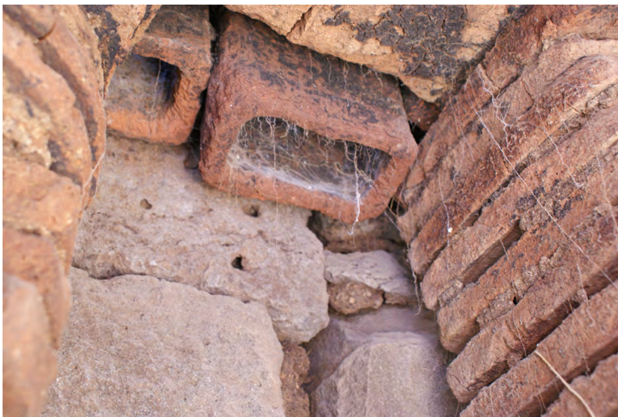
Ph. 114. Les bains. Le sous-sol des hypocaustes L. 037. Tubulures en place
