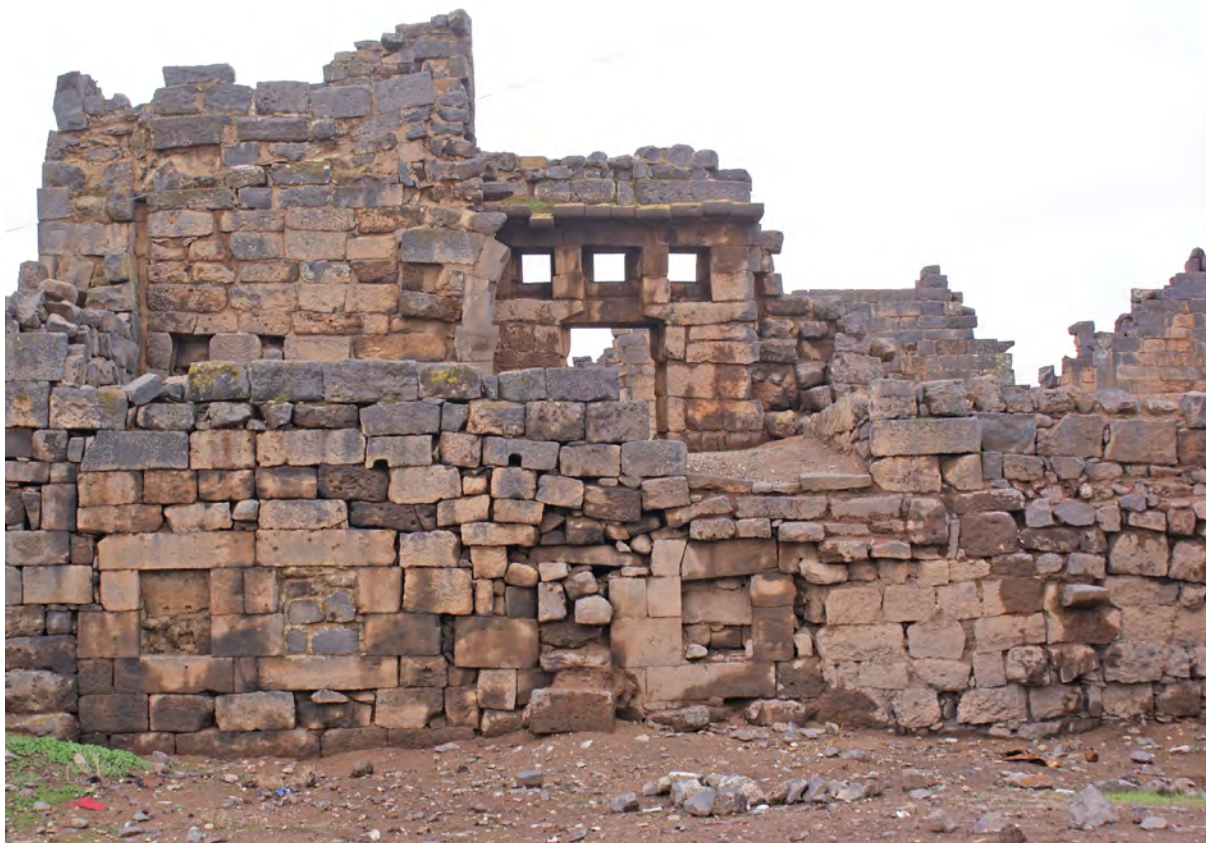
Ph. 82. Bâtiment nord. Façade nord extérieure
