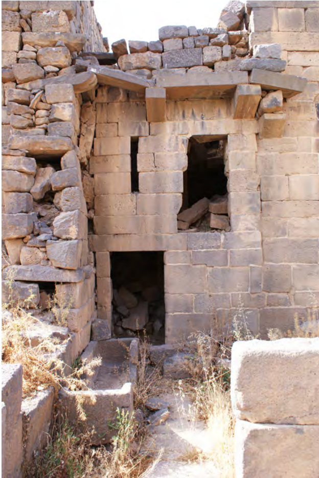
Ph. 27. Bâtiment nord. Façade extérieure de l'escalier L.006
