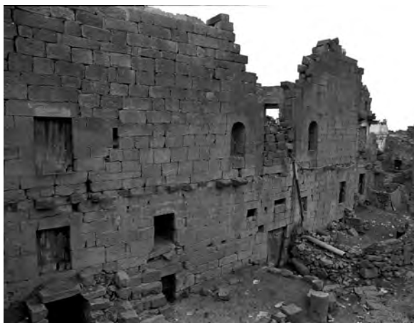
Façade du bâtiment sud, sur cour
