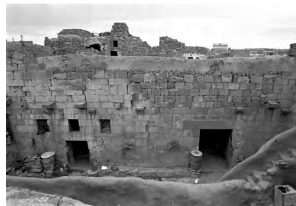
Façade du bâtiment nord sur cour
