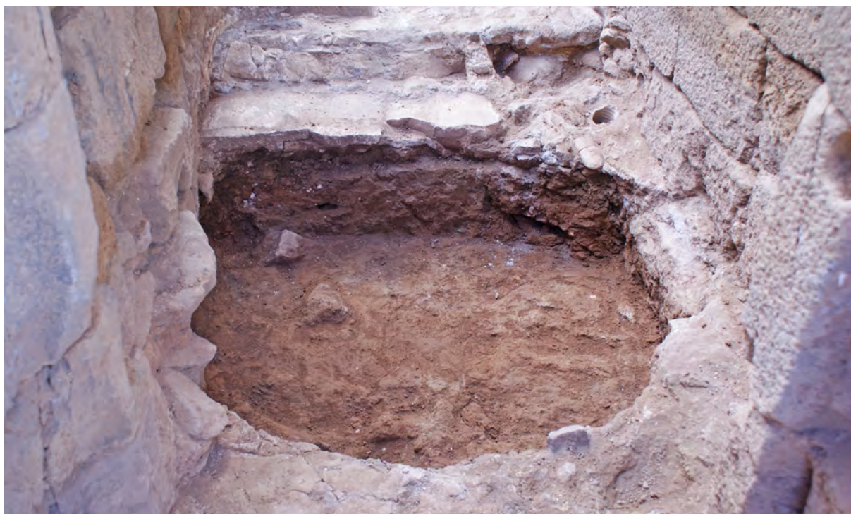
Ph. 154. Le « Palais de Trajan ». Radier du dallage en calcaire dans L. 007 : épaisse couche de terre argileuse, chape de mortier, dallage
