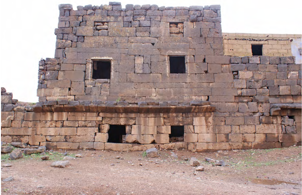
Ph. 10. Bosra, façade extérieure de la maison 2 « Saint-Serge »
