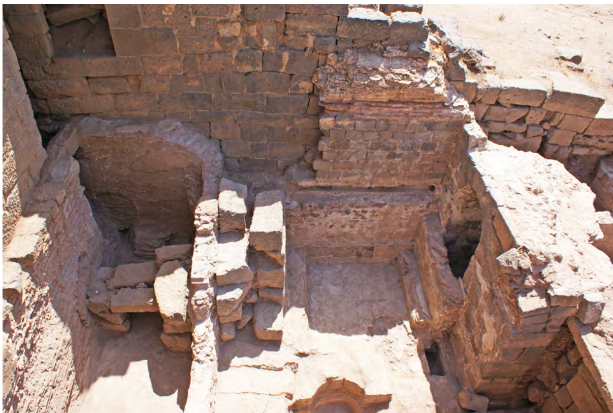
Ph. 104. Les bains. Salle L. 036, moellons de basalte et briques de la voûte
