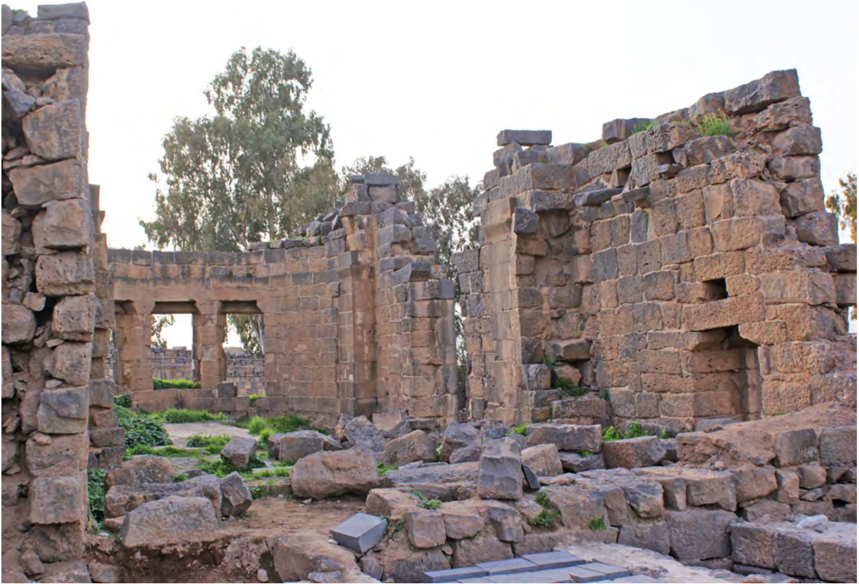
Ph. 55. Bâtiment sud. Vue intérieure de la pièce L. 223, vers l'ouest
