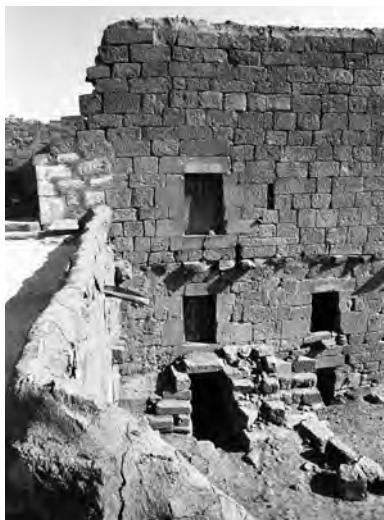
Façade du bâtiment sud sur cour
