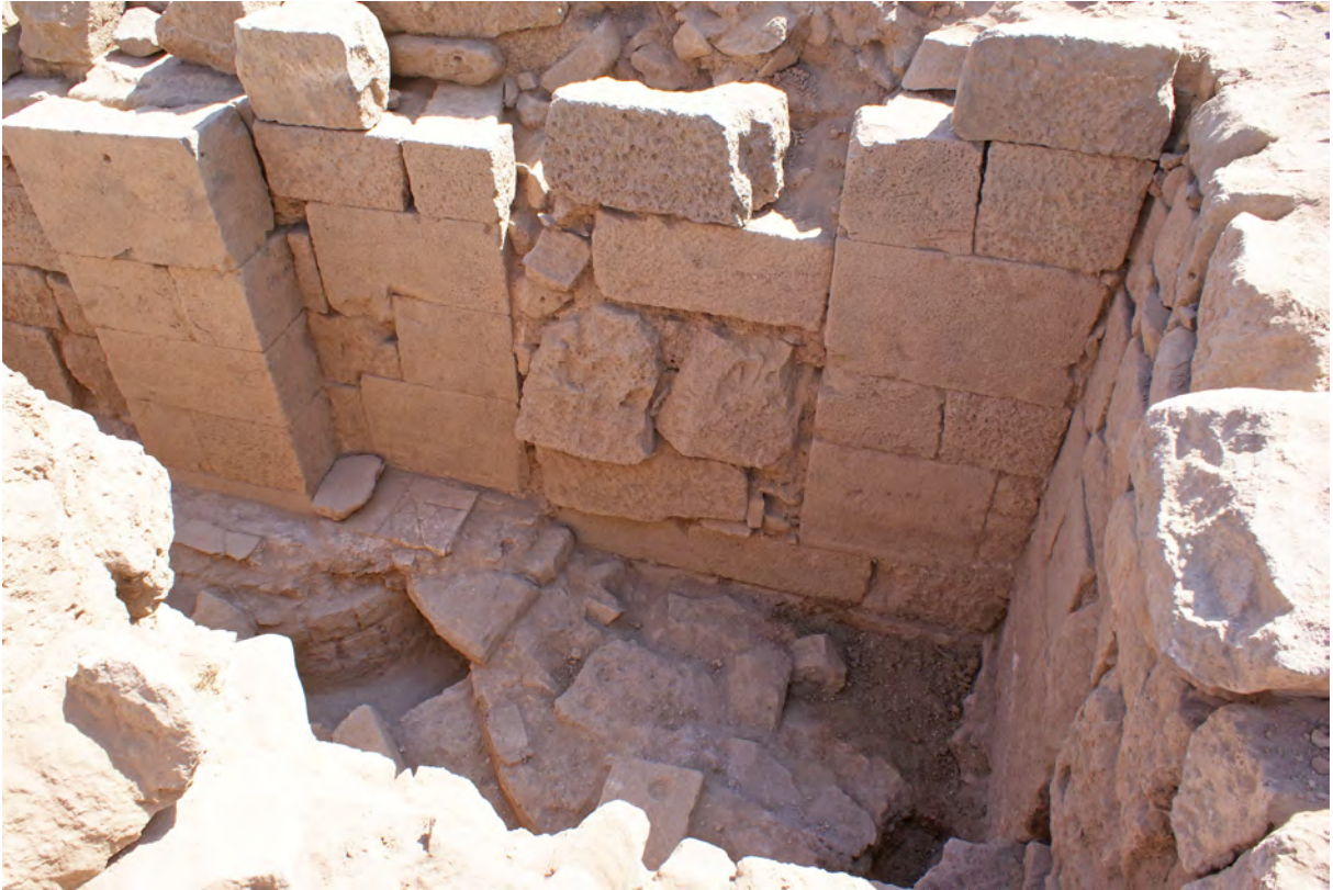
Ph. 95. Les bains. Porte des latrines L. 031 depuis L. 030, vers le sud
