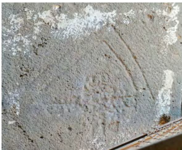
Ph. 171. Bâtiment nord. Croix ornant un pilastre de la salle L. 008 (Z. al-Mukdad 2015)
