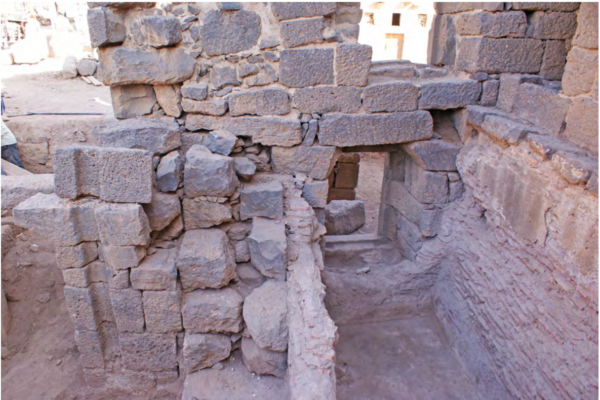
Ph. 134. Les bains. Mur oriental des bains et mur nord de la citerne L. 035, vers le nord
