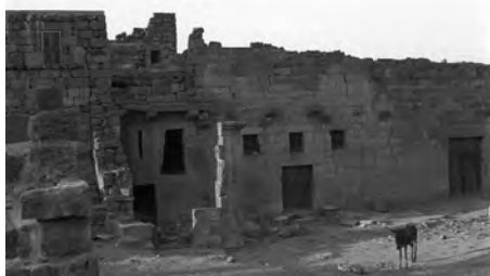
Façade du bâtiment nord sur cour
