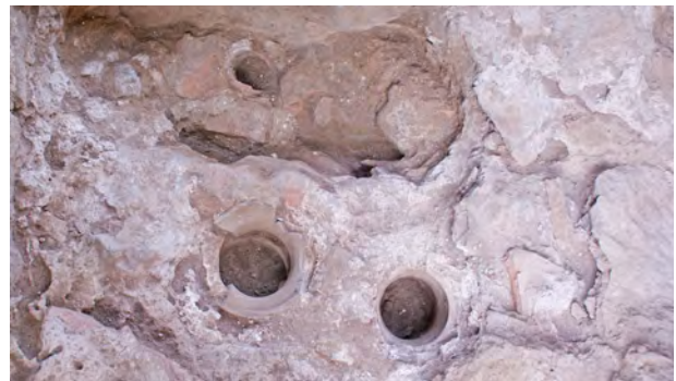
Ph. 124. Les bains. Dans l'épaisseur de la porte de L. 035, trois tuyaux verticaux
