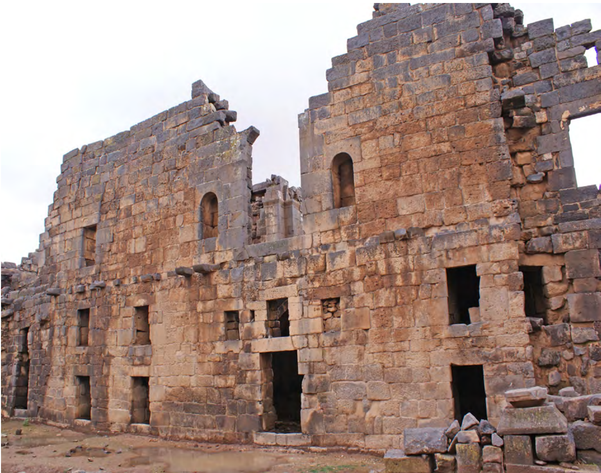
Ph. 26. Bâtiment sud. Façade sud sur cour
