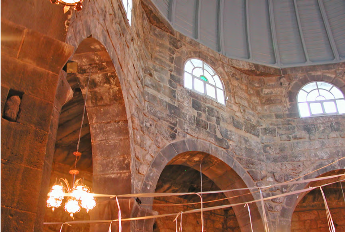
Ph. 213. Ezra'. Vue intérieure du sommet du tambour de l'église Saint-George
