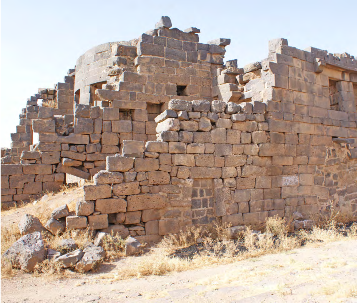
Ph. 44. Bâtiment sud. Angle sud-ouest extérieur
