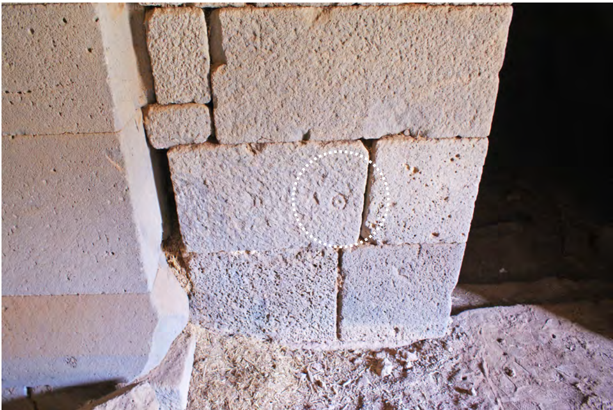
Ph. 72. Le « Palais de Trajan ». Marque de tailleur 1 dans la façade ouest du bâtiment est, salle L. 010
