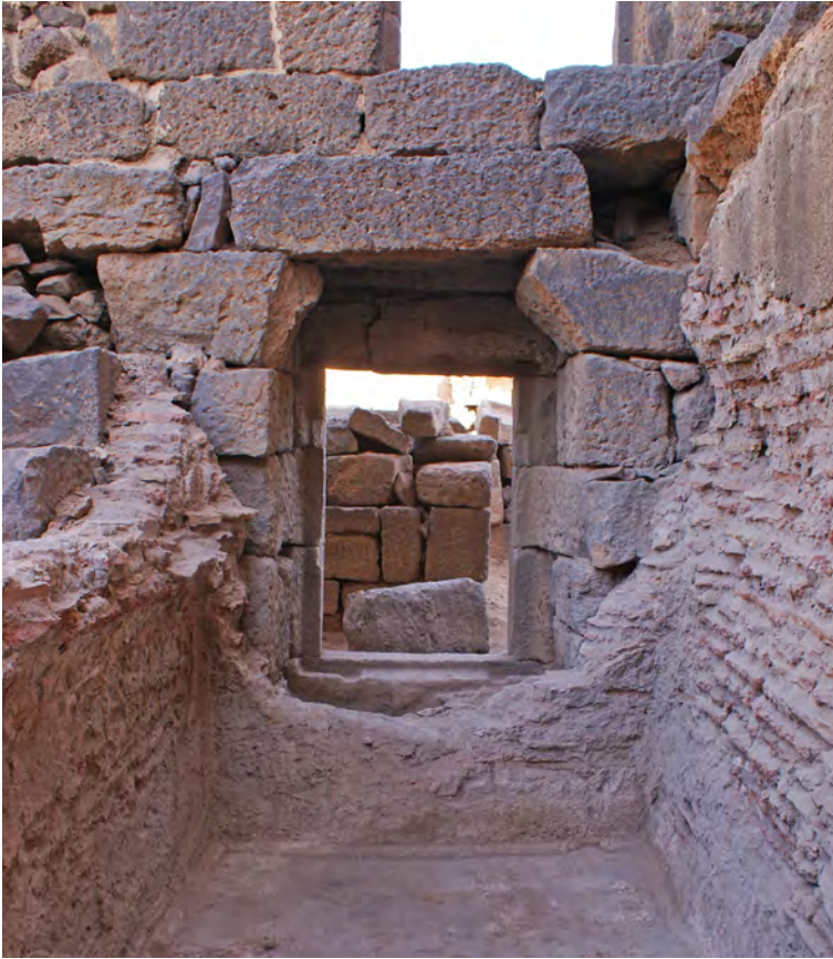
Ph. 121. Les bains. Vue générale de la citerne L. 035, vers le nord
