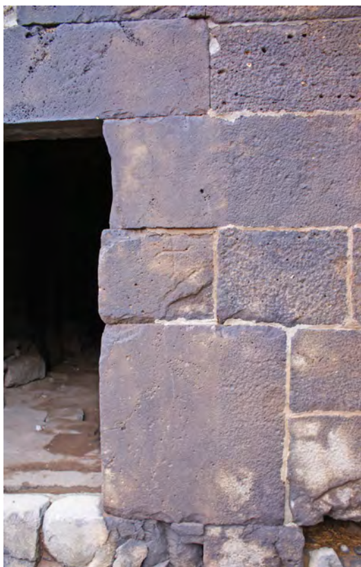
Ph. 80. Bâtiment nord. Encadrements des baies. Porte de L. 010
