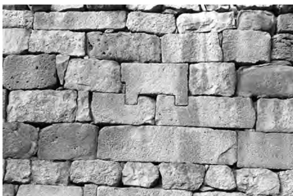
Blocs à crossette, en remploi
