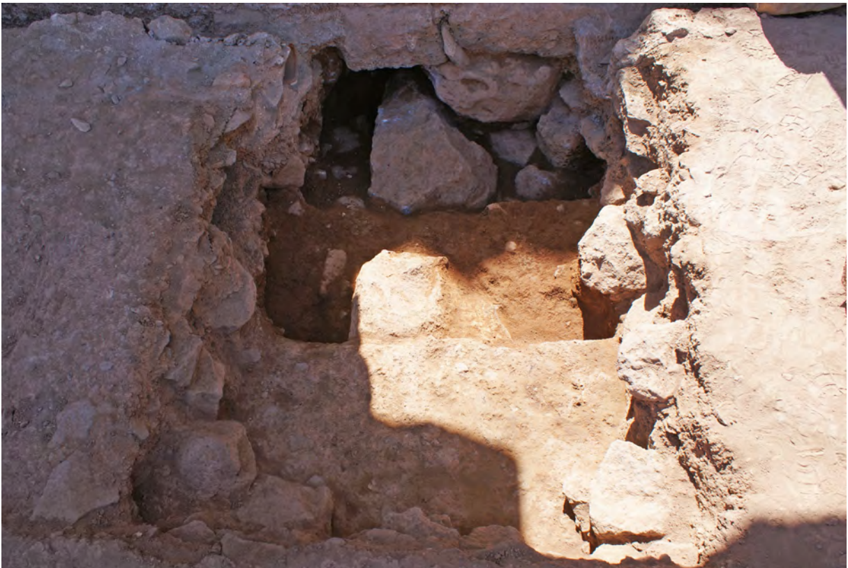
Ph. 141. Le « Palais de Trajan ». Sondage 2400. Fondation de la façade sud sur cour
