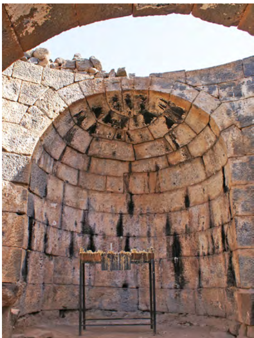
Ph. 199. Qanawat, le « Sérail ». Cul- de-four appareillé dans le triconque
