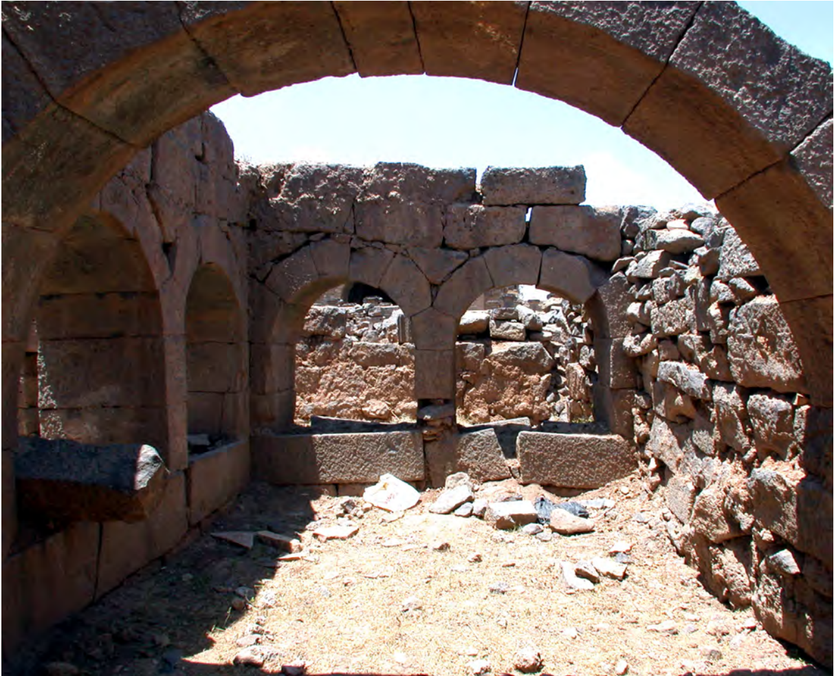
Ph. 5. Bosra, salle à auges à l'est des thermes du Sud (MAFSS 2003)
