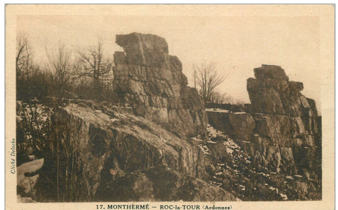
Figure 59 : Carte postale ancienne du site de Roc-la-Tour.
