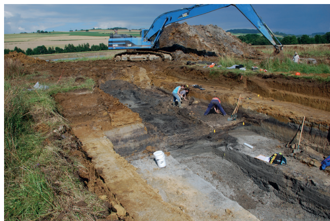
Figure 66 : Fouille mécanisée en larges sondages. H.G. Naton, 2012
