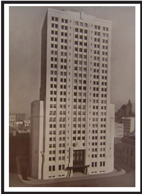
Photo du ministère des Travaux Publics.
