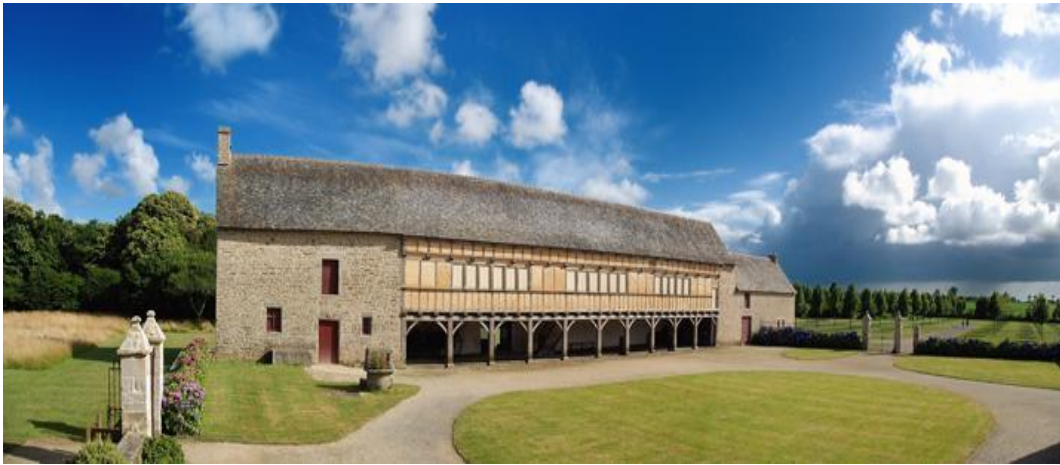
Figure 3 : Le grenier en pans de bois du manoir de Kernault à Mellac
