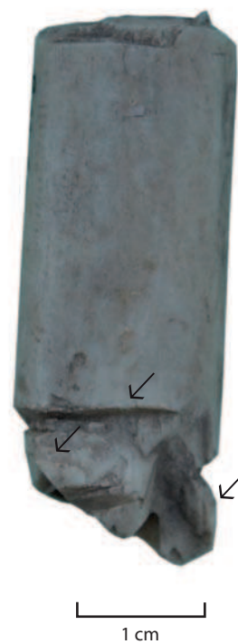
Figure 69 : Pans de fracture visibles sur un battant de cloche.
