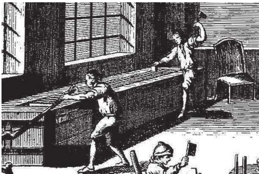
Figure 302 : L'Encyclopédie, Tabletier, Cornetier , ouvriers utilisant une presse à vis, XVIII e siècle, France (Diderot et d'Alembert 1762-1772, vol. 8, pl. 1).
