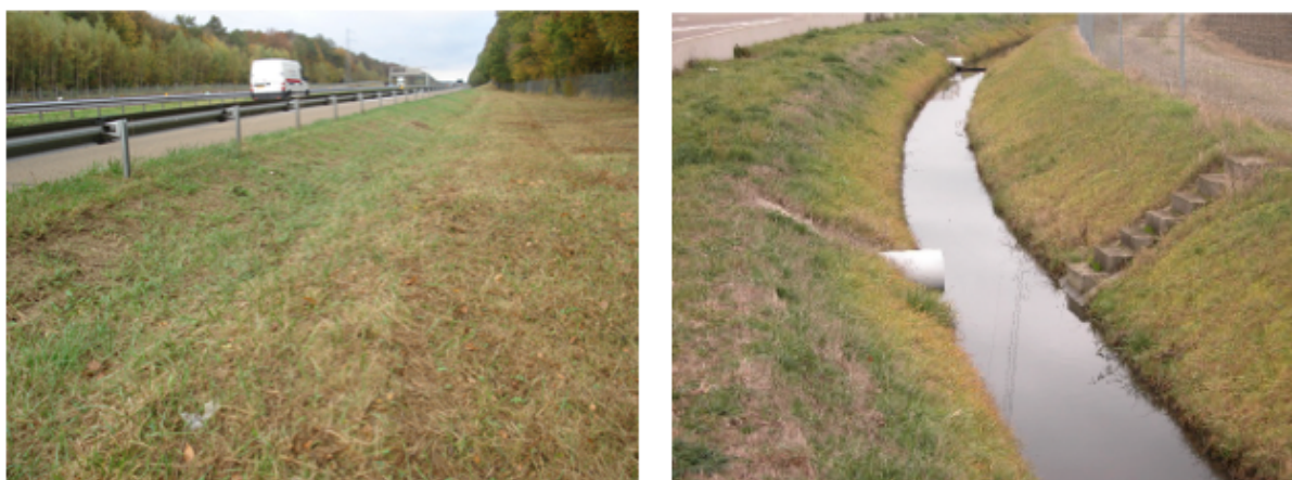
Figure 5 : Fossé enherbé (g.) et bief de confinement (d.) autoroutiers
