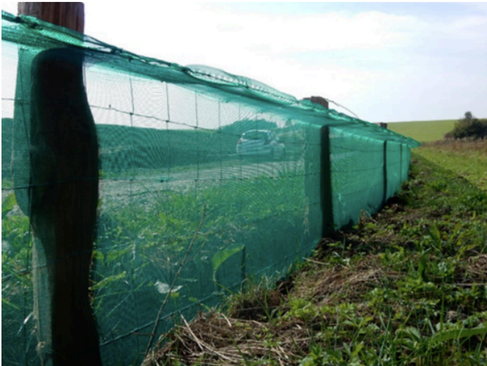
Figure 29 : Filet temporaire de protection des chantiers contre la petite faune et équipé de bavolets.
