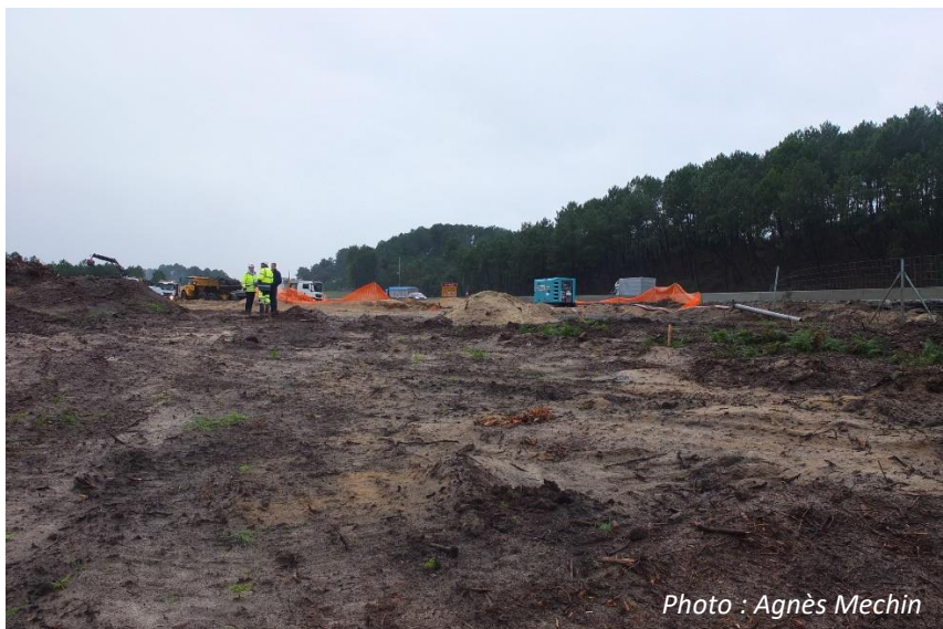
Photo : Agnès Mechin Figure 52 : Emprise de l'élargissement d'autoroute - ZH 5
