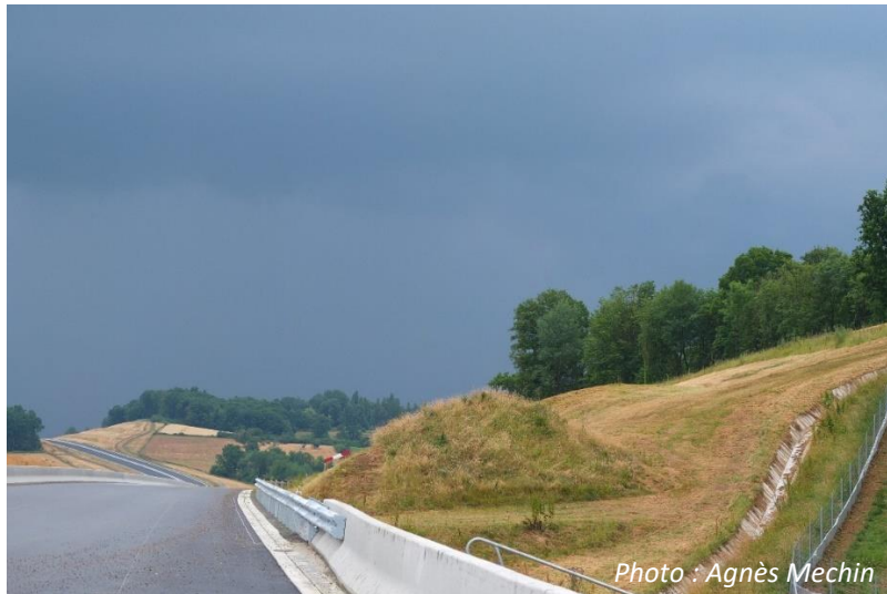
Figure 22 : Projet construction d'autoroute
