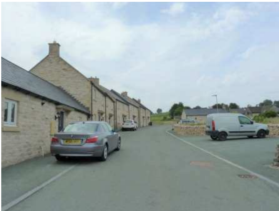
Photographie(s) 80 : Le projet réalisé par le YCLT : 8 nouvelles habitations dans la conservation area de Youlgreave.
