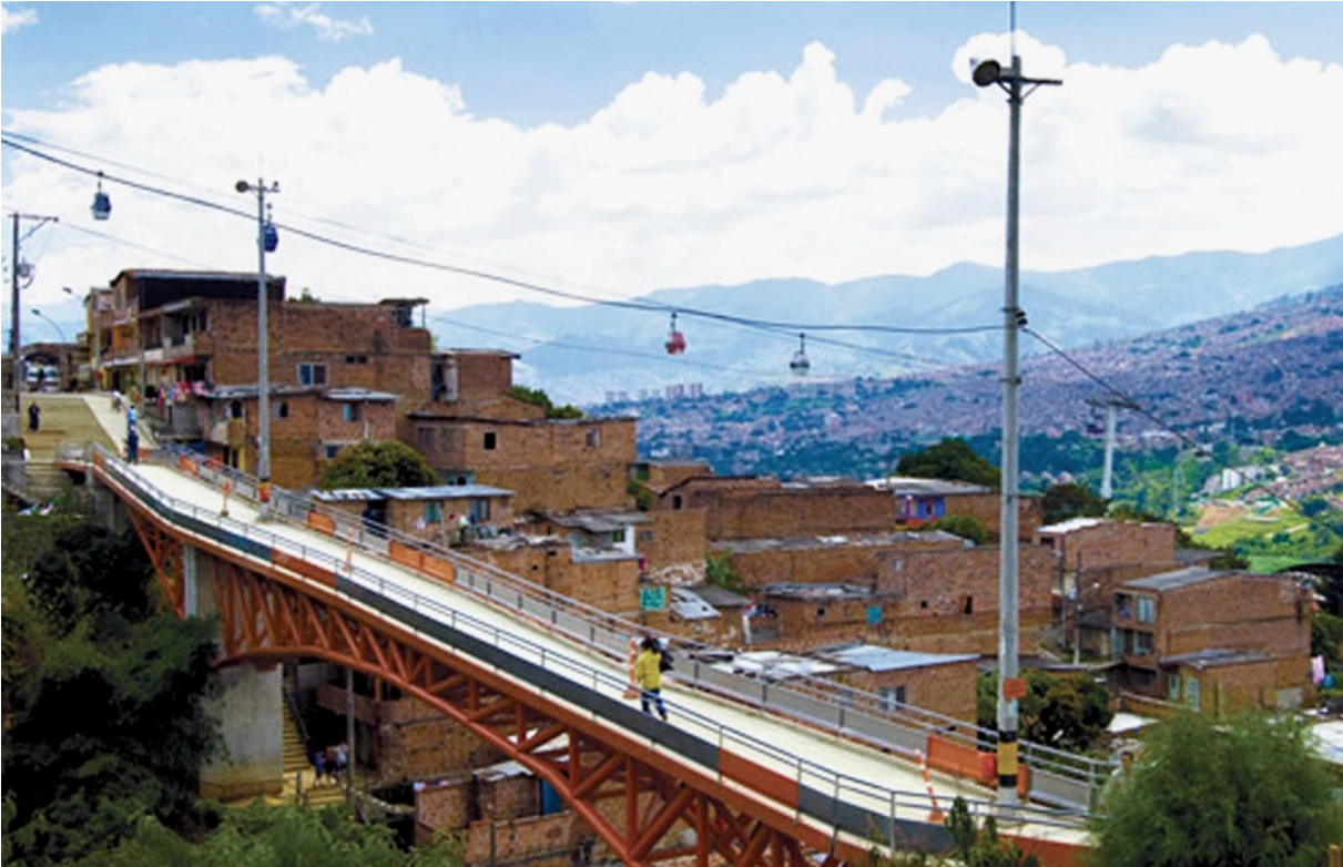
Figure 48 : Pont El Mirador du PUI de la Zone Nord-Est, comuna 2, Medellín. Source : Google Images, 2014.
