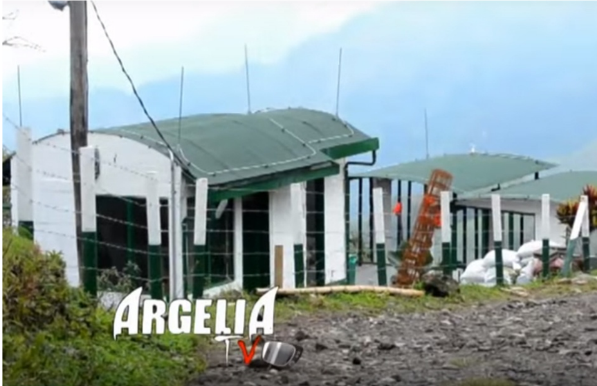
Figure 32 : Téléphérique d'Argelia, station, Antioquia.
