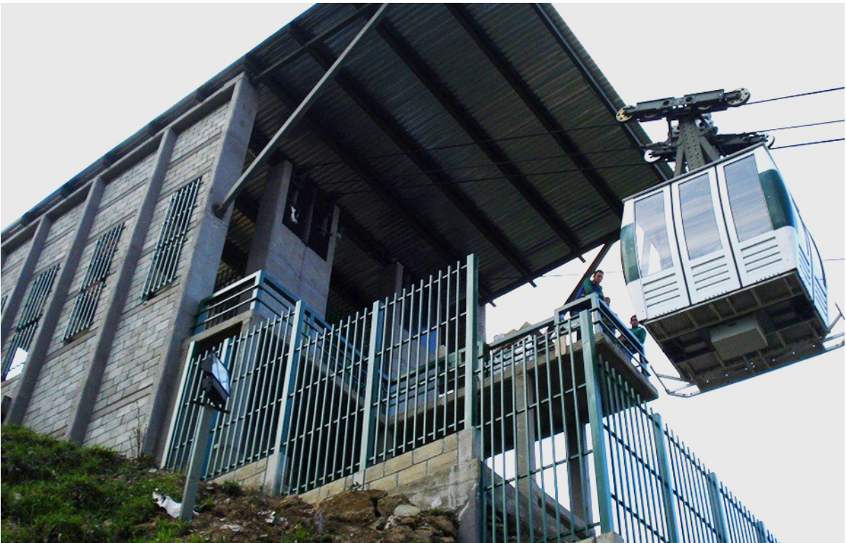
Figure 31 : Téléphérique de Yarumal, station El Llano, Antioquia (2). Source : Remontées mécaniques, 2013.
