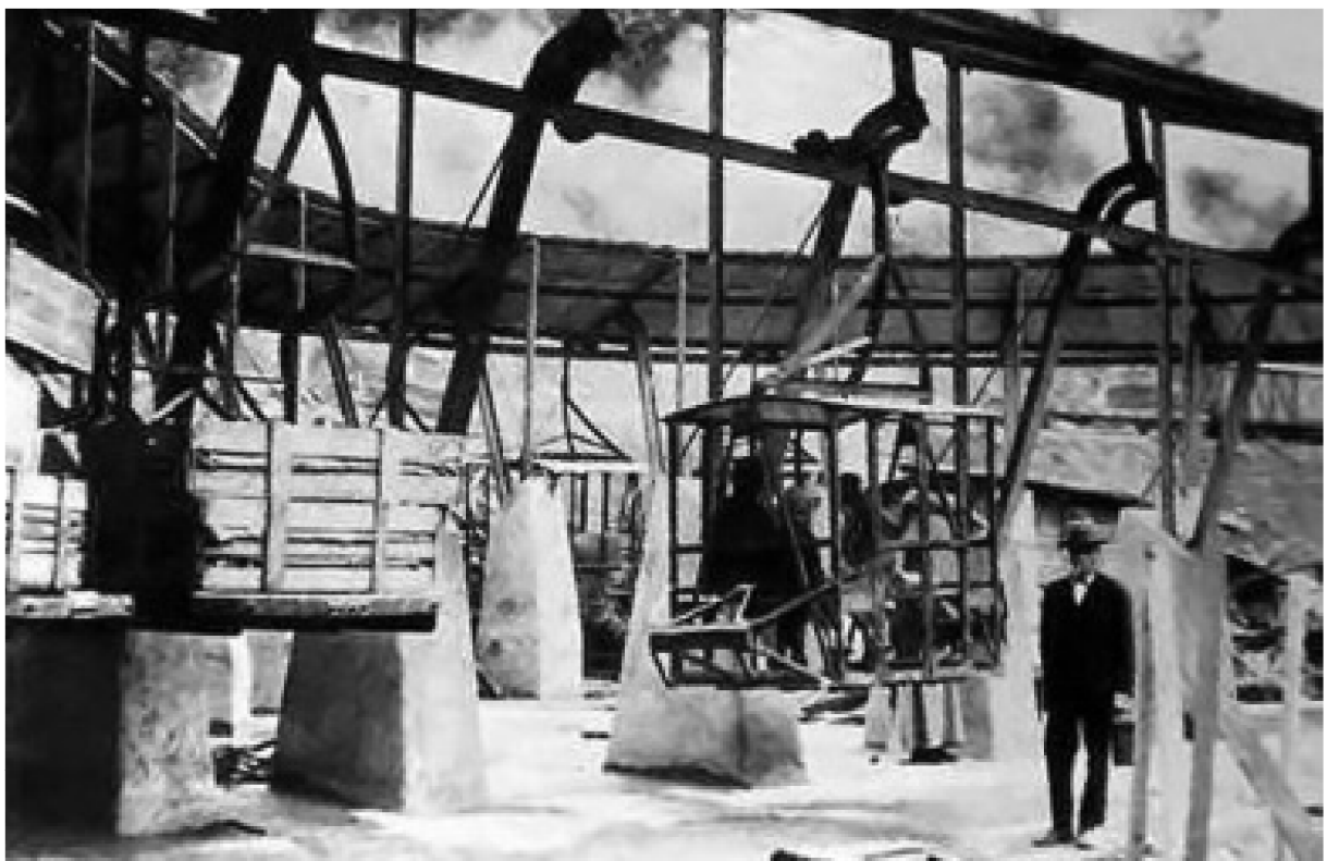
Figure 19 : Cabine du téléphérique Manizales-Aranzazu, (circa) 1928. Source : Remontées mécaniques, 2016.
