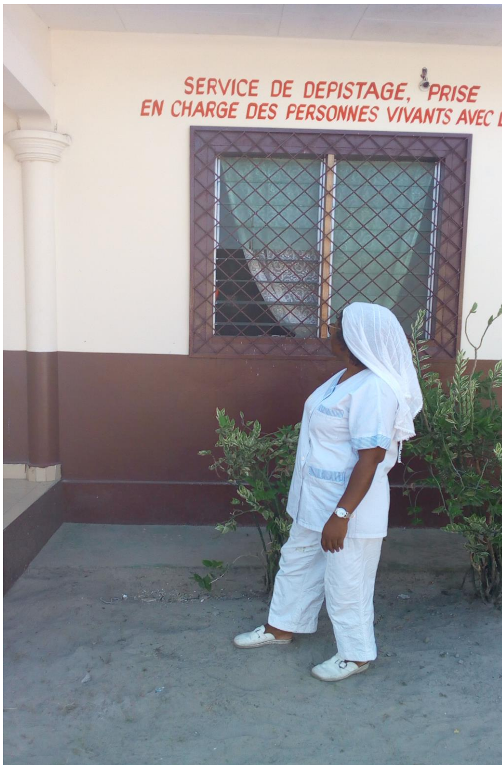
Photo 13 : État du bâtiment du Centre de prise en charge des PVVIH Mpaka
