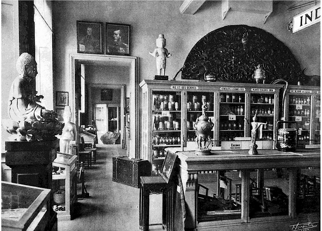
Fig. 27 : La salle de l'Indochine du second musée colonial de la Chambre de Commerce (Source : Chambre de Commerce de Lyon, non daté, « Inauguration des nouveaux services et du médaillon du Président Celle. 22 octobre 1934 », 46 p., Imprimerie Rey, planche hors-texte)
