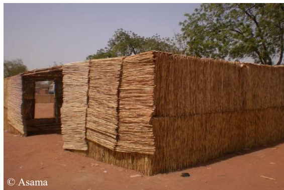
Espace clôturé montrant l'entrée où sera installé le service de billetterie.
