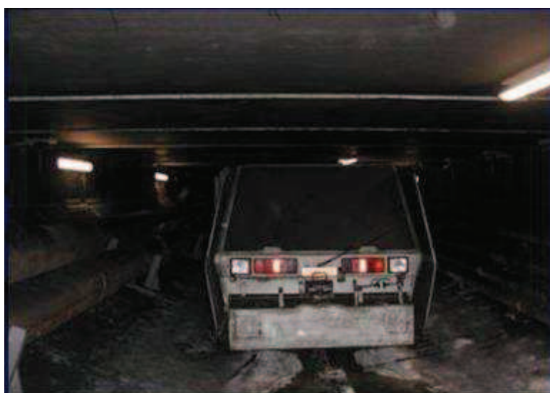
Figure 92 - Vue arrière de la tractrice amenant les voussoirs pour consolider le forage.
