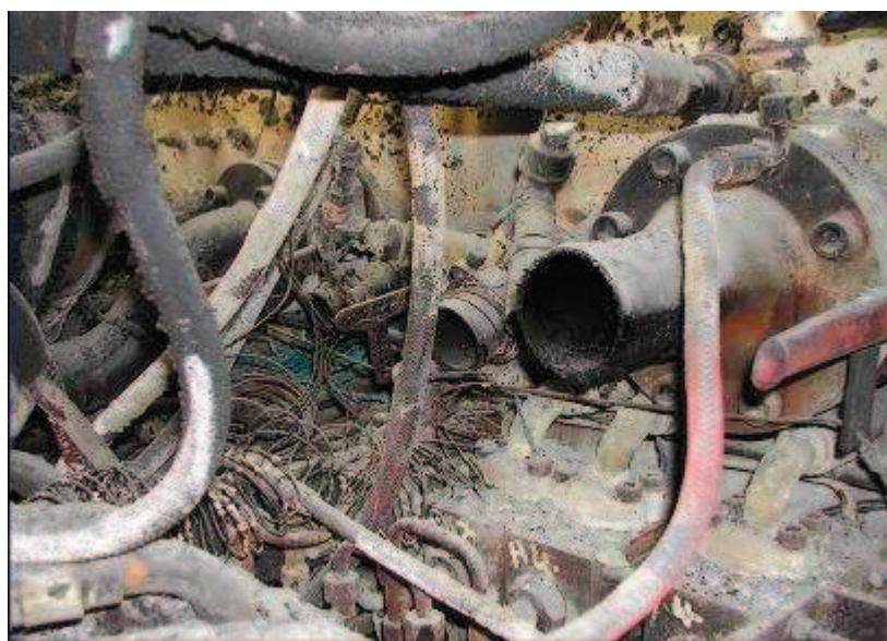
Figure 96 - Etat des canalisations situées sous le réservoir d'huile.
