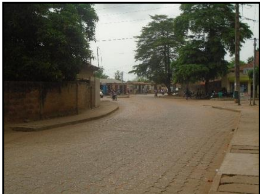
Photo 54 : Principale voie de Ouidah à hauteur du quartier Ahouandjigo
