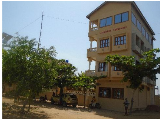
Photo 24 : Hôtel de construction type moderne à Grand-Popo
