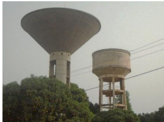
Photo 9 : Châteaux d'eau à Ouidah
