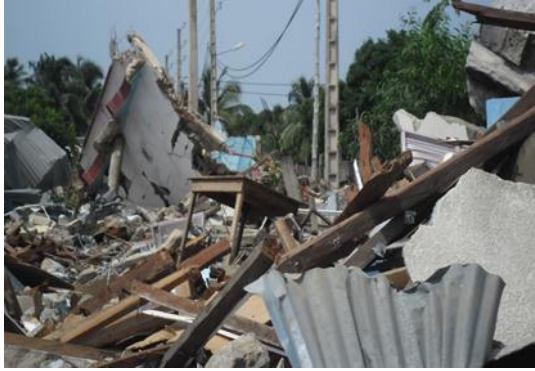
Photo 68 : Amas de gravats, résultant de la destruction d'habitations pour cause de conflit foncier
