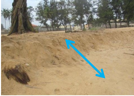
Photo 74: Forme de terrassement
