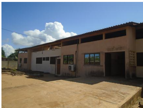
Photo 13 : Centre de santé de Grand-Popo
