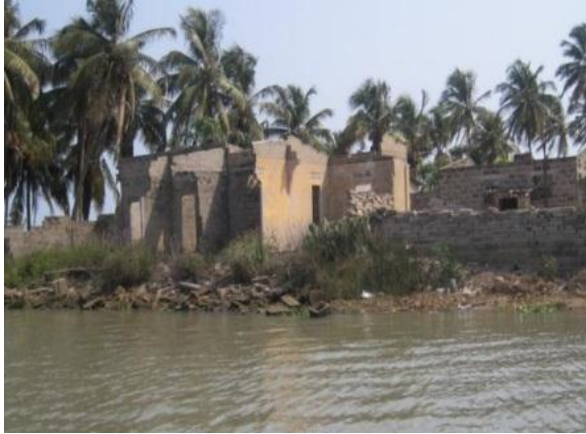
Photo 81 : Aperçu d'habitations effondrées
