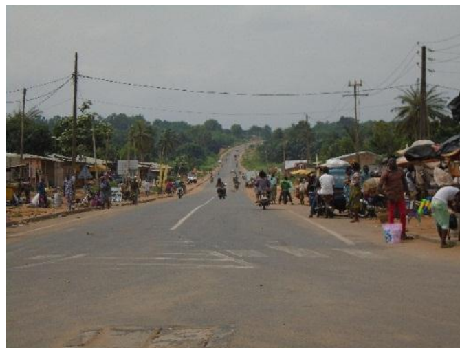
Photo 60 : Etat actuel de la voie d'accès au séminaire Saint Gall de Ouidah.
