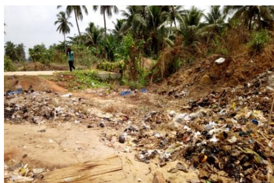
Photo 99 : Exutoire du collecteur C2 (bas fond Docomey)
