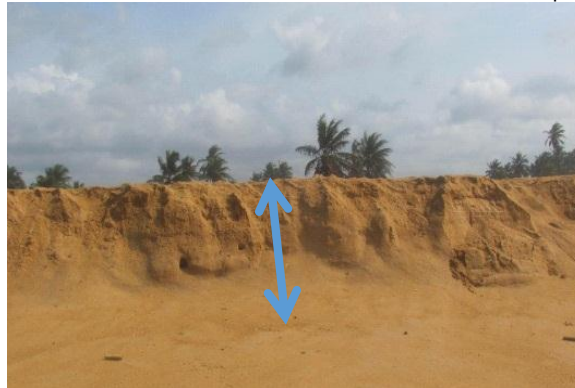
Photo 76: Forme d'effondrement de sable
