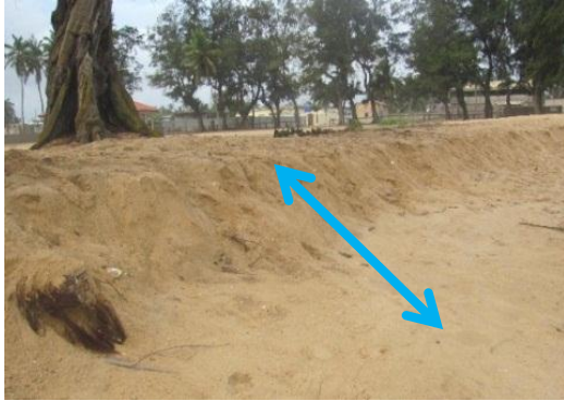
Photo 74: Forme de terrassement
