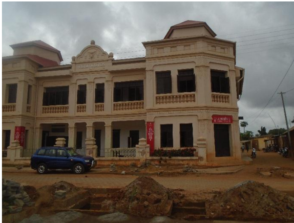
Photo 25 Habitation de type afro-brésilien à Fonsramê dans la ville de Ouidah
