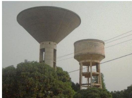
Photo 9 : Châteaux d'eau à Ouidah
