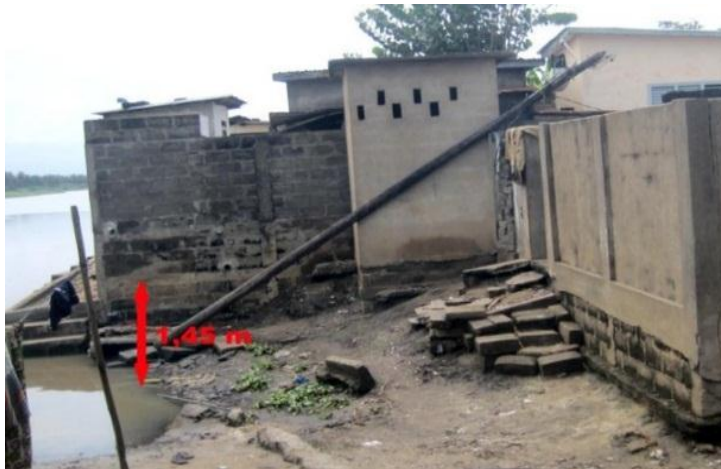
Photo 80 : Aperçu d'une habitation déchaussée à Hounsoukouè (Grand-Popo) Prise de vue : Dansou, Septembre 2016
