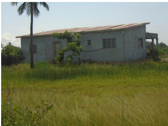
Photo 66 : Installation humaine dans la zone non aedificandi dans le quartier de Onkuihoué dans la ville de Grand-Popo
