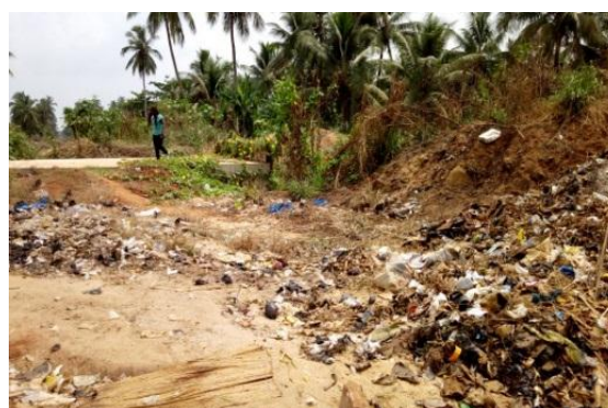
Photo 99 : Exutoire du collecteur C2 (bas fond Docomey)
