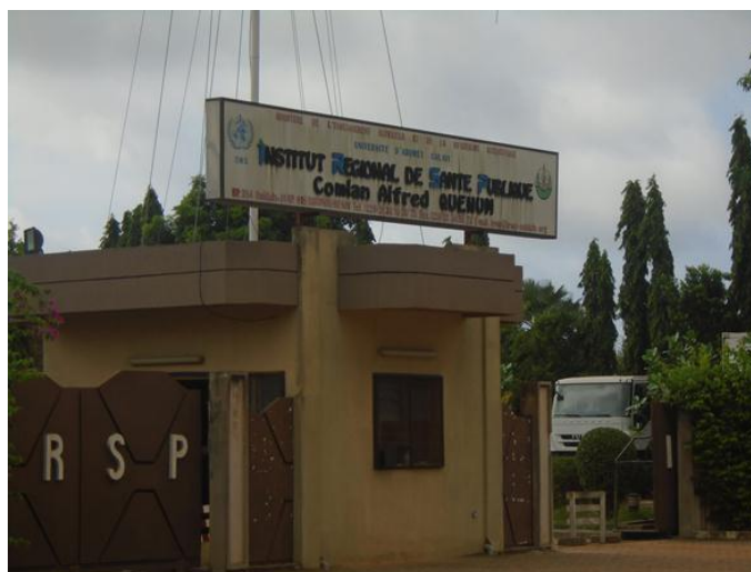
Photo 59 : Vue partielle de l'entrée principale de l'Institut Régional de Santé Publique Comlan Alfred Quenum à Ouidah
