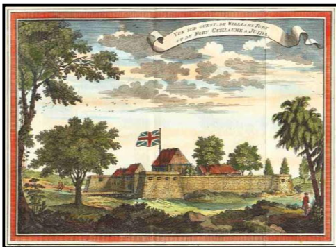
Photo 37: Levé du fort Anglais à Dangbèhouè
