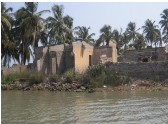
Photo 81 : Aperçu d'habitations effondrées
