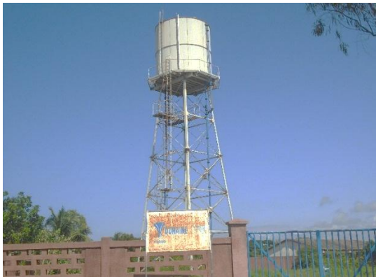
Photo 8 : Château d'eau à Grand-Popo
