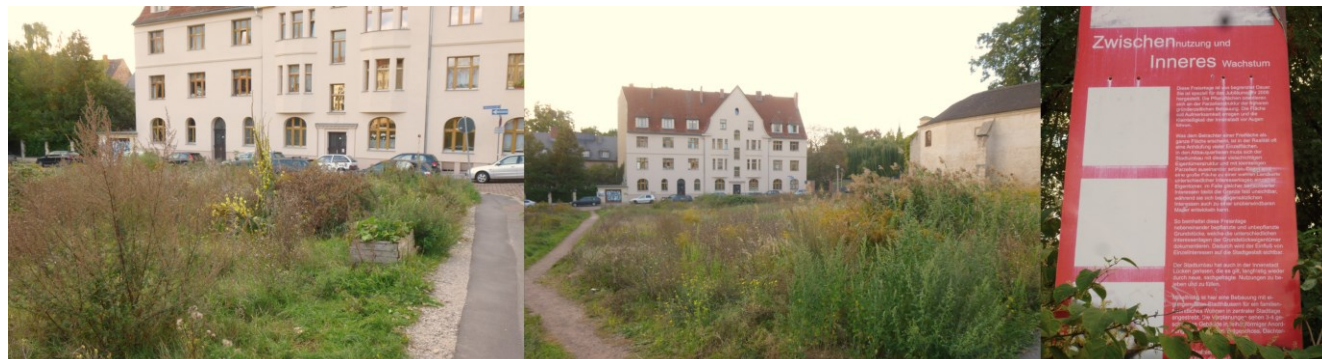
Photo 13 : Les vestiges d'une ZN mise en place dans le cadre de l'IBA dans le centre-ville de Halle, octobre 2015
