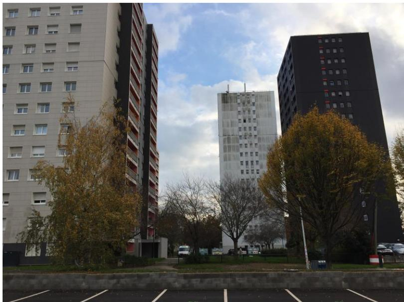
**9** | **Le Blosne (Kühl, 2020).** En parallèle des nouvelles constructions, une partie des tours est également rénovée à travers notamment des travaux d'isolation par l'extérieur. C'est le cas des tours qui sont visibles sur cette photographie. Ici, il n'était pas question de restructuration interne lourde comme sur les tours de Maurepas.
